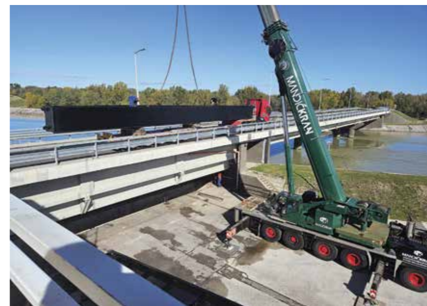
↑ Doprema obnovljenih pomoćnih zatvarača preljevnih polja u HE Čakovec
