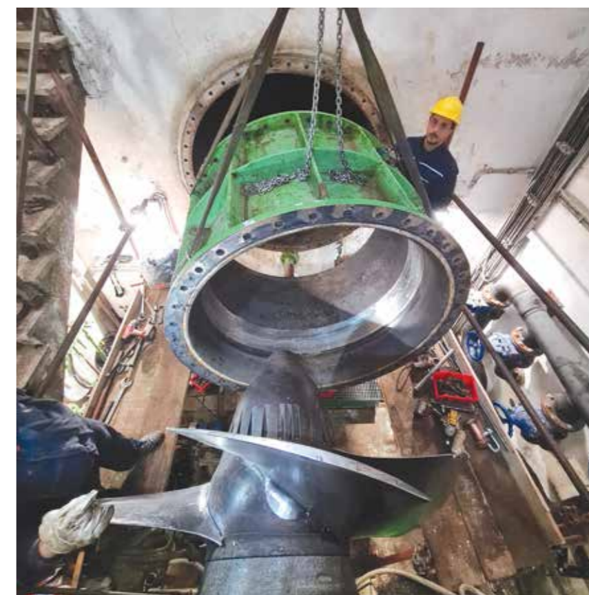
↑ Demontažni radovi na remontu agregata C u HE Čakovec
