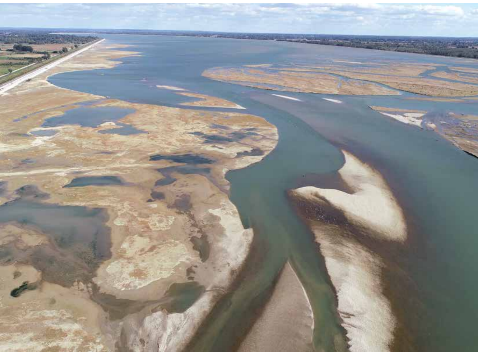
↑ Radi pregleda i sanacije asfaltne obloge snižen je vodostaj u akumulacijskom jezeru Hidroelektrane Dubrava
