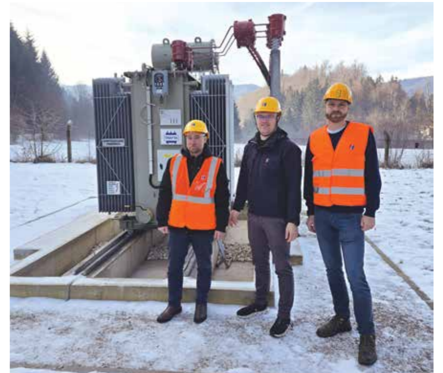
↑ Ugradnja prigušnica je ključan iskorak u modernizaciji mreže u Gorskom kotaru
