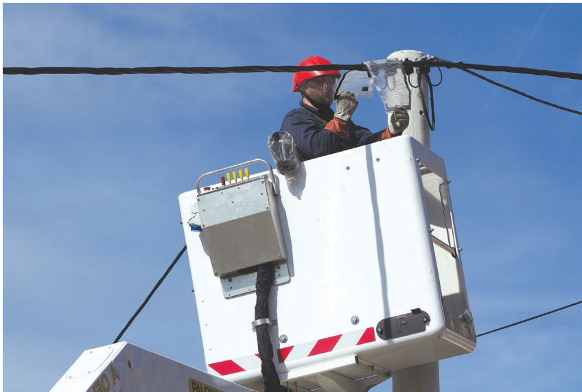
↑ Radnik Elektre Zabok postavlja zaštitu za rad pod naponom
