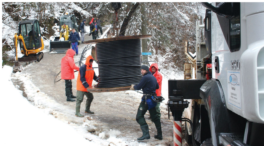
↑ Interventna obnova mreže provodila se u iznimno nepovoljnim i riskantnim okolnostima
