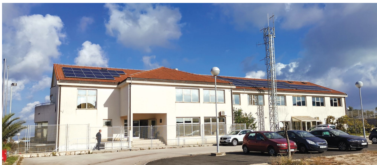
↑ Sunčana elektrana na objektu u Malom Lošinj
