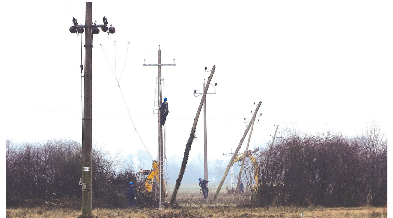
↑ Terenska jedinica Ozalj DP Elektra Karlovac obavlja zamjenu stupova na 10(20)kV dalekovodu Ozalj - Zorkovac
