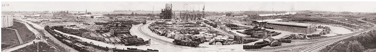
↑ Izgradnja prvog bloka na sisačkoj lokaciji
