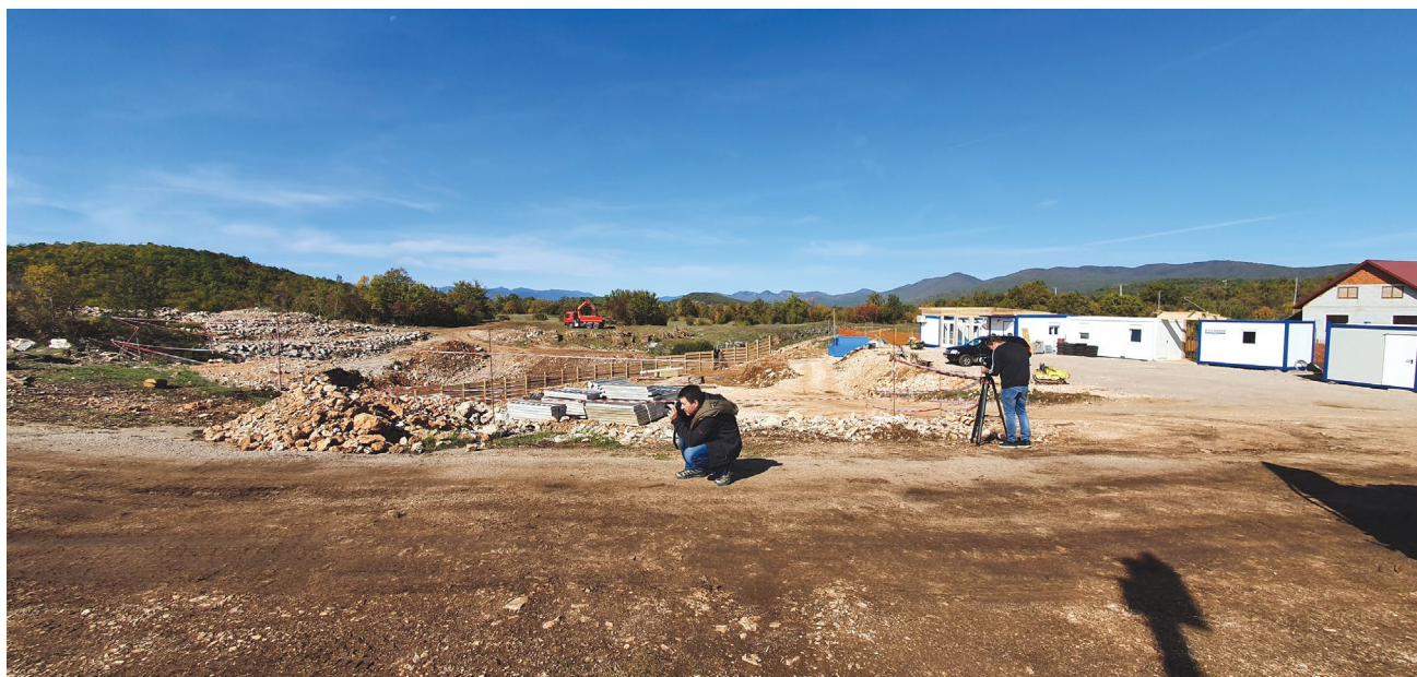
↑ Aktivnosti na izgradnji ceste od naselja Studenci do postojeće Hidroelektrane Sklope.
