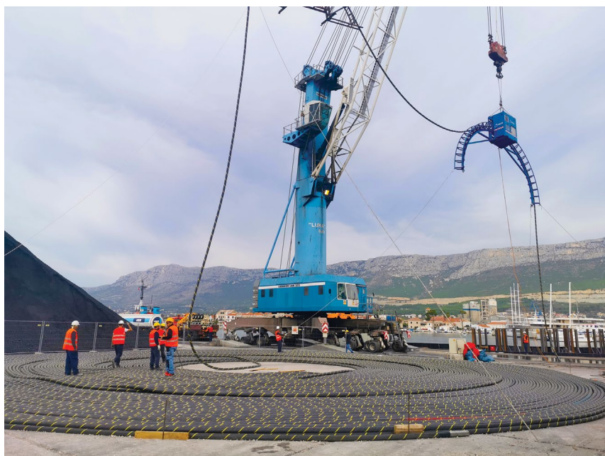
↑ Za premoćavanje kabela s kopna (sjeverne luke Split) na brod polagač koristila su se dva stroja. Na 500-tonskoj dizalici visi upravljivi stroj za okomito premoćavanje.
