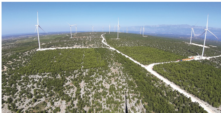
↑ Završena je izgradnja 18 vjetroagregata, priključnog dalekovoda, transformatorske stanice i ostalih infrastrukturnih sustava prve HEP-ove vjetroelektrane.
