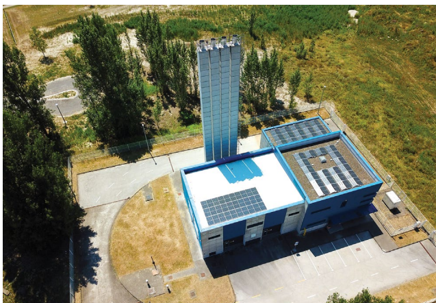
↑ Kotlovnica Tehnostana na lokaciji Olajnica
