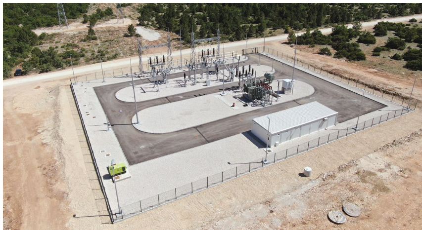
↑ Na prostoru transformatorske stanice završeni su svi građevinski i elektromontajni radovi.
