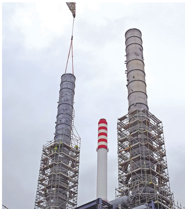
↑ Dimnjaci visoki 60 metara postavljeni su dizalicom nosivosti 500 tona
