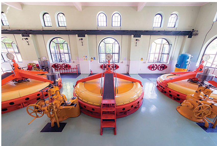
↑ U obnovi će se zadržati izvorni izgled strojarnice
