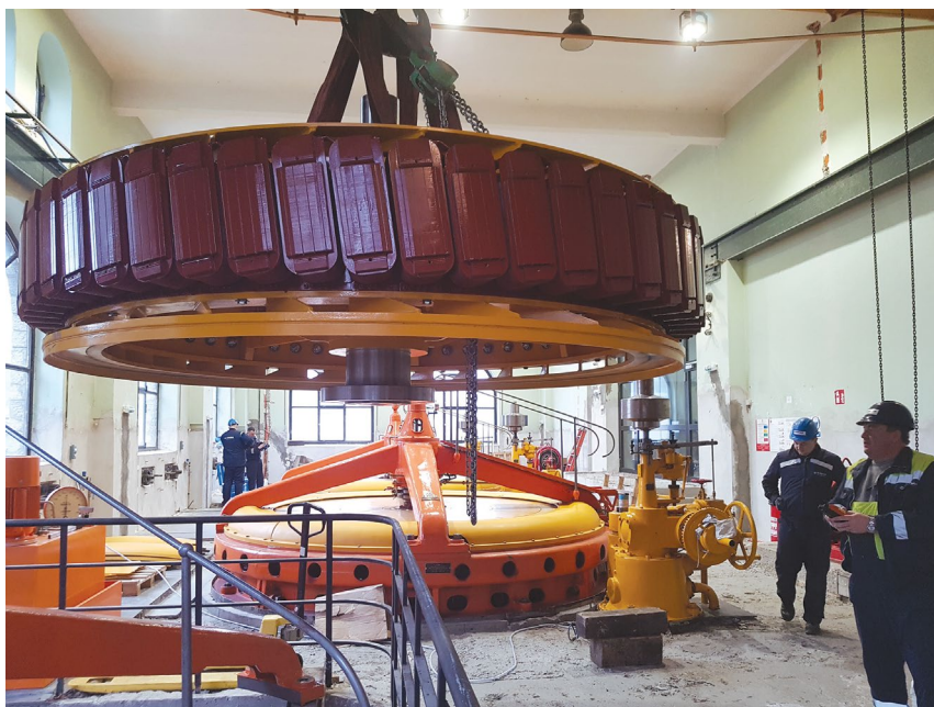
↑ Generatori su zamijenjeni uz zadržavanje kućišta statora
