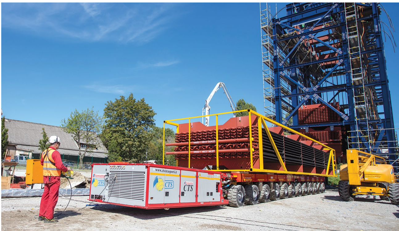
↑ Za prijevoz i ugradnju dijelova kotlova bilo je potrebno specijalno vozilo
