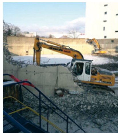
Uklanjanje armirano-betonskog obrambenog zida oko čeličnog spremnika i podnog opločenja
