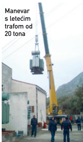
Manipulacija novim transformatorom na malom prostoru
