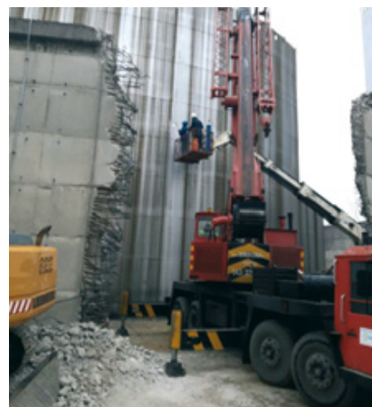
Auto-dizalica i teleskopski viljuškar omogućuju radnicima pristup čeličnom plaštu spremnika i započinjanje rezanja
