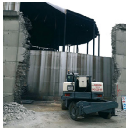
Uklanjanje čelične konstrukcije izvodilo se po fazama: dio čeličnog plašta spremnika, zatim čelična konstrukcija krova te zadnje stupovi
