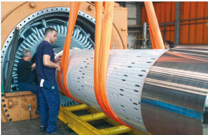
Pripreme rotora i specijalne metalne naprave za uvlačenje rotora u stator generatora Bloka C
