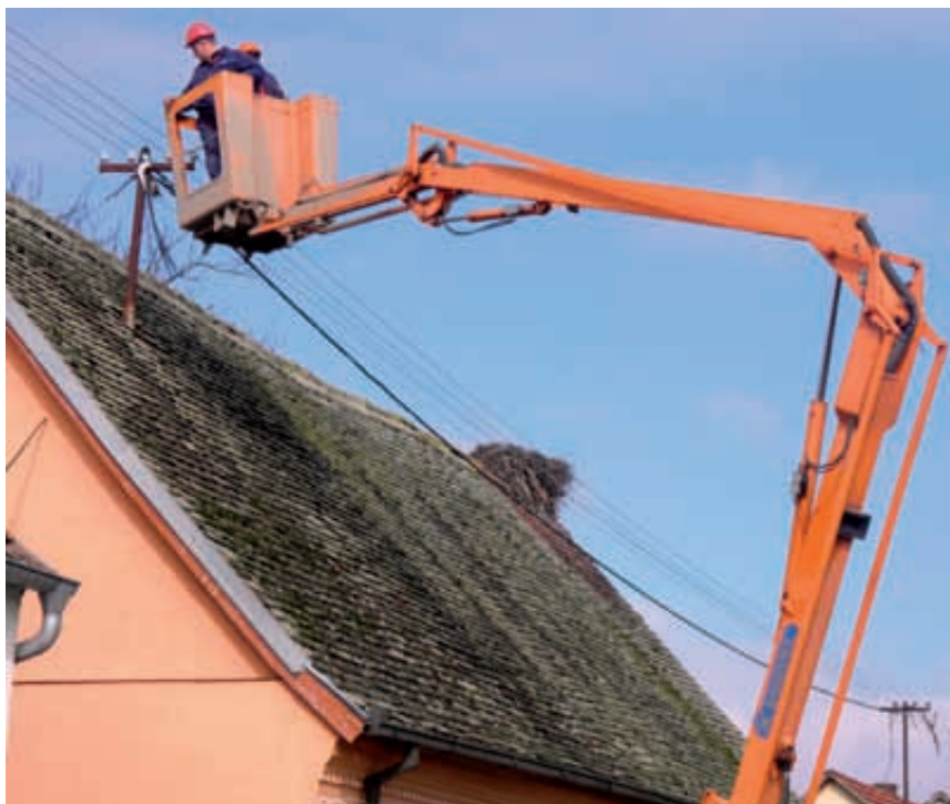
Neizolirane vodiče, koji ugrožavaju rodino gnijezdo u slučaju istodobnog dodirivanja dva vodiča, zaposlenici Pogona Županja Elektre Vinkovci zamijenili su novim izoliranim i odmaknuli od gnijezda te, prije nego se rode vrate, otklonili opasnost za njihov život
