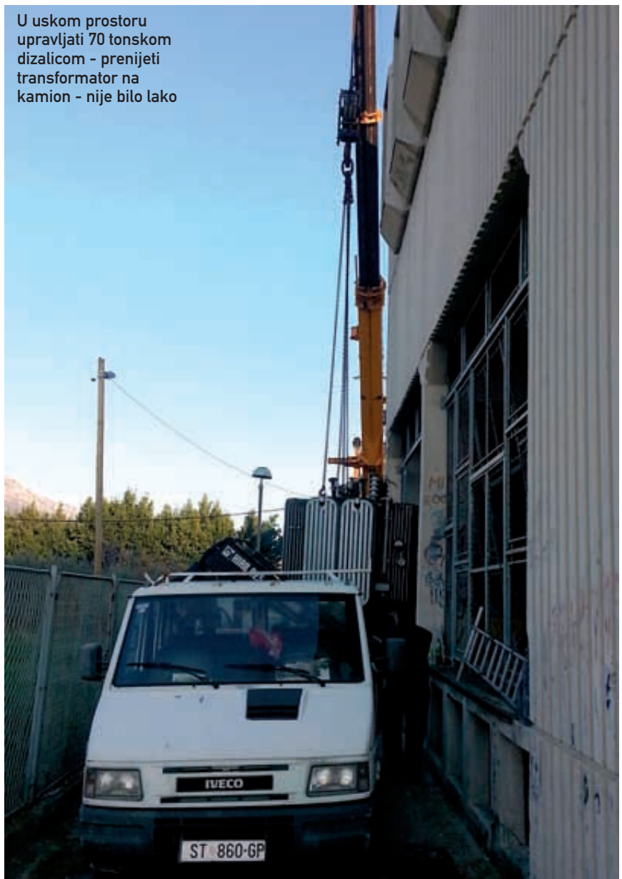
Transformator od 17,5 tona napušta svoje mjesto
