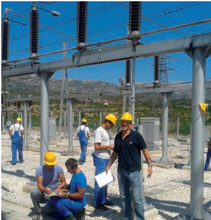
Izgradnja dalekovodnog polja Zelengrad – uklopničar Oliver Petrić uz zaposlenike dakovačke tvrtke Tehno Elektro
