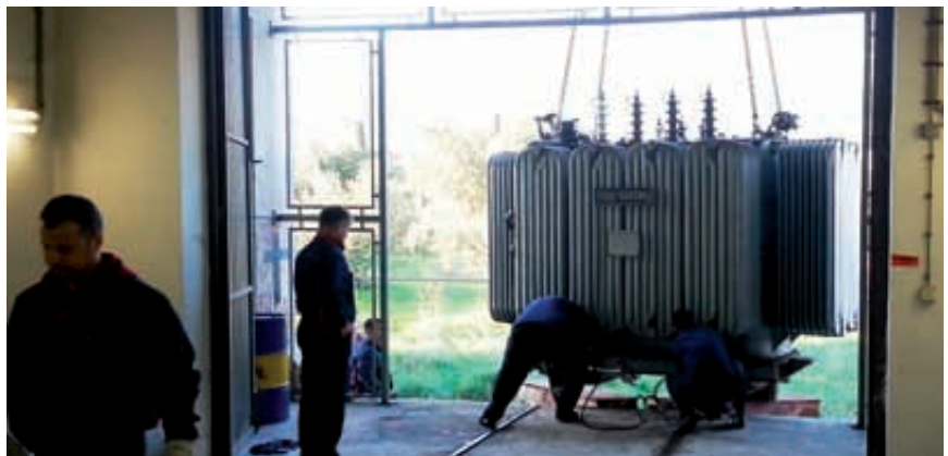
Transformator od 17,5 tona napušta svoje mjesto
