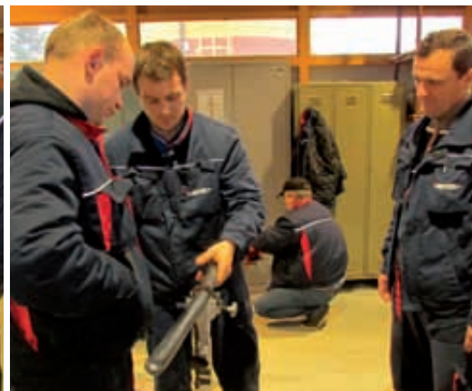
Karlo Perković, Ivan Miličić i Željko Korov iz Pogona Donji Miholjac rade na pripremi 20 kV kabela za izradu kabelaškog završetka
