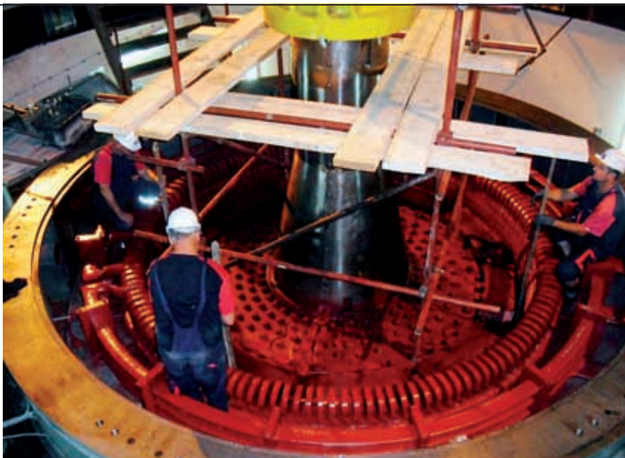
Montaža rotora motor-generatora nakon popravka polova
