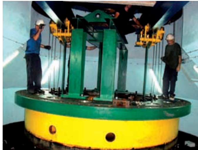
Demontaža poklopca crpke-turbine...
