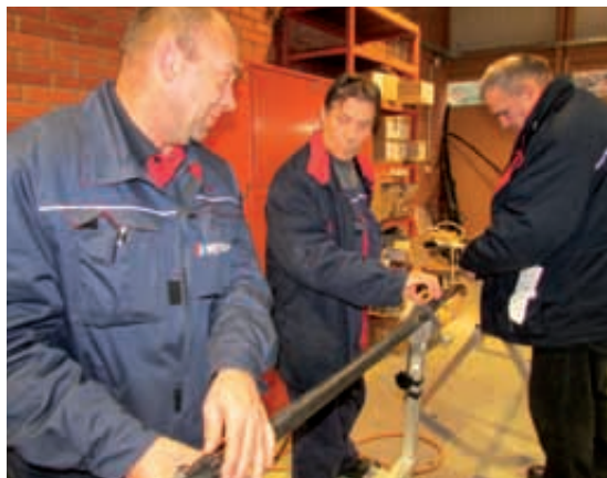
Jožef Kišurek, Zvonko Veličković i Milan Mehak iz Službe za održavanje Elektroslavonije, pripremaju srednjonaponski kabel za spojnicu
