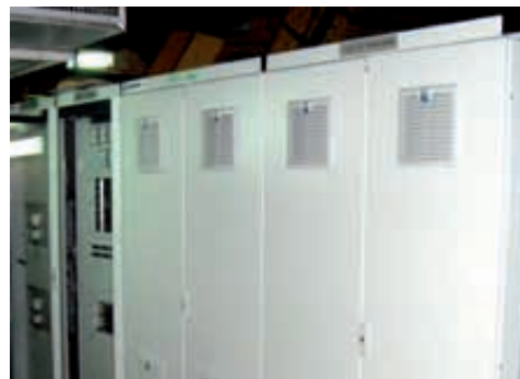
Ormari novog sustava uzbude MG2
