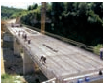
Uz most Ribnjak duljine 92 metara, izgradit će se dodatnih 700 metara ceste
