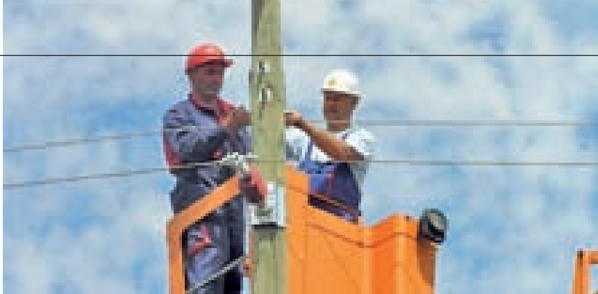
Monteri Goran Rudić iz Poslovnice Posedarje i Igor Mršić iz Poslovnice Starigrad ugrađuju kompozitne linijske izolatore
