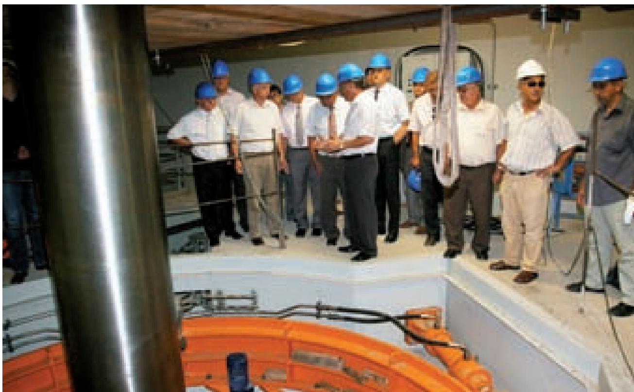
U strojarnici - srcu postrojenja, župan Ivan Vučić i njegovi suradnici susreli su se i upoznali s vitalnim dijelovima HE Lešće te razgledali unutrašnjost agregata
