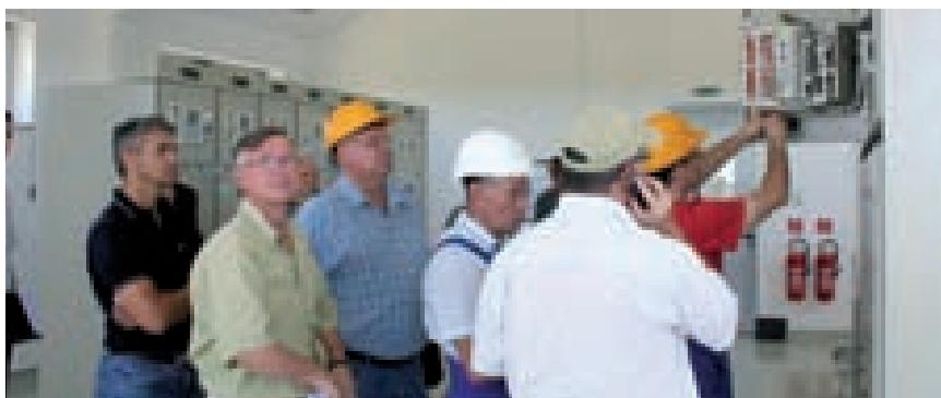
... posljednja kontrola ekipe Elektroslavonije uoči puštanja u pogon
