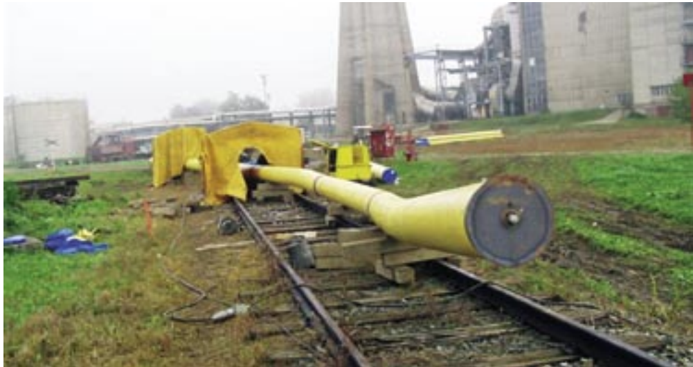
Radovi na plinovodu započeli su u rujnu prošle godine
