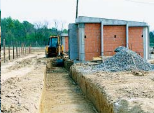
U tijeku je iskop kablskog kanala u 220 kV postrojenju
