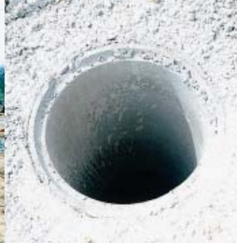
Na prometnicama se izrađuju slivnici
