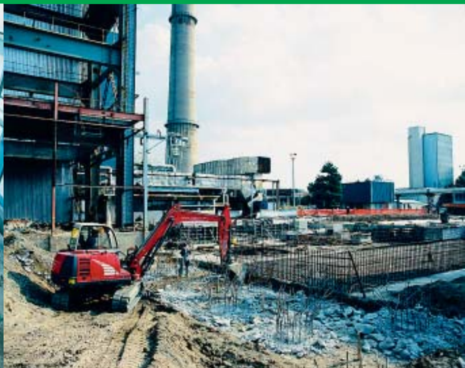
Temelji za strojarnicu plinske turbine
