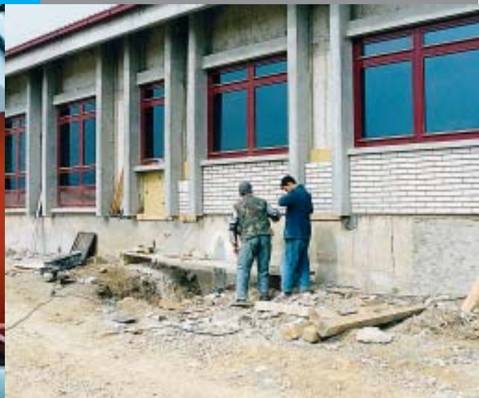
Započelo je postavljanje fasadne opeke na zgradi upravljanja i pomoćnih pogona
