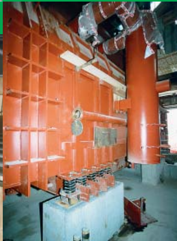
Kondenzator u montaži
