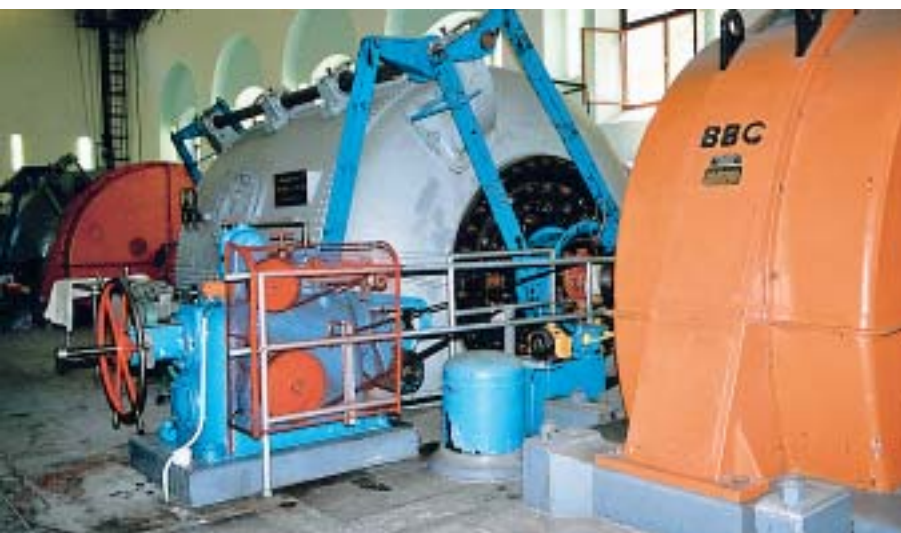
Stari regulator s volanom za ručno pokretanje sada je tek izložbeni eksponat. U njegovom susjedstvu je generator koji očekuje namotavanje i povećanje snage tijekom ljeta
