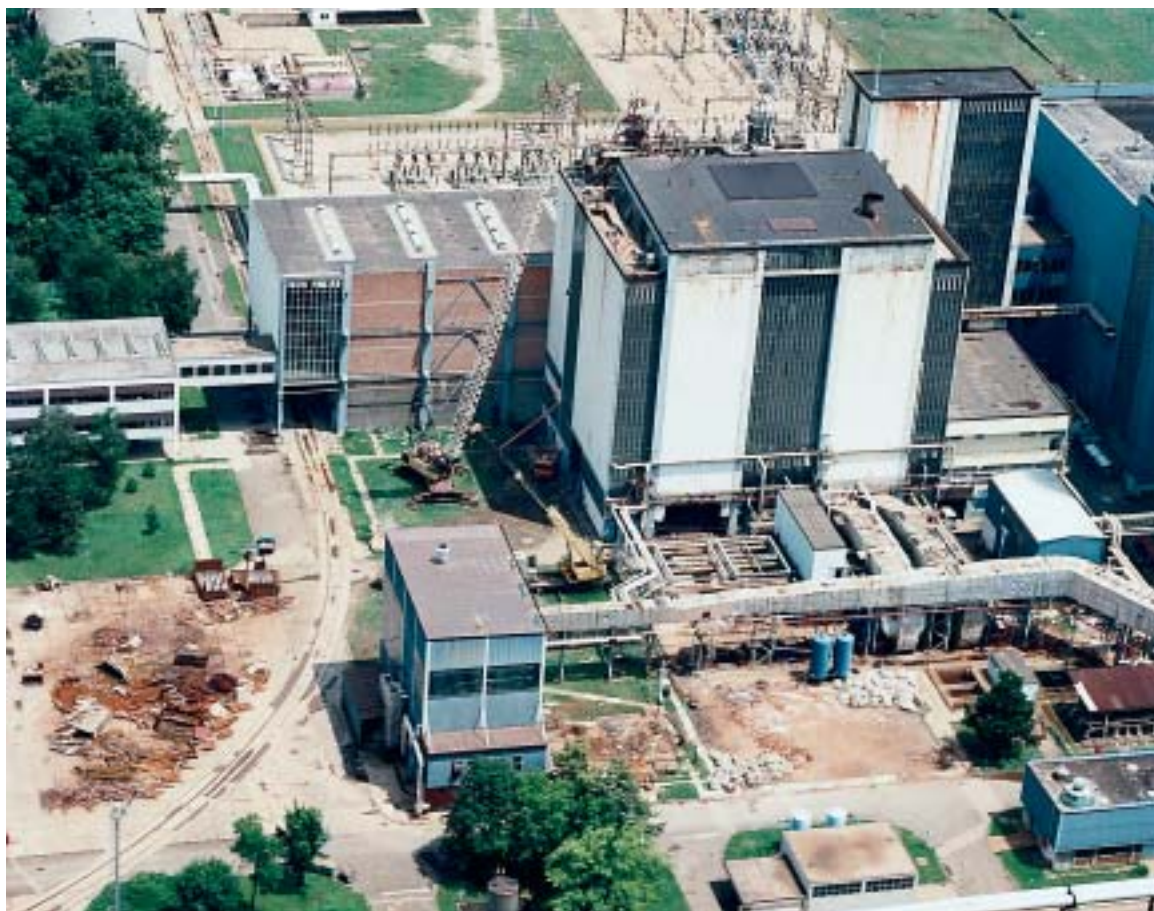
Početak srpnja 1998. godine, krug TE-TO prima demontirane dijelove starog postrojenja
