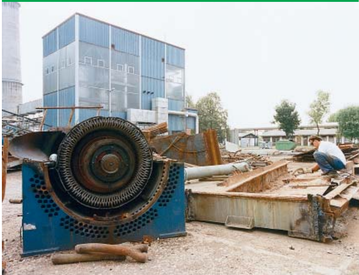
Režu se i dijelovi starog rotora ventilatora
