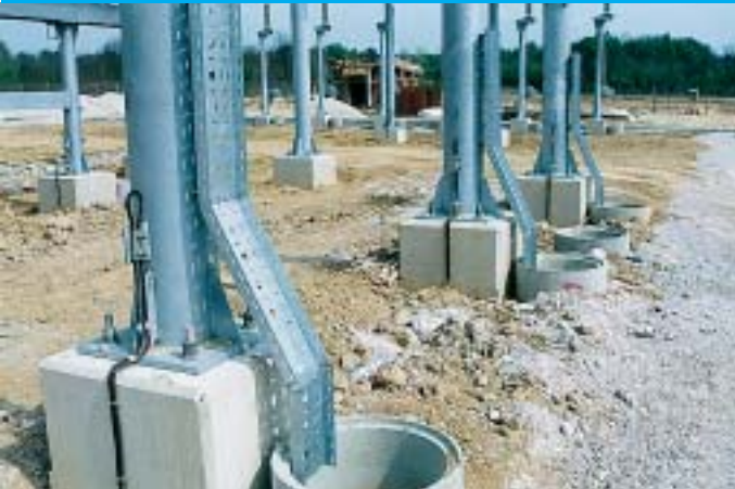
Postavljene su metalne police za vođenje kabela od aparata do okana kablanske kanalizacije, ove šire i ...
