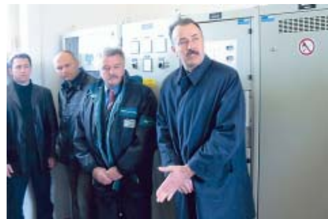
Direktor DP Elektroistra Pula Davor Mišković prigodom puštanja u rad rasklopišta Peruški - konačno priključenog CDU Pula
