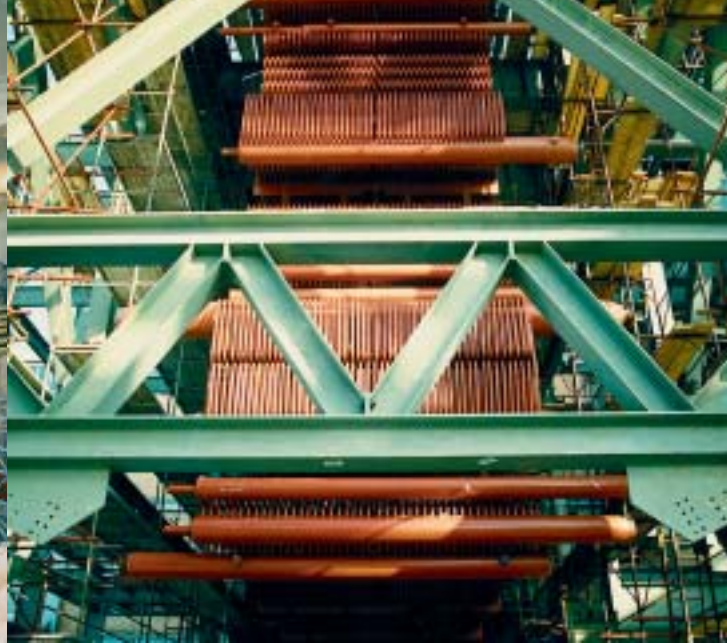
Uvlačenje elemenata kotla na otpadnu toplinu
