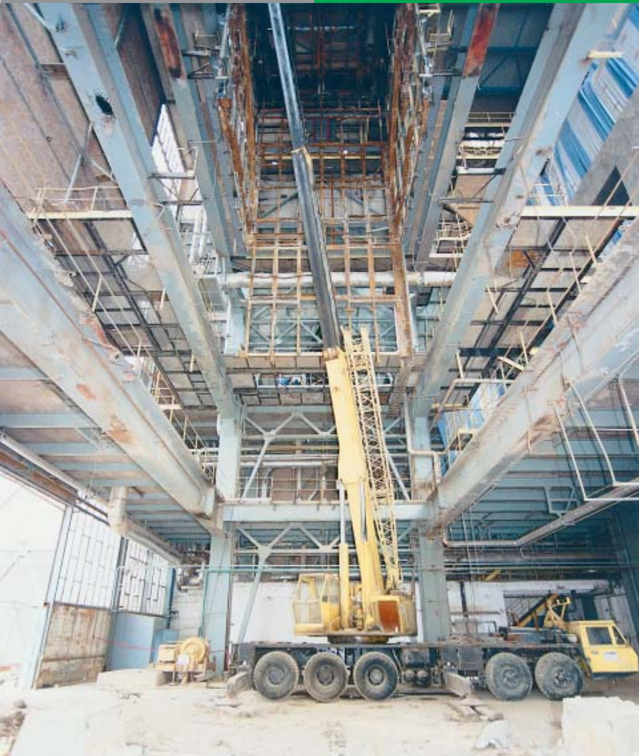
Ruši se zid i skidaju se dijelovi starog postrojenja
