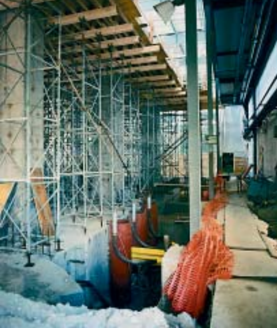
Ugradnja prvih dijelova tripumpe kondenzata
