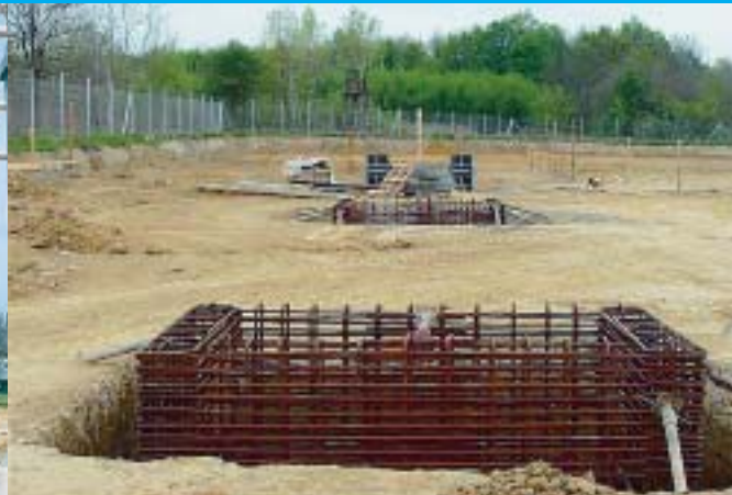
Započela je izrada temelja portala u postrojenju 220 kV
