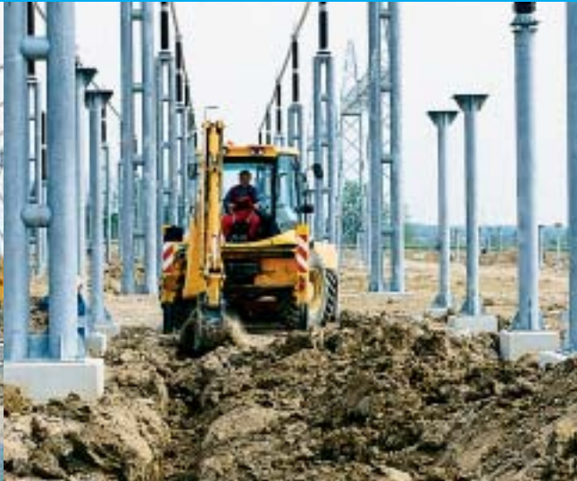
U tijeku su i radovi na iskopu za uzemljivač i ...
