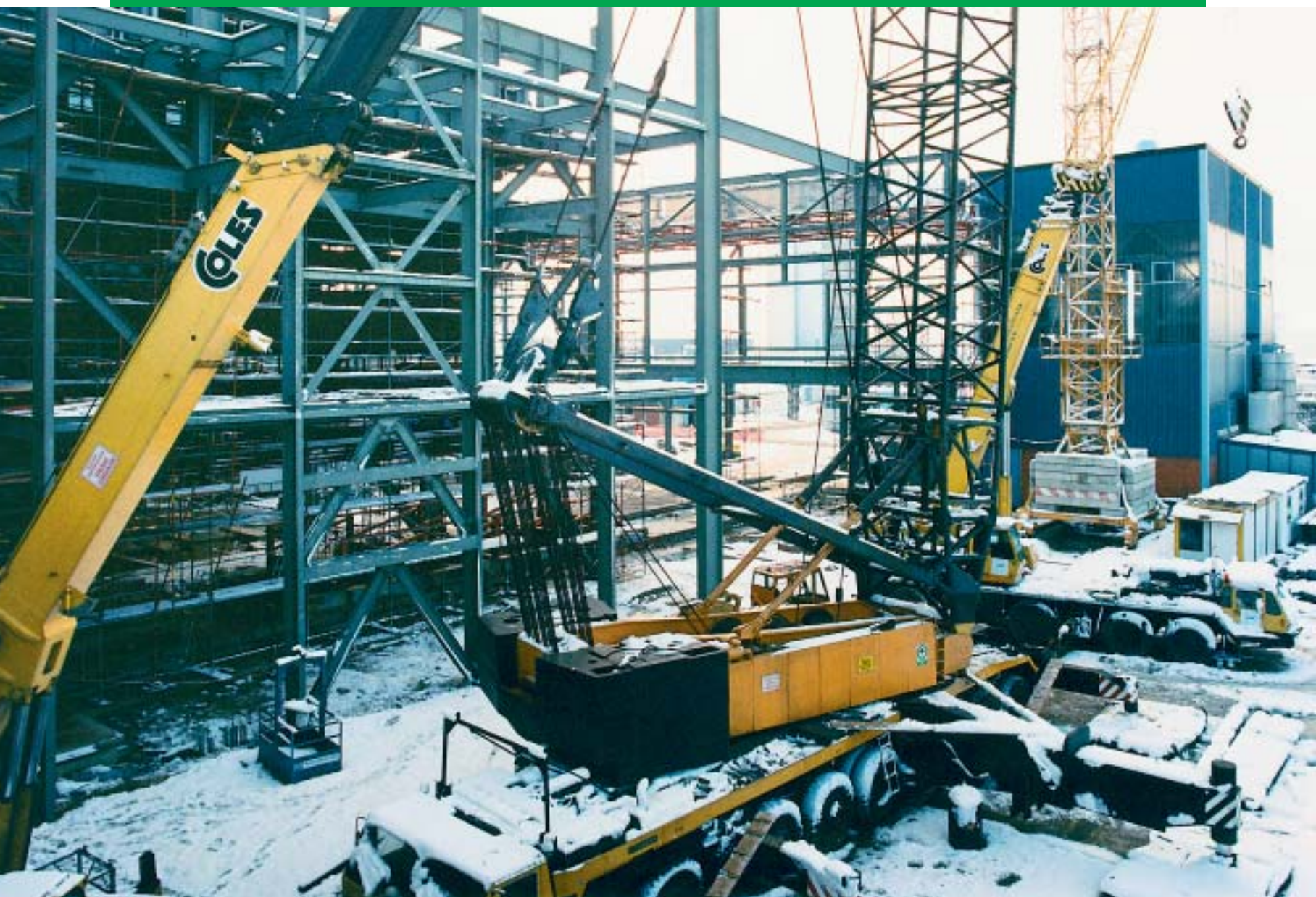
Mehinizacija i snijeg na gradilištu - prosinac 1999. godine
