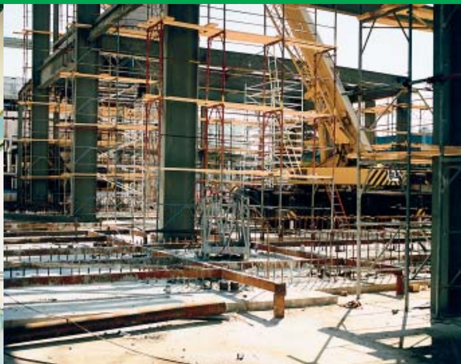
Spajanje starog i novog - noseća konstrukcija kotla
