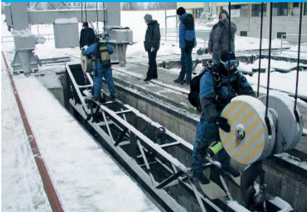
Pregled pragova nizvodnog remontnog zatvarača
