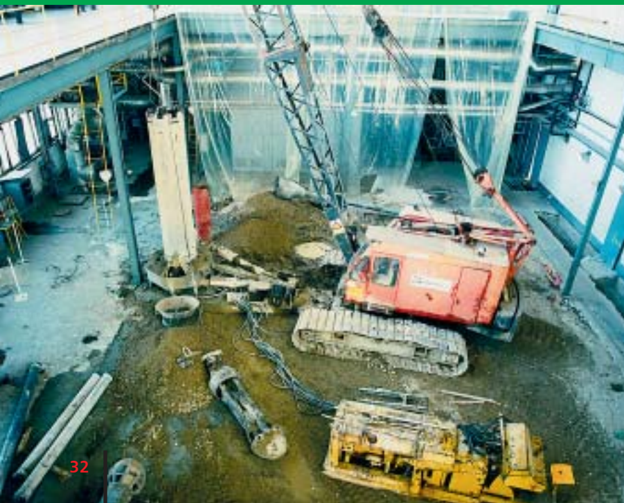
Izrada pilota za temelj parne turbine
