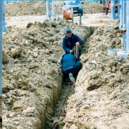
... na polaganju uzemljivača 400 kV
