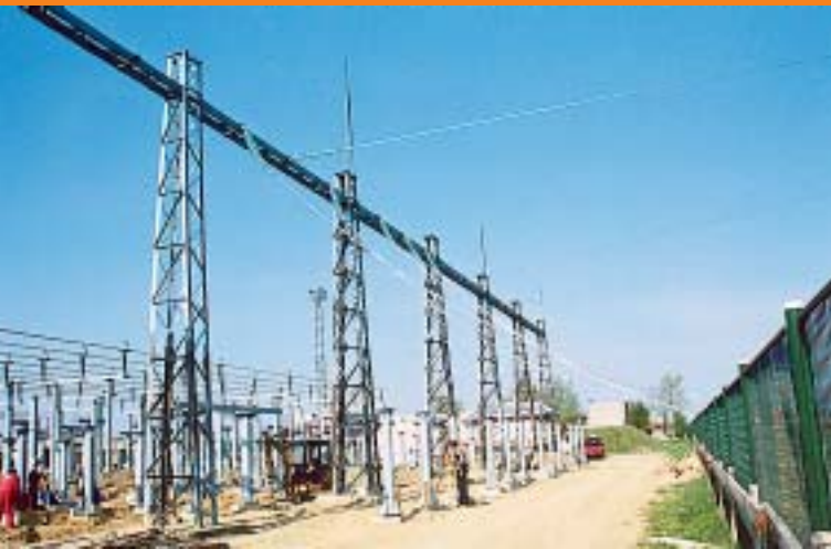
Priključenje vodiča DV 110 kV na portal 110 kV postrojenja
