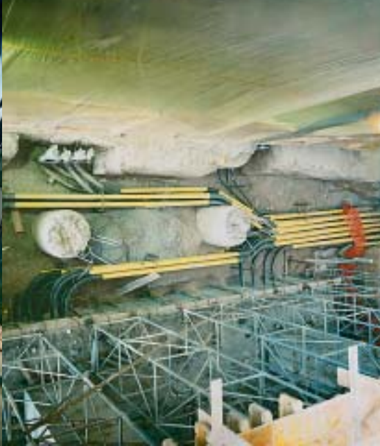
Piloti temelja zgrade i turbinskog stola i kabelske trase
