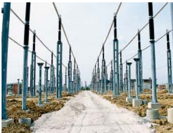
Izgradnja prometnica za lakši pristup postrojenju
