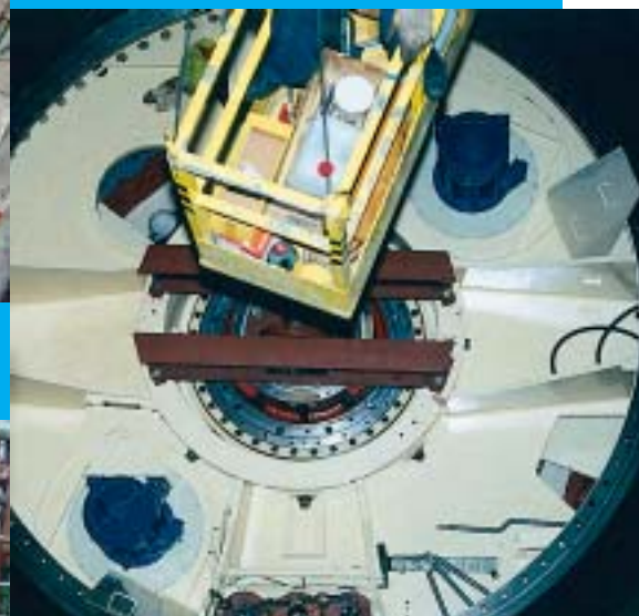
Generator s novim rotorom prije montaže u protočnom traku
