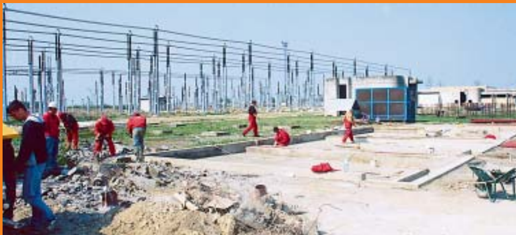
Priprema drugog postolja za prihvat transformatora
