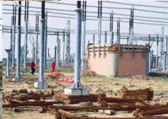
Zidaju se dvije nove relejne kućice
