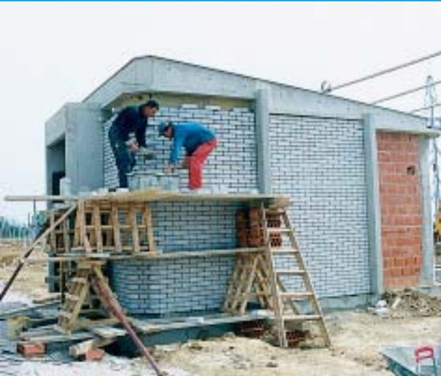
Postavlja se fasadna opeka na relejnu kućicu u postrojenju 400 kV
