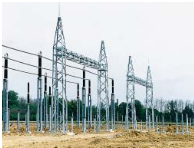
Montirani su portali za prihvat 400 kV dalekovoda Heviz 1 i Heviz 2, kao i...
