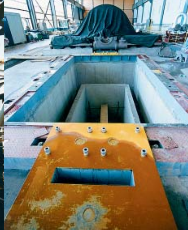
Temelji i ulaz u hladionik generatora
