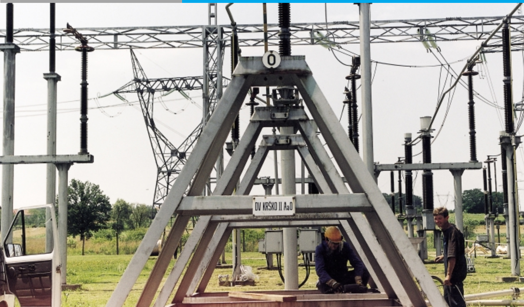
Skidaju se prekidači i postolje
