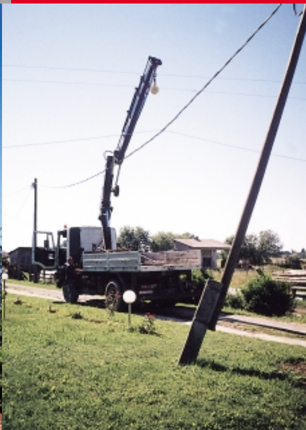
Vozač Ivan Blažinović dosjetio se kako će olakšati spuštanje starih i podizanje novih vodiča DV 10 kV Novaki
