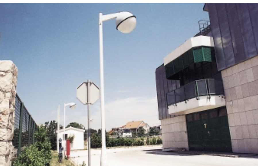
TS 110/(20)/10 kV Zadar - Centar, suvremeno dizajnirana i još uvijek nova TS, u čijem je prostoru i Dispečerski centar DP Elektra Zadar
