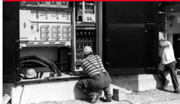
Robert Barić i Mile Kučić postavljaju i spajaju ormariće za regulaciju javnom rasvjetom
