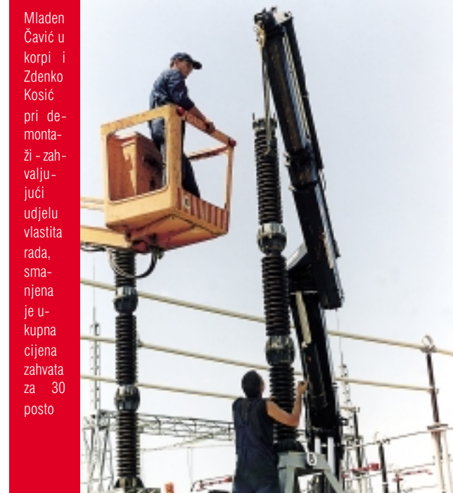
Prekidači 3P proizvodnje Končara, nakon skoro 30 godina odlaze u zasluženu mirovinu
