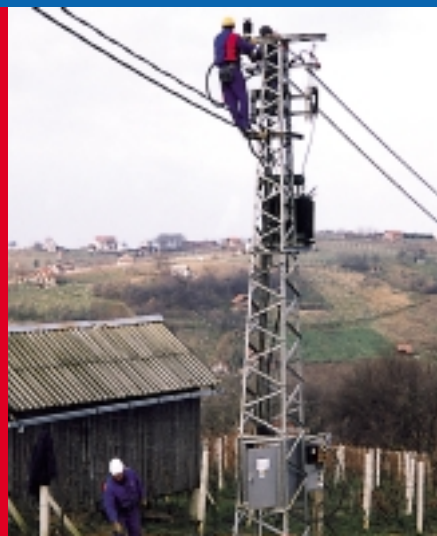
Monteri Pogona Daruvar pri montaži Exel kabela na TS 10(20)/0,4 kV VIP-NET Vrbovac
