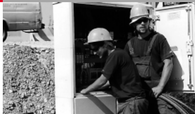
Elektromontažne radove u novoj trafostanici obavili su Joško Guć, Jurica Bilan, Damir Kamber i Emil
