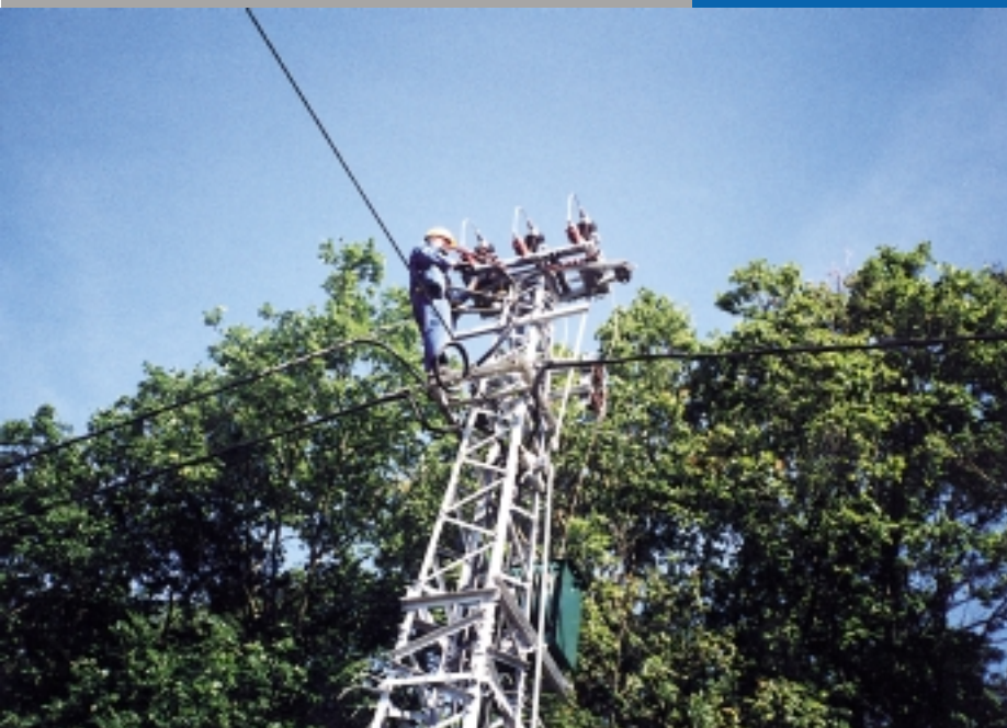
Kabel u TE Ribnjača 2 montirali su zaposlenici Pogona Križ
