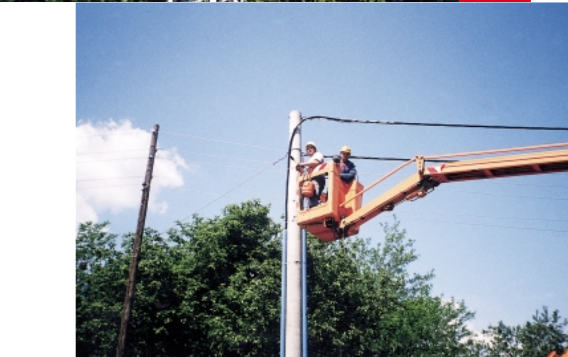
Prelazak kabela iz podzemnog u zračni izveli su elektraši iz Popovače
