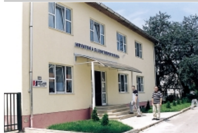
O lijepo uređenom okolišu obnovljene zgrade Pogona Otočac brinu sami zaposlenici
