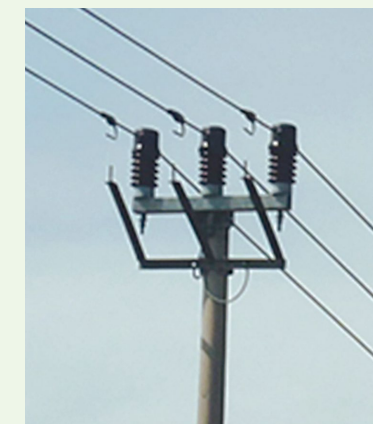
↑ Poluizolirani vodič s iskrištima okrenutim „prema dolje“
