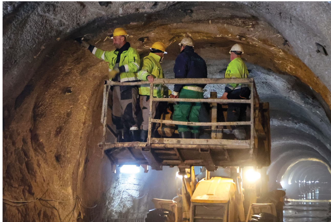
↑ Iskopavanje tunela je obuhvatilo niz složenih faza i zahtijevalo visoku razinu preciznosti
