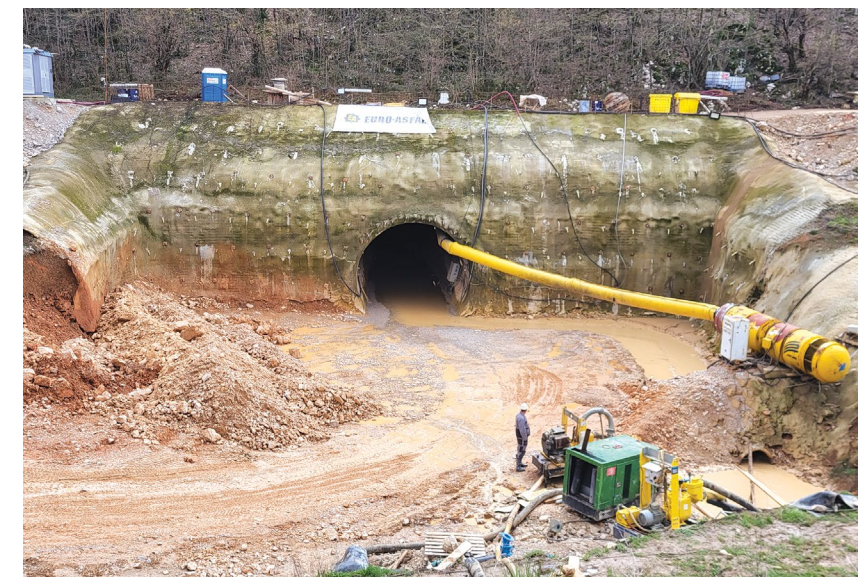
→ Gradilište tunela i kanala Bakovac - Lika
