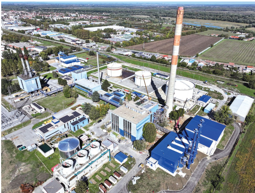
↑ Termoelektrana toplane Osijek nalazi se u industrijskoj zoni, na Zelenom polju
