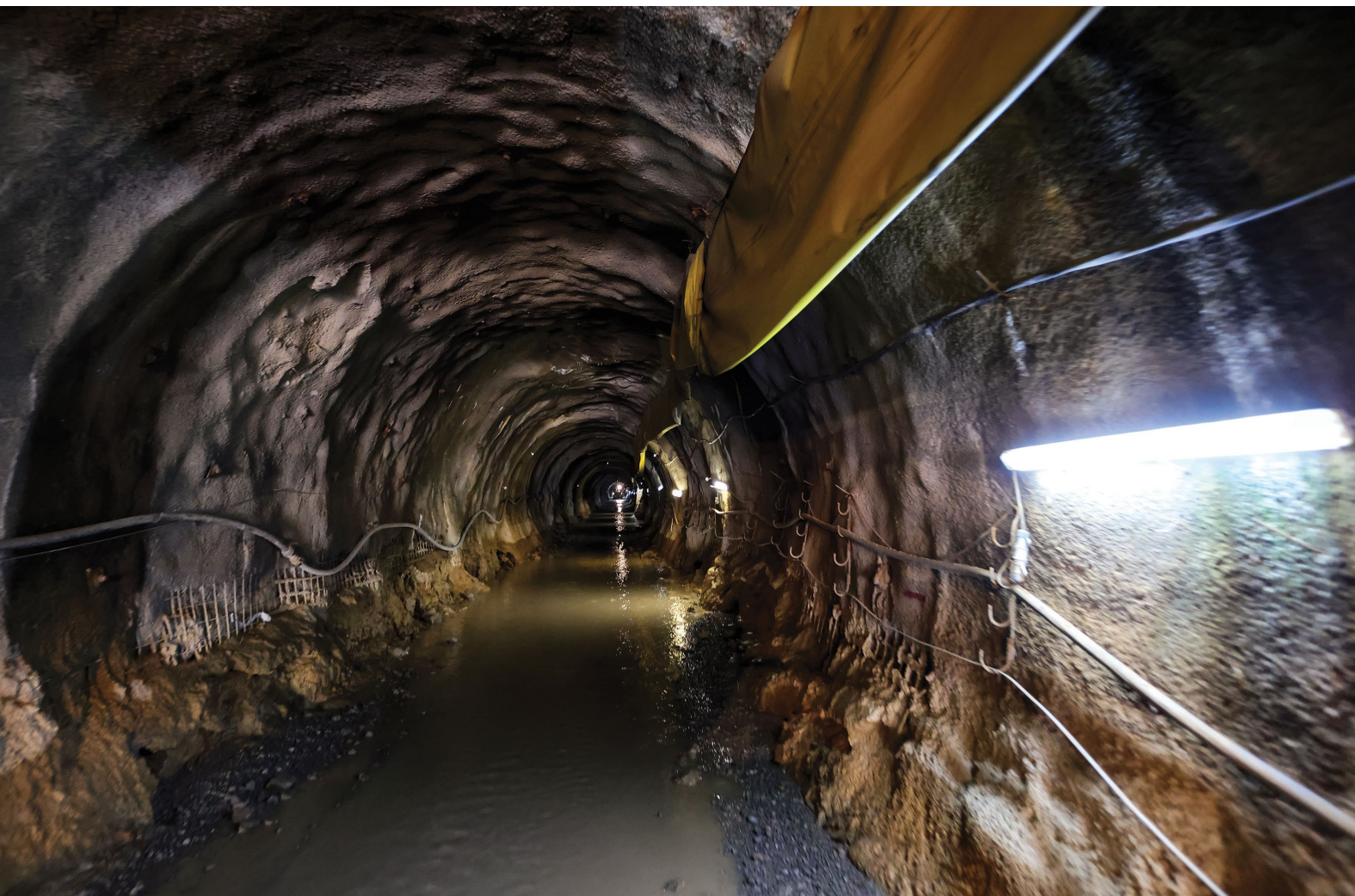
↑ Tunel Bakovac - Lika je dug 3273 metra, promjera 4,5 metra i kapaciteta 70 m³/s
