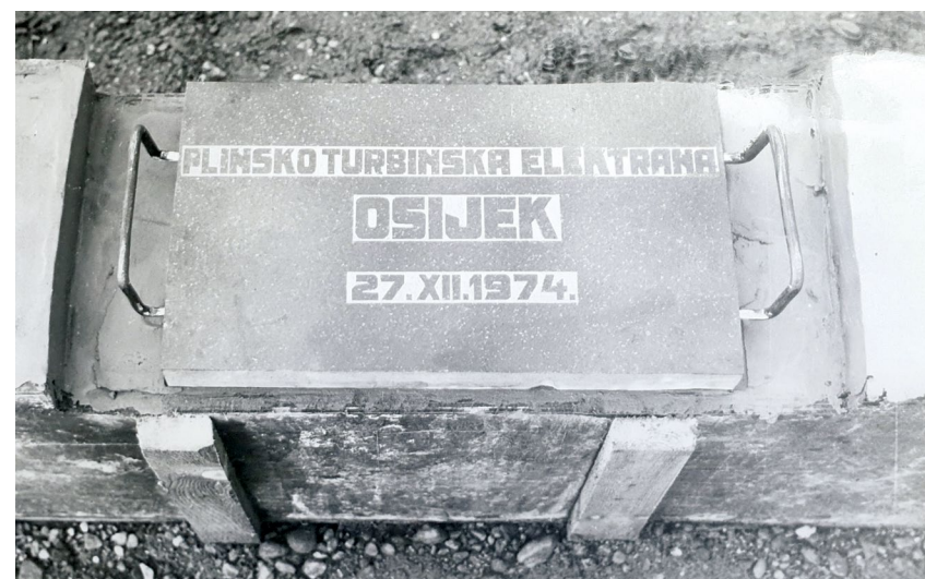
↑ Kamen temeljac za Plinsko turbinsku elektranu Osijek položen je krajem 1974.
