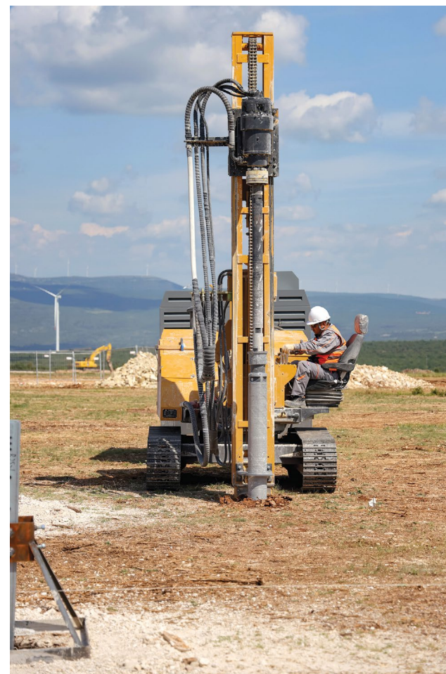
← Na gradilištu se postavljaju nosači konstrukcije za ugradnju 160 tisuća fotonaponskih modula
