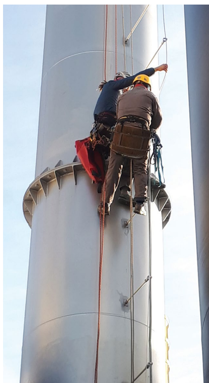
↑ Montaža gromobranske zaštite dimnjaka
