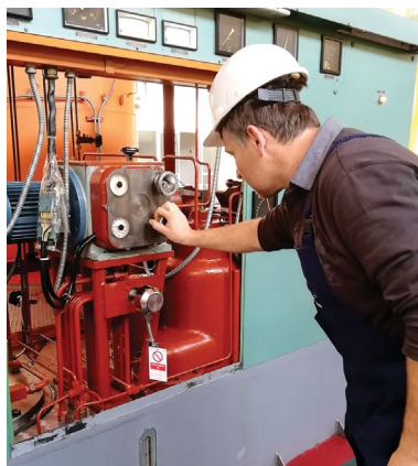
←← Podešavanje lopatica privodnog kola u HE Čakovec ← HE Varaždin: provjera turbinske regulacije
