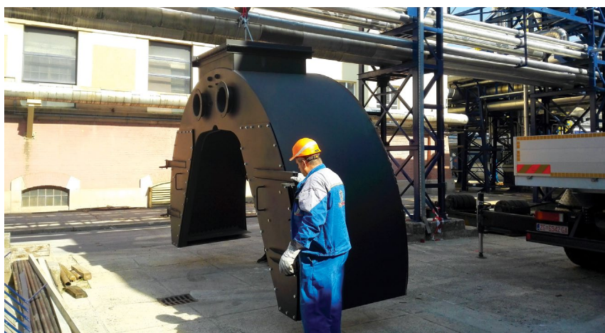
↑ Priprema za betoniranje stope dimnjaka i kućice za ventilatore zraka ↓ Segment stražnje dimne komore kotla
