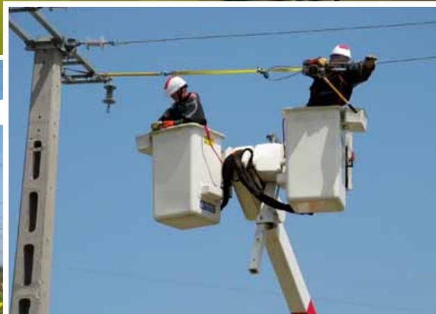
Ekipa HEP NOC-a tijekom natjecanja: demonstracija zamjene izolatora na 22 kV postrojenju
