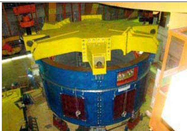
**Stator generatora B, montiran na montažnom katu strojarnice...**
