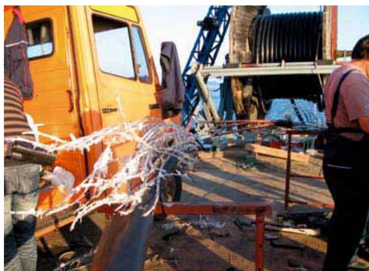
**Priprema kabela za izradu prve spojnice, s tim da je čelična armatura omotana bubrećom vrpcom, koja se raspupa nakon piljenja i ulaska mora u spojnicu**
