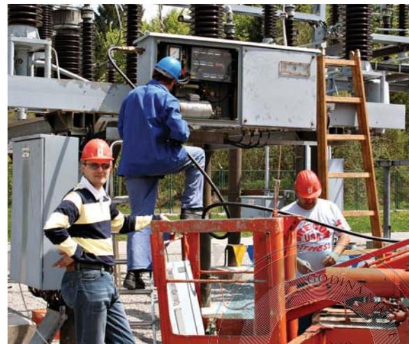
Nakon punih 18 godina u TS 110/35 kV Delnice proveden je generalni remont prekidača
