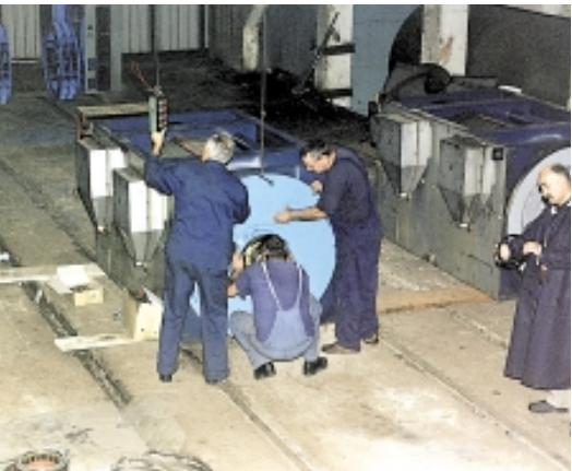
Po prvi put od početka rada obavlja se kapitalni remont visokonaponskih motora tlacihi i usisnih ventilatora bloka 1
