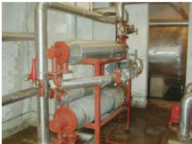
Ilustracija 6 Izmjenjivači topline za pripremu PTV-a
