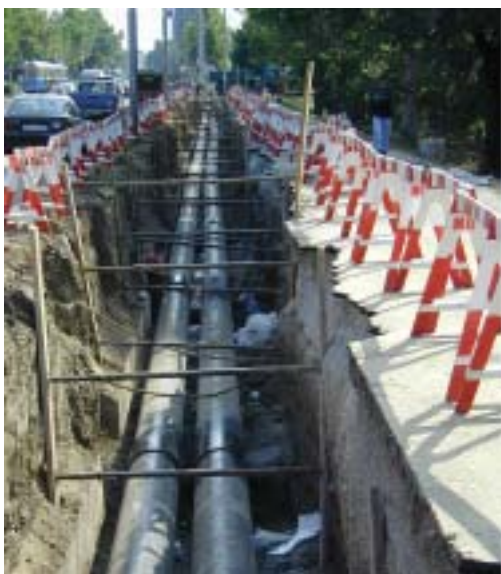
Ilustracija 4 Zamjena klasičnih čeličnih cijevi predizoliranim
