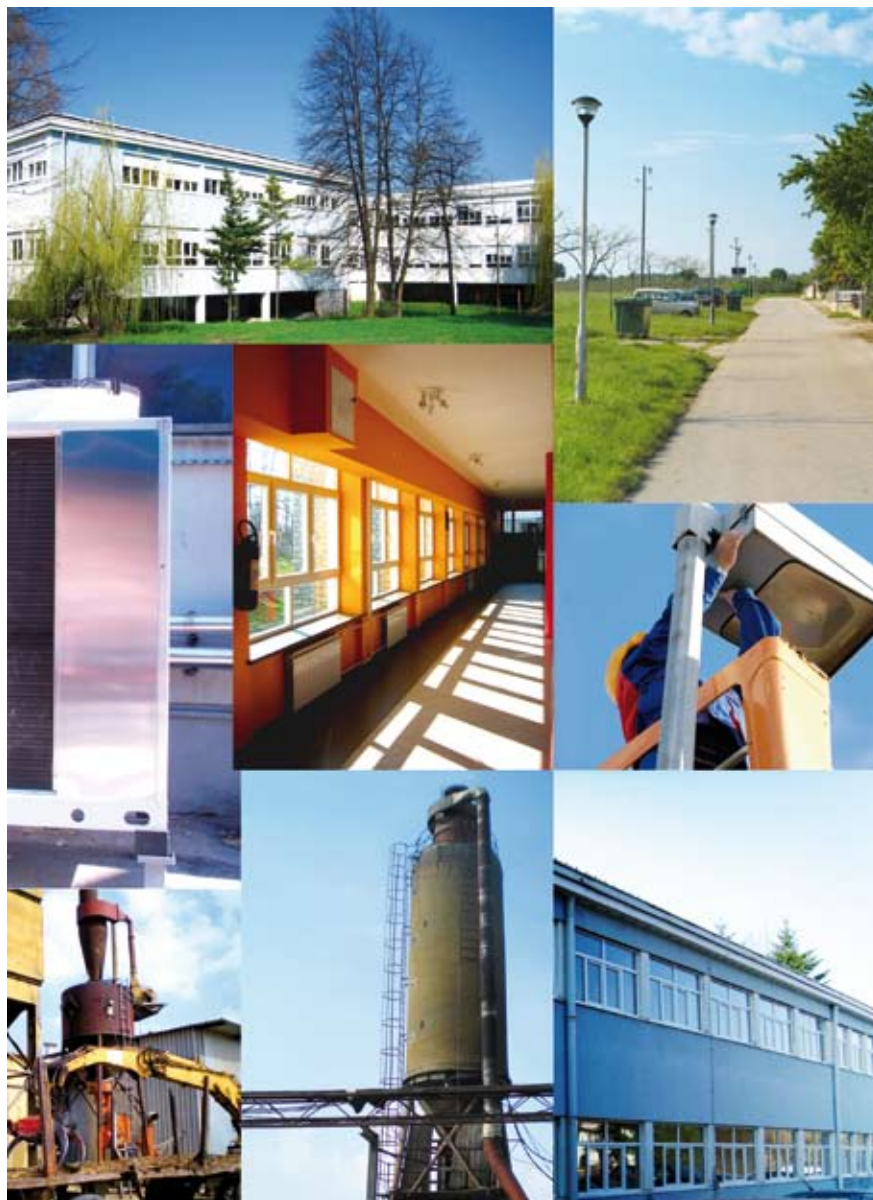
PROJEKTI tvrtke HEP-ESCO obuhvaćaju javnu rasvjetu, zgradarstvo, industriju i sustave opskrbe
