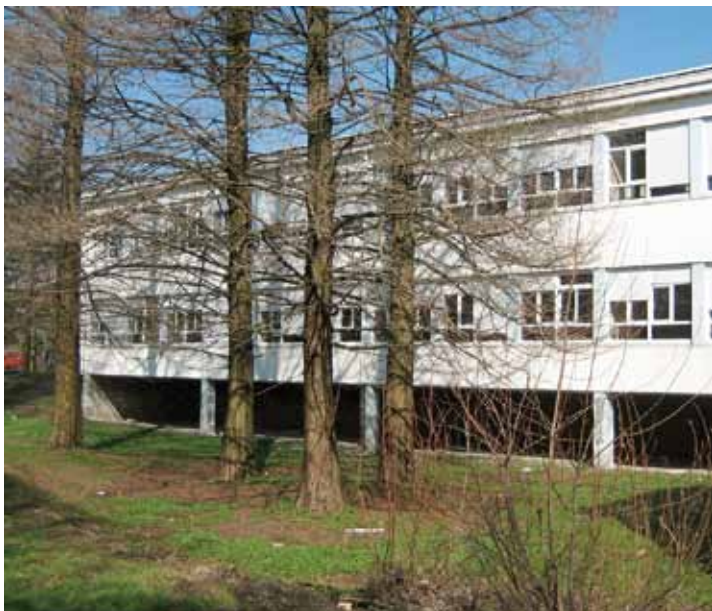
Ilustracija 4 Isto tako, treba spomenuti i energetske sanacije zgrada škola u Karlovcu (Osnovna škola Banija)...
