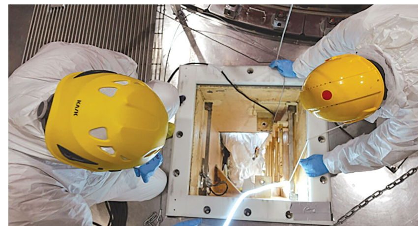
↑ Mjesto ulaska u prostor uz reaktorsku posudu, gdje se nova cijev varila na ulazni spoj reaktora
