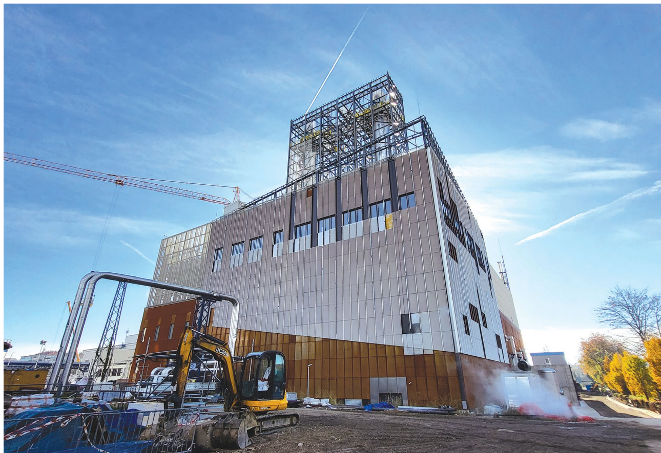
↑ Blok L će omogućiti opskrbu 80.000 stanovnika zapadnog dijela Zagreba toplinskom energijom na učinkovitiji način te doprinijeti smanjenju emisija CO 2 i onečišćujućih tvari u okoliš
