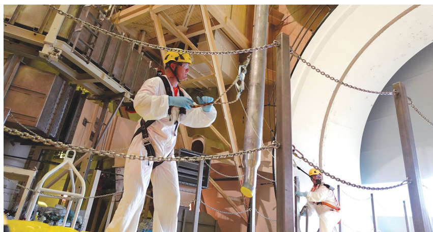
↑ Spuštanje nove cijevi u prostor gdje je varenjem spojena na ulazni spoj reaktora
