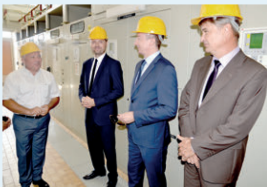
↑ Član Uprave HEP-a Saša Dujmić i direktor Elektroistre Zvonko Liović u razgledavanju obnovljene transformatorske stanice
