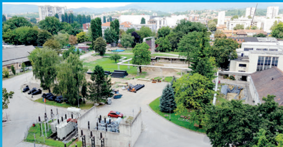
↑ Gradilište na koje dolazi Blok KKE EL-TO
