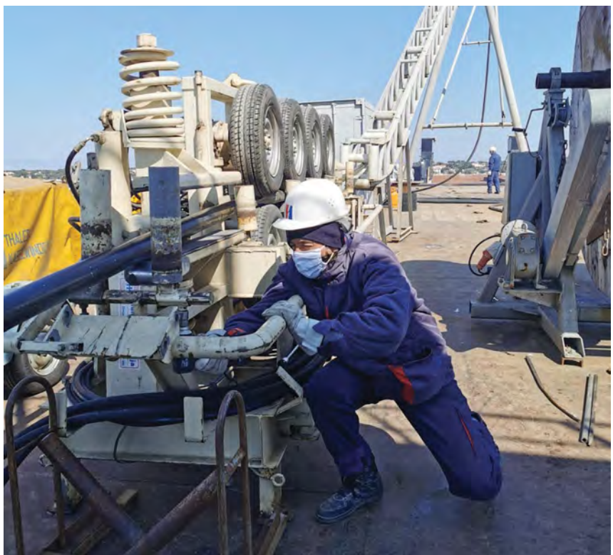
↑ Elektromonter Antonio Novaković iz Elektrodalmacije Split priprema stroj za prolaz podmorske spojnice
