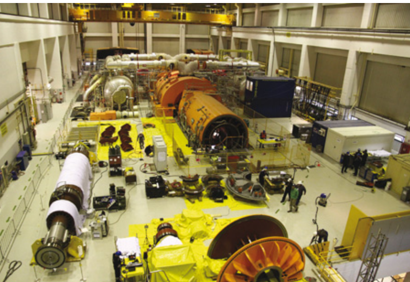
U turbinskoj zgradi: remont glavnog generatora i...
