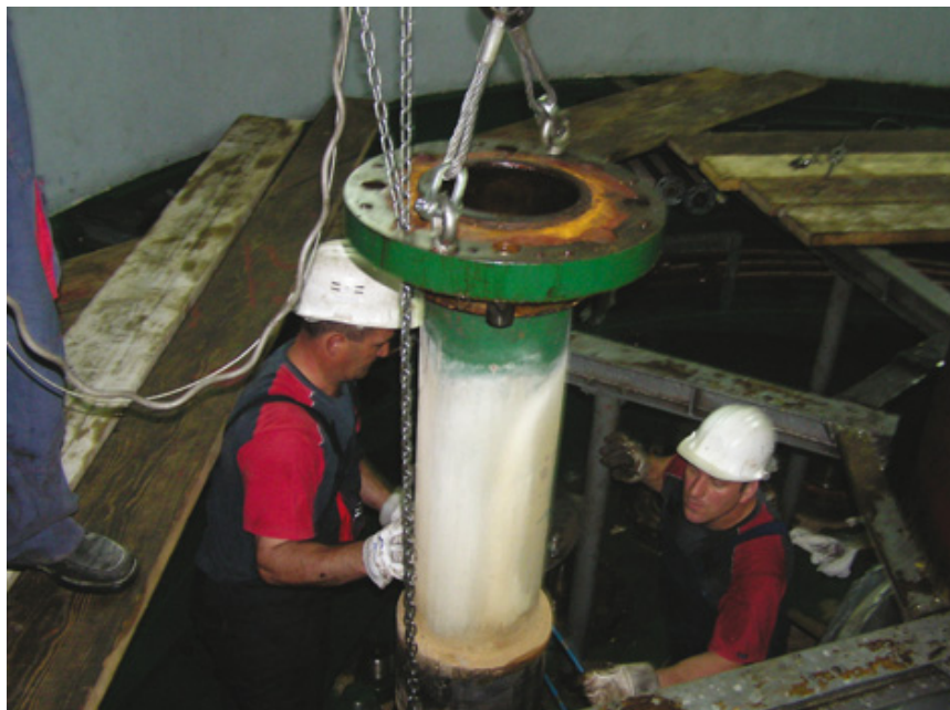
Popravlak procurivanja privodnih lopatica crpke-turbine 1
