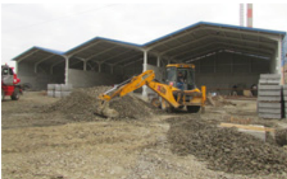
Zatvoreno skladište za drvenu sječku
