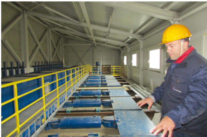
Hidraulični cilindri za pokretanje pomičnog dna u dnevnom skladištu sječke
