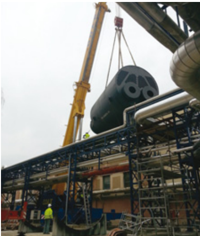
Podizanje kotla preko cijevnih mostova na pripremljene temelje, pomoću dvije auto-dizalice visoke nosivosti, od 200 i 120 tona
