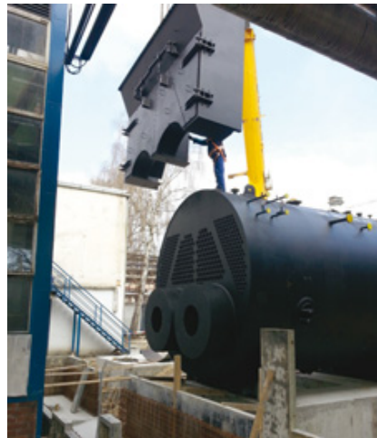
Montaža kotla i njegovih komora
