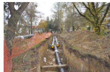
Polaganje podzemnog dijela vrelovoda u naselju Caprag
