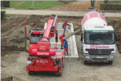
Betoniranje dna vage za vaganje kamiona s drvnom sječkom
