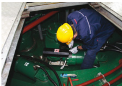
Ugradnja mehaničkih zaštita na optičke senzore privodnih lopatica
