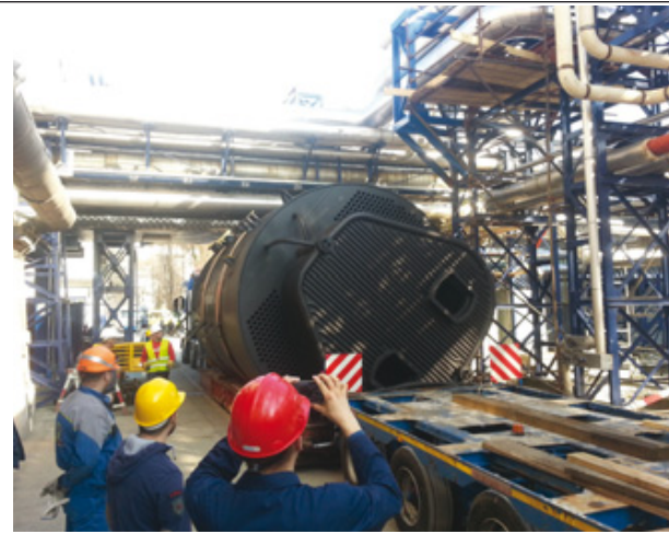
U skućenom prostoru Pogona bilo je iznimno zahtjevno manevrirati s teretom teškim 70 tona
