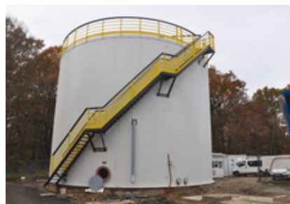
Spremnik demij vode u završnoj fazi montaže
