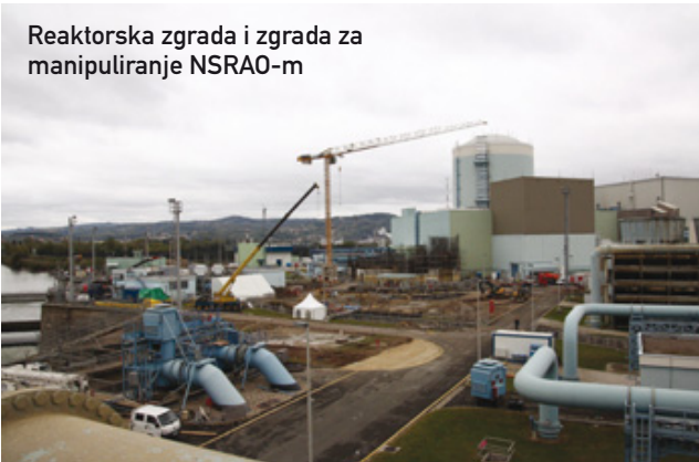
Pogled iz zraka na gradilište u NE Krško
