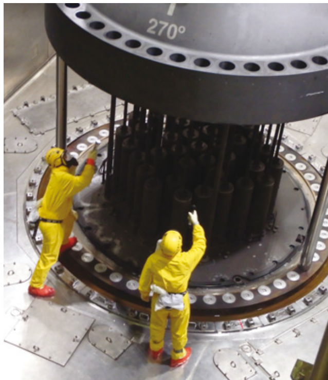
Kontrolne palice na pregledu: dio njih zamijenit će se novima
