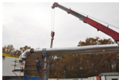
Nadzemni vrelovod u fazi montaže
