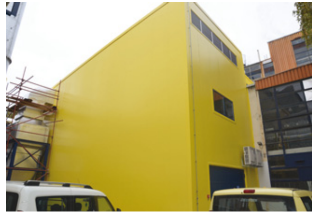
NTK BR 1 je smješten u montažnoj zgradi, koja je vezana na postojeće postrojenje
