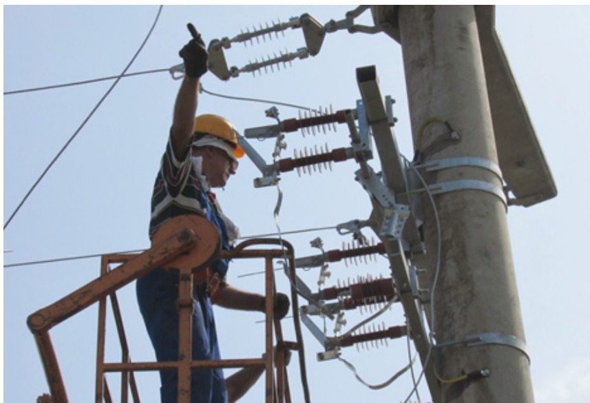
Montaža rastavljača na betonski stup
