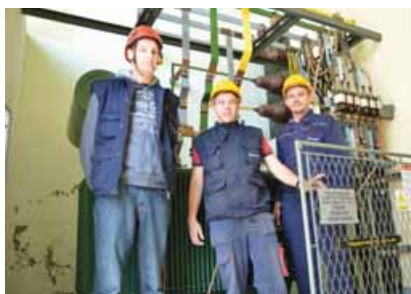
Zamjena transformatora vlastite potrošnje
