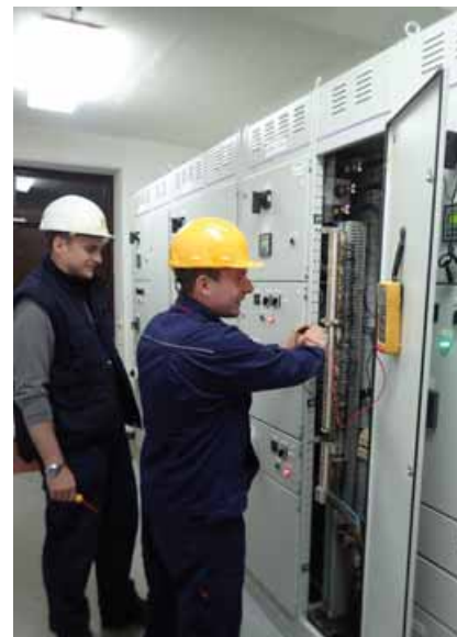
Radovi na vlastitoj potrošnji turbine
