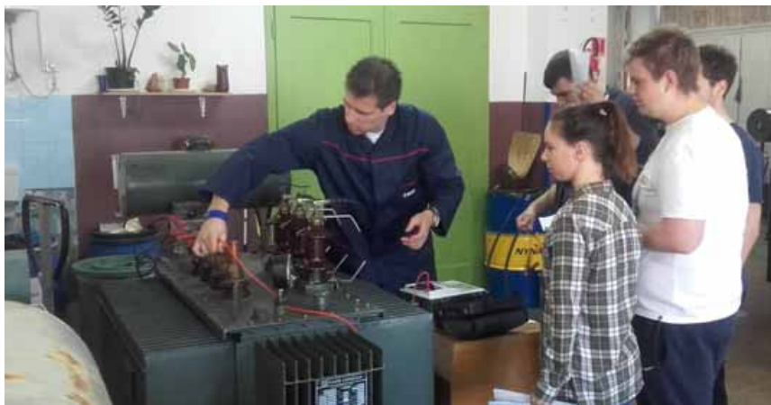
U Traforadioni Elektrodalmacije prezentirana je dijagnostika transformatora
