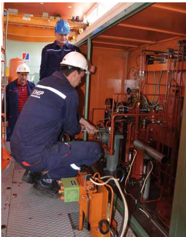
Radovi na turbinskoj regulaciji
