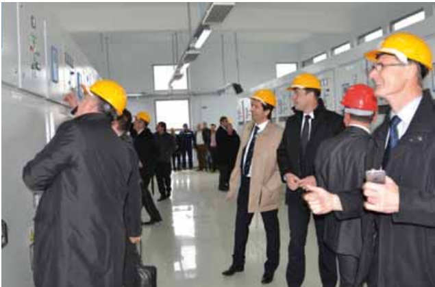
... i Trafostanice 110/35/10(20) kV Bjelovar I
