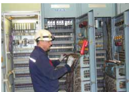
Radovi na turbinskoj regulaciji
