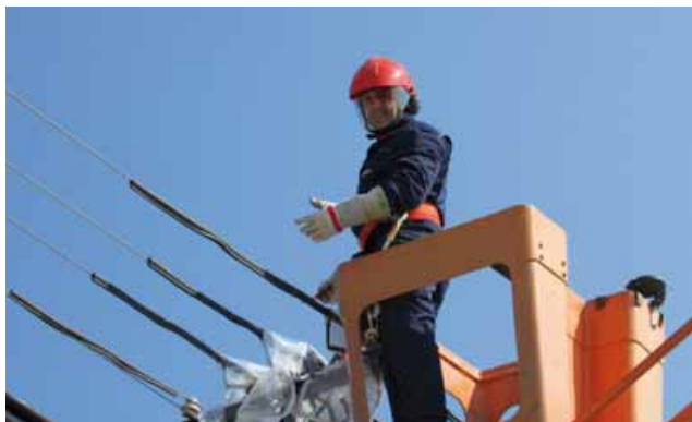
Za zaštitu od vodljivih metalnih dijelova služi čvrsta i otporna izolacijska prekrivka, koja se lako omotava i učvršćuje čičkom; izolacijskom cijevi i izolacijskom kapicom sprječava se doticanje vodiča za vrijeme rada
