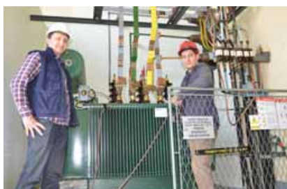
Ispitivanje transformatora vlastite potrošnje
