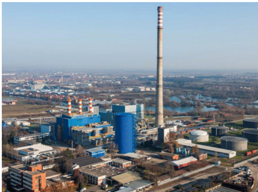
Akumulator topline je lani u prosincu krenuo u probni rad te je s njim prebrođen najhladniji dio zime
