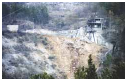
Nakon aktiviranja 20 tona eksploziva, koji je neprijatelj postavio u injekcijsku galeriju brane Peruća i u preljevnu građevinu, na sreću, brana se nije potpuno urušila
