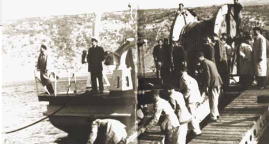
Veći otoci u elektroenergetski sustav uključuju se zahvaljujući polaganju podmorskih kabela: tehnologija polaganja podmorskog kabela kopno-otok Krk krajem pedesetih godina 20. stoljeća i...
