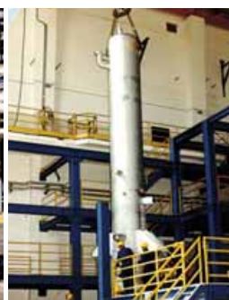
...montaže visokotlačnog zagrijača
