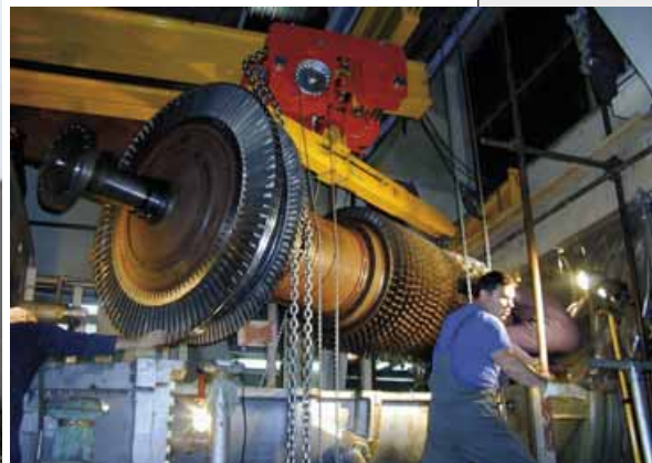
Prvi kapitalni remont plinskih turbina
