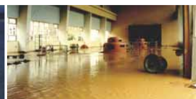
Poplavljena strojarnica i nakon snažnih gežira zatrpano rasklopno postrojenje HE Peruća
