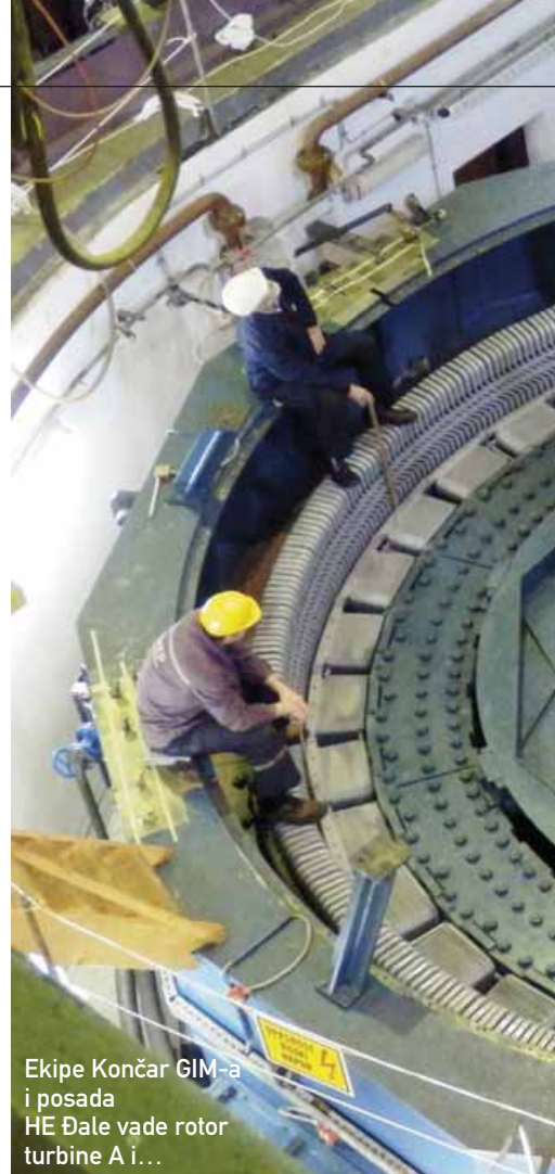
... odlažu ga na rotorsko postolje u strojarnici
