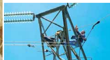
Radovi na stupu dalekovoda 400 kV Konjsko-Velebit
