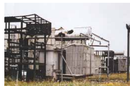
Energetski transformator 400/100 kV i priključak na 30 kV postrojenje
