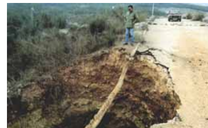
Nakon aktiviranja 20 tona eksploziva, koji je neprijatelj postavio u injekcijsku galeriju brane Peruća i u preljevnu građevinu, na sreću, brana se nije potpuno urušila
