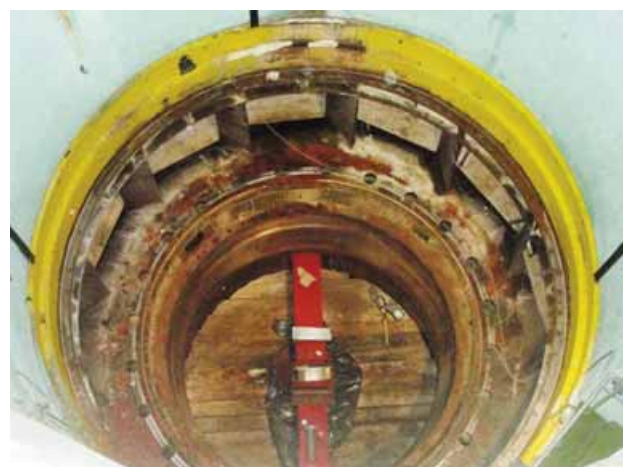
Prazna jama agregata A s tek turbinskom oblogom i odvodnim traktom dolje negdje duboko, prizor je koji se mogao vidjeti samo prije tridesetak godina, pri izgradnji HE Đale
