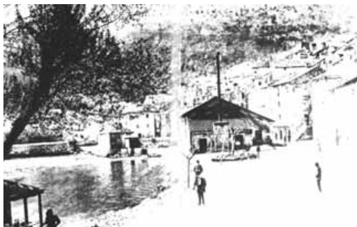
Zgrada hidro-termoelektrane u Bakru (1894.) - prvi primjer kombinirane elektrane u Hrvatskoj
