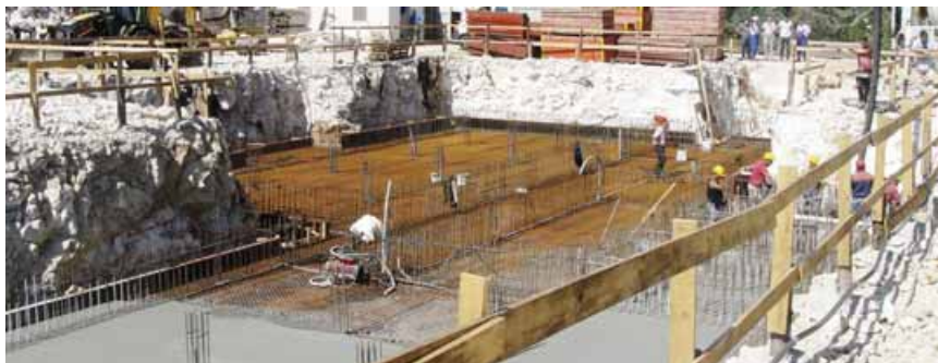
Zemljani radovi su pri kraju, a do kraja rujna predviđa se dovršetak građevinskih radova, kada će započeti elektromontažni
