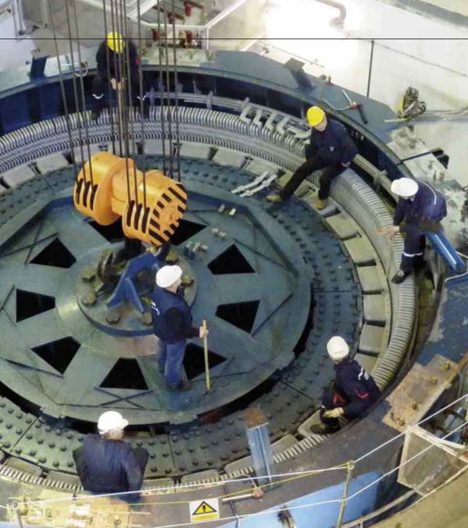
Pripremljena demontaža turbinske osovine, koja se ne može sanirati u strojnarnici
