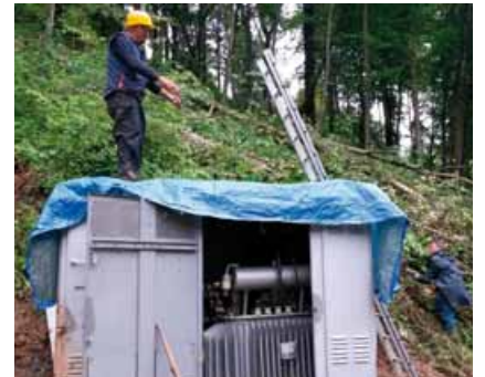
Nakon 16 sati rada, požeški monter i uspjeli su pustiti u pogon ranjeno postrojenje, iznimno važno za napajanje pitkom vodom požeškog područja
