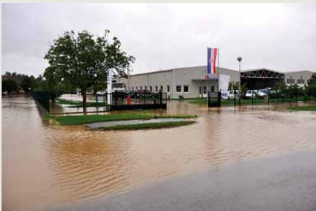
Poplavljen je i skladišni objekt Elektre Požega, smješten u blizini Orljave...
