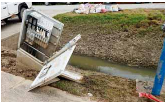
Uništena i natopljena postrojenja nakon povlačenja vode krajem svibnja
