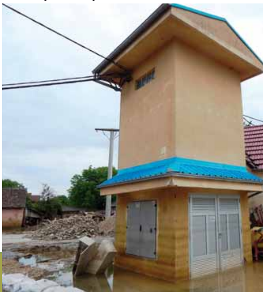
Uništena i natopljena postrojenja nakon povlačenja vode krajem svibnja
