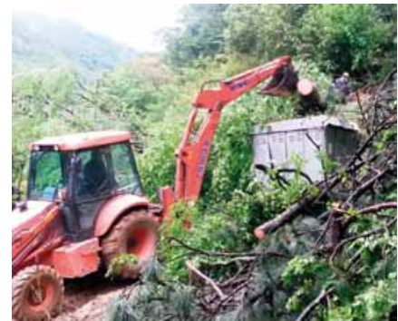
Uz motorne pile i bager, razaznaju se obrisi TS 10/0,4 kV u Veličkim toplicama
