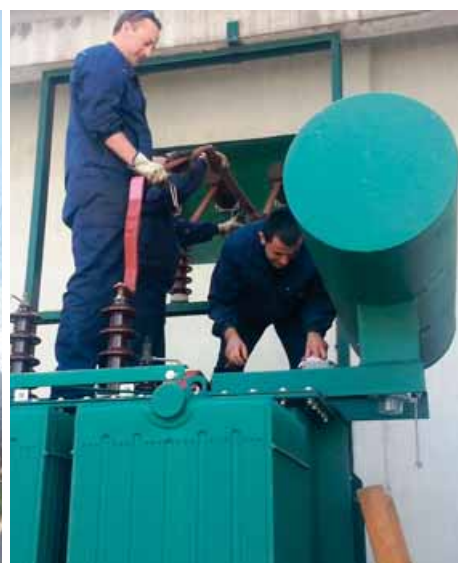
Posljednja faza puta : zaposlenici Odjela za održavanje trafostanica i traforadionice Elektrodalmacije Split novi transformator priključuju u sustav
