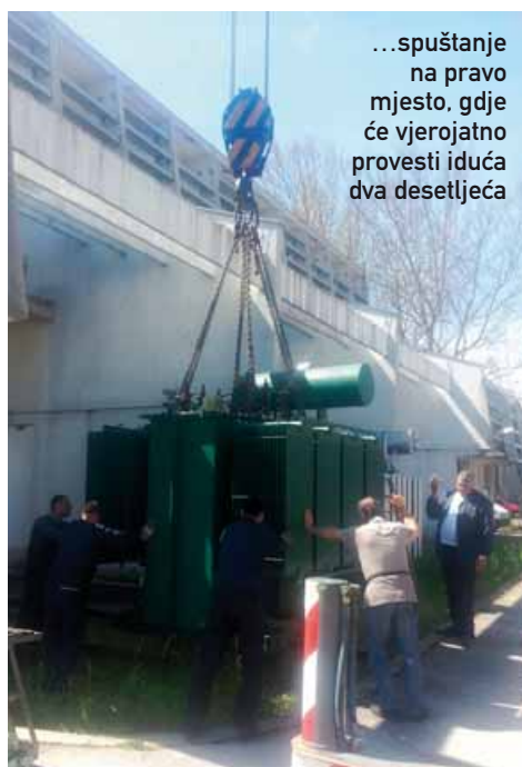
Posljednja faza puta : zaposlenici Odjela za održavanje trafostanica i traforadionice Elektrodalmacije Split novi transformator priključuju u sustav
