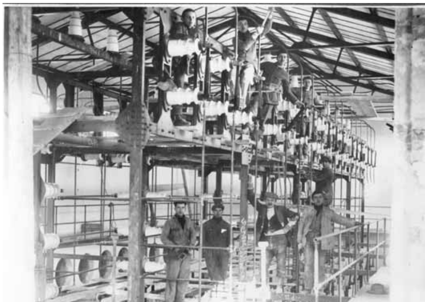
Jedna od najstarijih istarskih 20/10 kV trafostanica - Karojba, tijekom izgradnje
