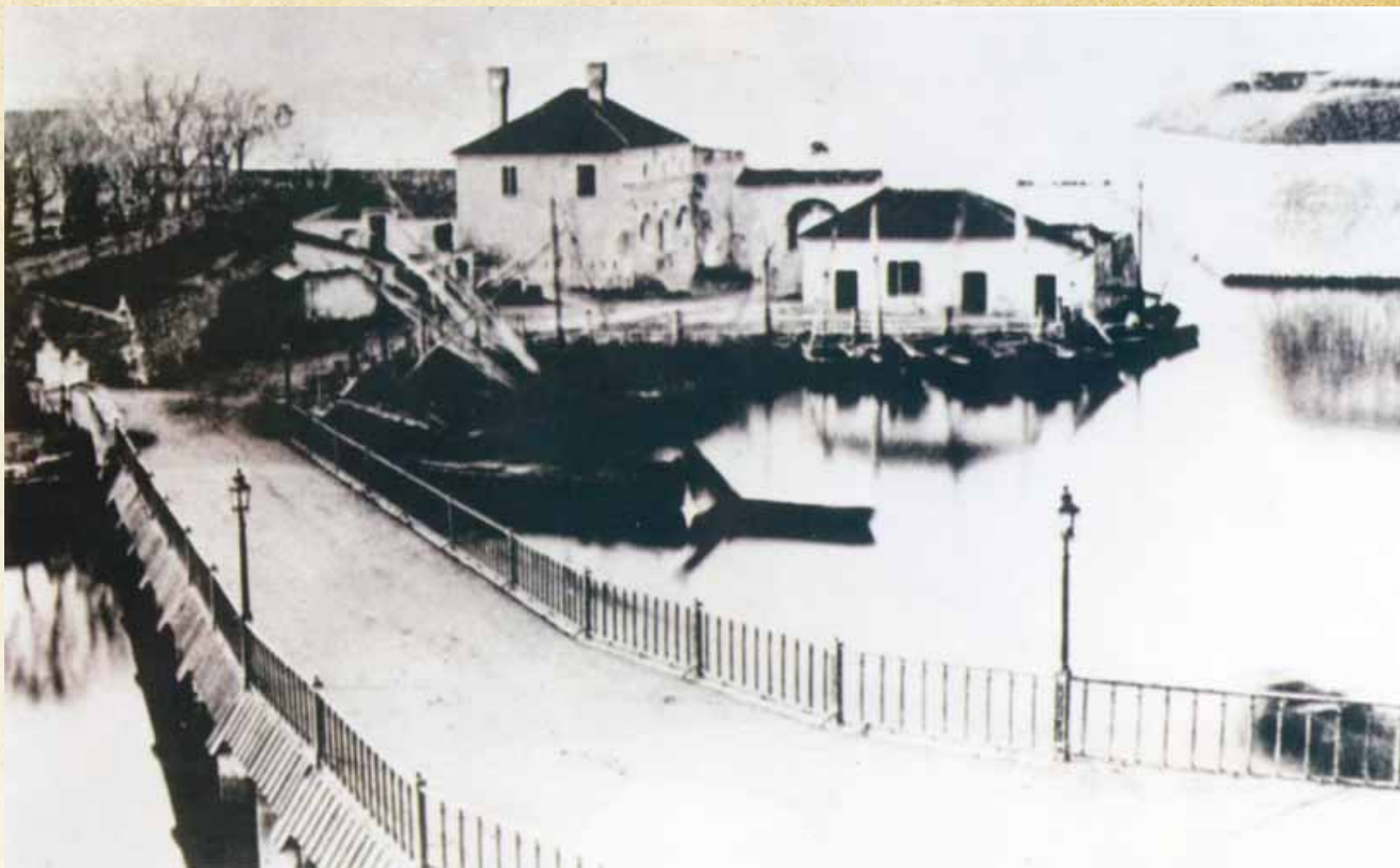
Željezni stupovi s feralima petrolejske rasvjete na mostu u lučici Foša
