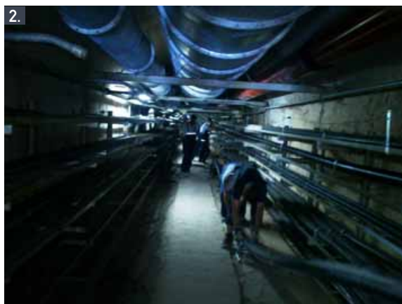
1. Inženjeri snimaju mjesto izlaska kabela u vanjskom rasklopnom postrojenju 2. Uvlačenje novog kabela 3. Dio po dio teškog kabela podizao se i smještao na police - sve tri kabelaške žile
