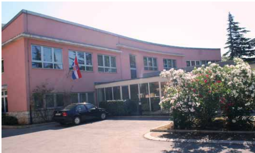
Pogonska zgrada HE Vinodol u Triblju
