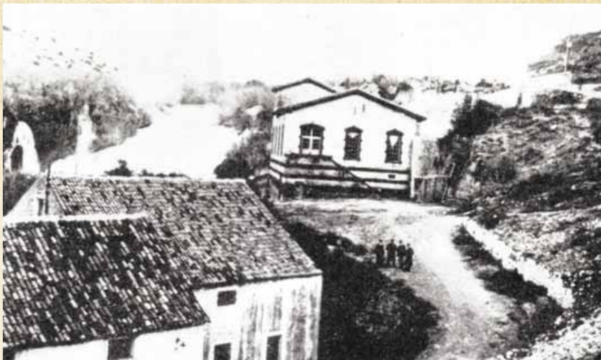
Zgrada HE Krka s kopnene i...
