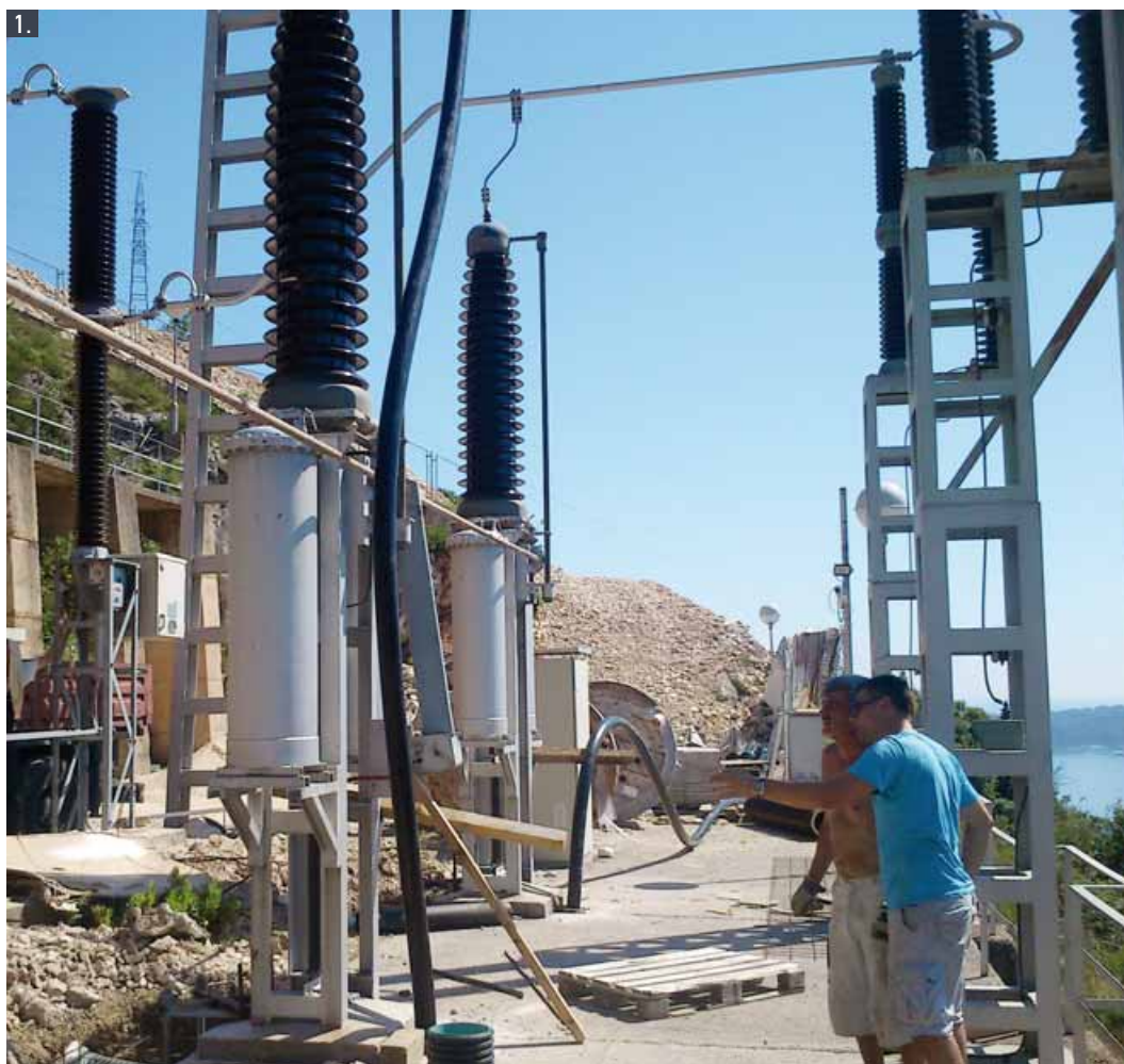
1. Inženjeri snimaju mjesto izlaska kabela u vanjskom rasklopnom postrojenju 2. Uvlačenje novog kabela 3. Dio po dio teškog kabela podizao se i smještao na police - sve tri kabelaške žile
