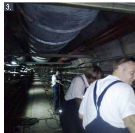
1. Inženjeri snimaju mjesto izlaska kabela u vanjskom rasklopnom postrojenju 2. Uvlačenje novog kabela 3. Dio po dio teškog kabela podizao se i smještao na police - sve tri kabelaške žile
