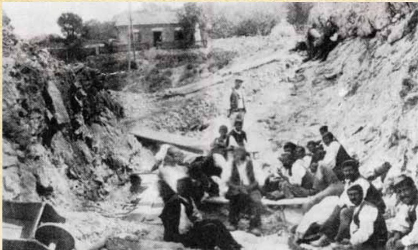
Građevni radovi na gradilištu HE Krka
