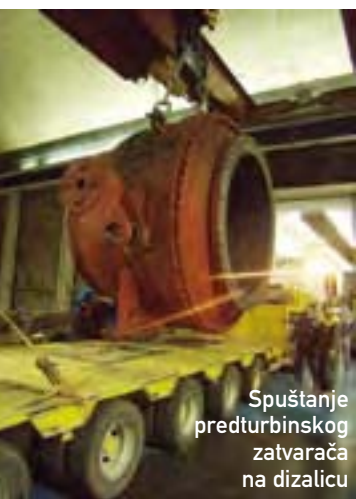
Dizanje predturbinskog kuglastog zatvarača
