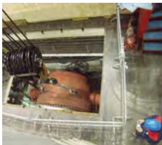
Dizanje predturbinskog kuglastog zatvarača
