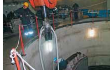
Stator agregata A rastavlja se postupno
