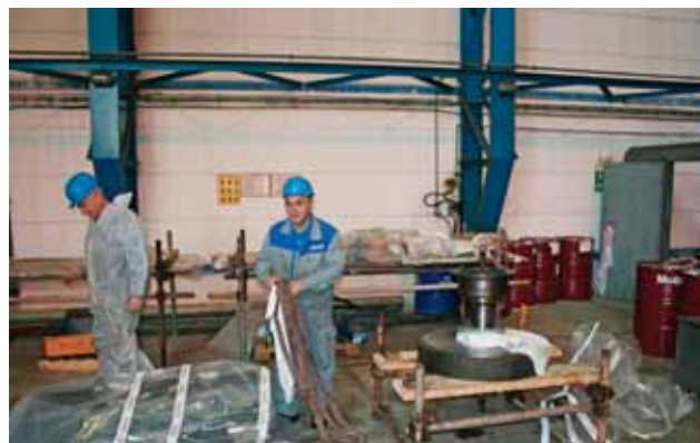
Remont napojnih crpki, serviseri Voith i Selecta, Labin
