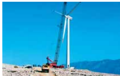
Izgradnja prve vjetroeletre za komercijalnu isporuku električne energije Ravna Pag. koja je 2004. probila led u Hrvatskoj
