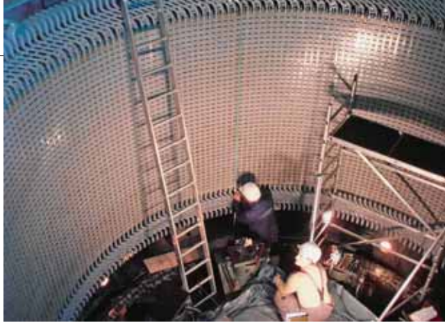
Stator je obnovljen tijekom siječnja i agregat A pušten je pogon već 9. veljače
