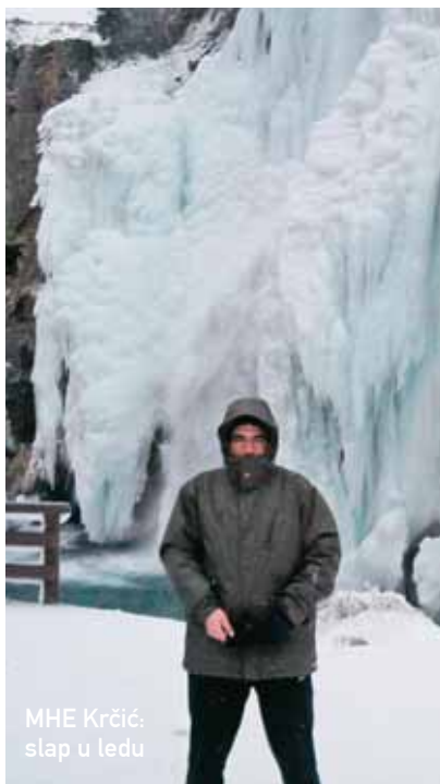
Kompensacijski bazen HE Golubić: u takvim uvjetima postrojenja su normalno proizvodila električnu energiju
