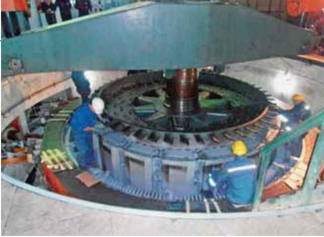
Saniranje proboja izolacije namota na statoru starog generatora A žurno je obavila ekipa Končar GIM-a
