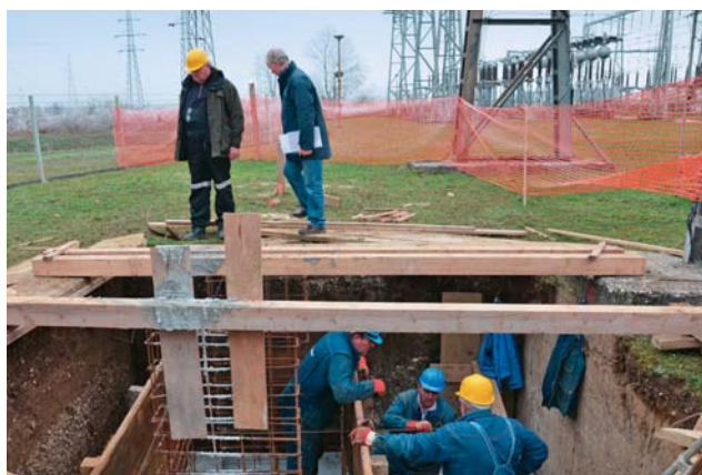
Temelj za portal novog dalekovoda iskopan je u studenom
