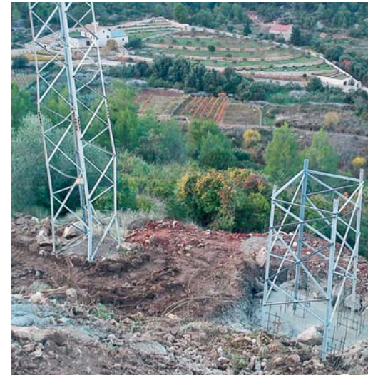
Dalekovod 35 kV Stari Grad - Hvar dobiva tri nova čeličnorošetaksta stupa
