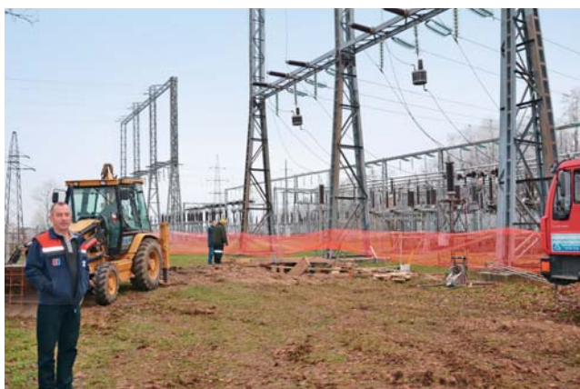
Božidar Zorko - voditelj trafostanice Rakitje, jakog prijenosnog čvorišta, u obilasku gradilišta
