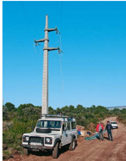
Izgrađen davne 1958. godine na betonskim stupovima, dalekovod 35 kV Stari Grad - Smočiguzica traži pomlađivanje
