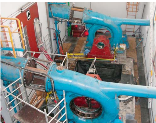
U ovu rupu će se početkom veljače iduće godine vratiti generator ABM-a
