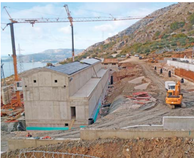
Zemljani zahvati od početka izgradnje izvodili su se u iznimno nepovoljnim vremenskim uvjetima, ali uspijevaju se poštivati planirani rokovi
