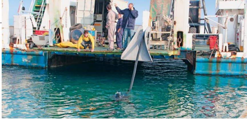
Veliki broj sudionika tog posla su umreženi i potrebna je dobra koordinacija kapetana tegljača, geodeta, ronilaca, čamaca...osobito u najsloženijim fazama – početku i završetku polaganja
