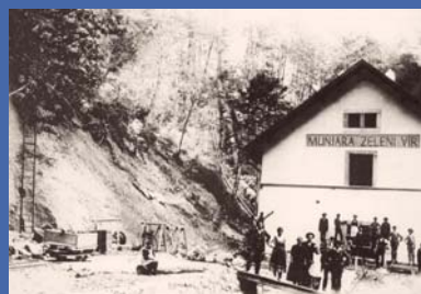
Zgrada Munjare Zeleni vir u vrijeme gradnje elektrane 1920.
