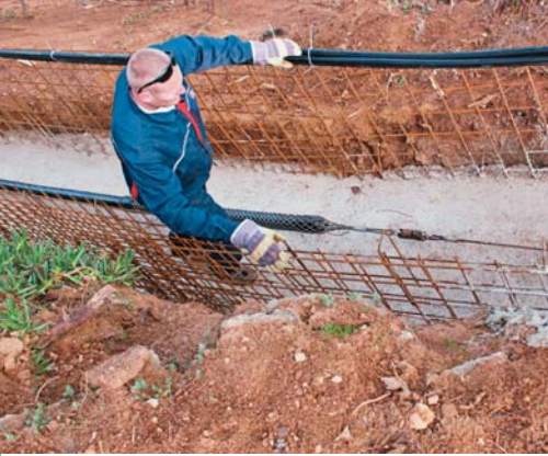
Kabel u tzv. čarapi na tkonskoj strani. kroz priobalnu zaštitu, uronit će u more i krenuti prema biogradskoj strani
