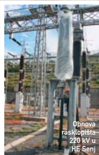
Novi kabel iz rasklopišta na ovom mjestu se spaja s postrojenjima u strojarnici
