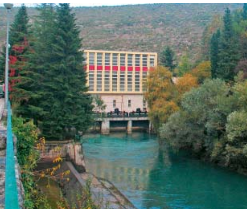
Obnovljena je i fasada strojarnice
