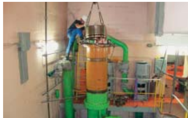
Strojarski radovi na kuglastim zatvaračima, regulatoru tlaka i tlačnom cjevovodu izvela je sinjska tvrtka Brinel
