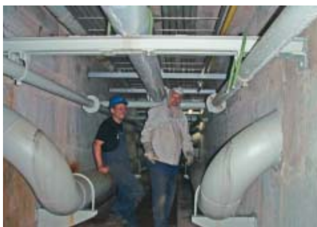
Izmjena cijevnih instalacija
