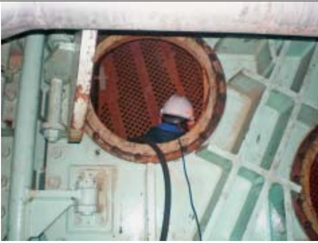
Ispitivanje nepropusnosti cjevnog snopa kondenzatora parne turbine
