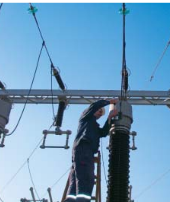
Revizija mjernih transformatora
