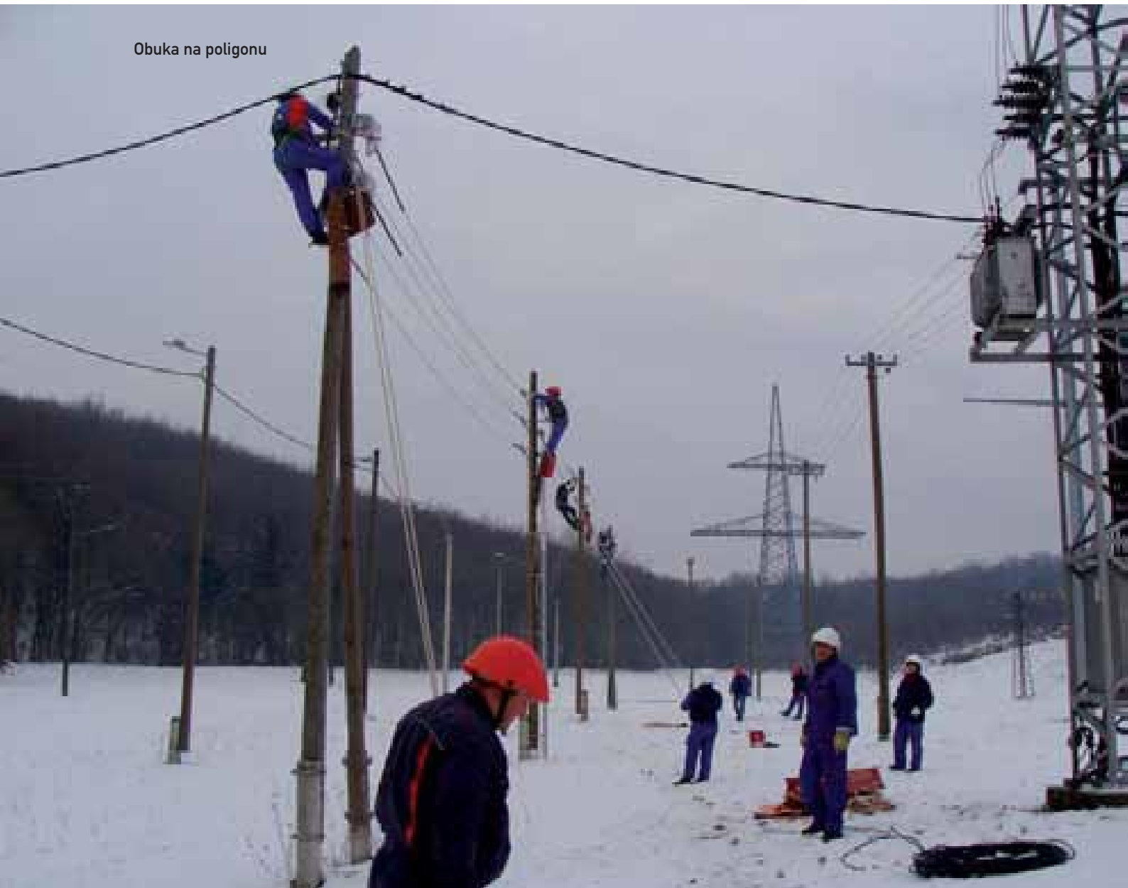
Obuka za RPN za nadzemne mreže montera Elektre Zabok
