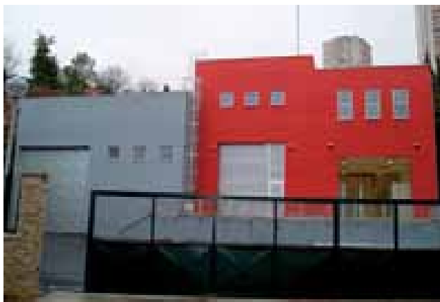
Zgrada TS 110/10(20)kV Turnić
