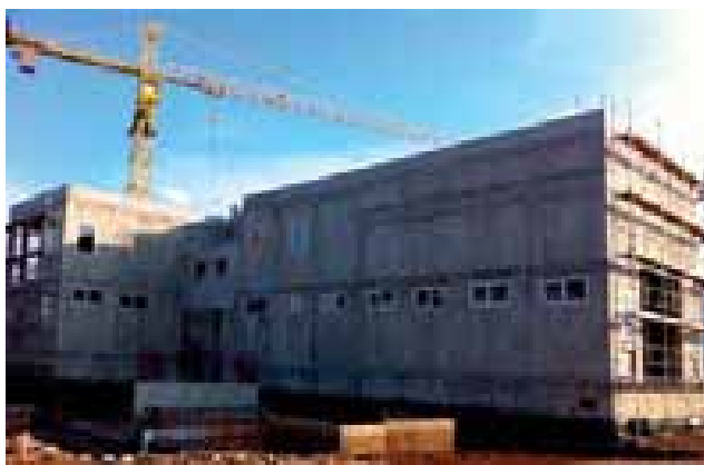
Gradilište TS 110/10(20)kV Dugopolje
