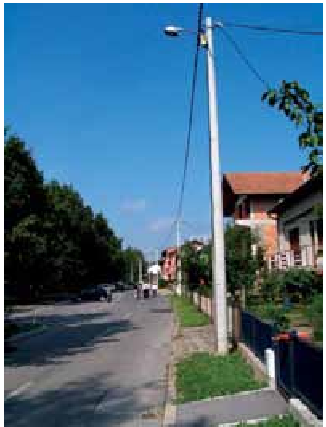
Rekonstruirani niskonaponski izvod M. J. Zagorke (od ulice Vladimira Nazora), Dugo Selo na trafopodručju TS 85 Novo Naselje Elektre Zagreb. Pogona Dugo Selo
