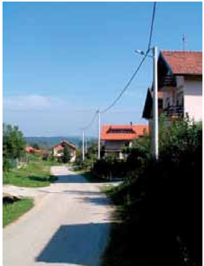
Rekonstruiran niskonaponski izvod Martinići na trafopodručju TS 109 Vučak 2 Elektro Zabok
