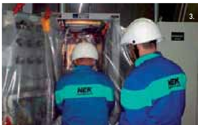
1. RPN na unutrašnjim instalacijama izvode monterii Elektrodalmacije Split ...
