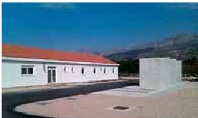
Zgrada TS 35/10(20)kV Seline
