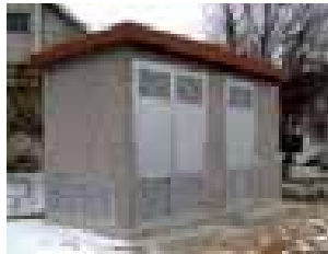
Nova KTS 20 kV i kompaktno rasklopište 20 kV na području Krapinskih toplica
