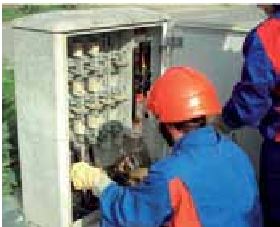
Monteri Elektre Koprivnica izvode RPN na kabelskoj i...
