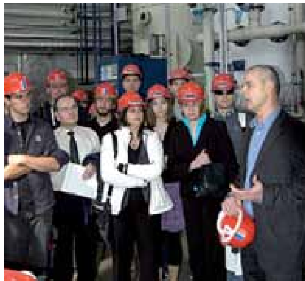
Studenti su svoj obilazak započeli u suvremenom, ekonomičnom i pouzdanom postrojenju za kemijsku pripremu vode
