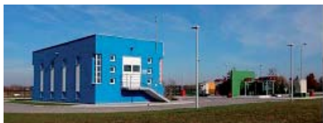
Zgrada TS 35/10(20)kV Čakovec - Istok
