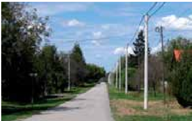
Rekonstruirani niskonaponski izvod prema Selu na trafopodručju Žlebina 2 - Majkovac. Elektro Virovitica
