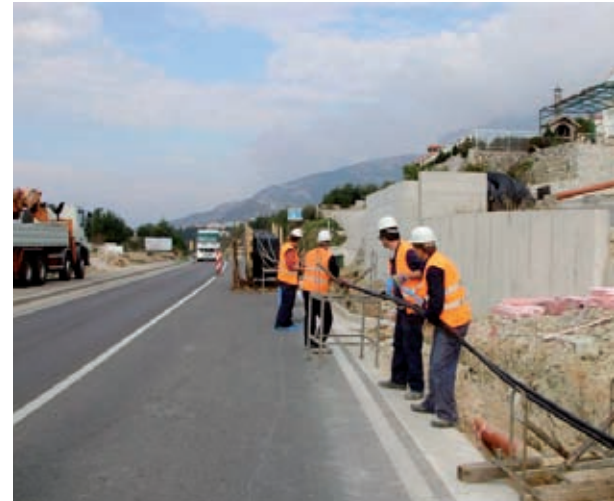
Zaposlenici Odjela građenja splitske Elektrodalmacije polažu kabel 10(20) kV u Makarskoj
