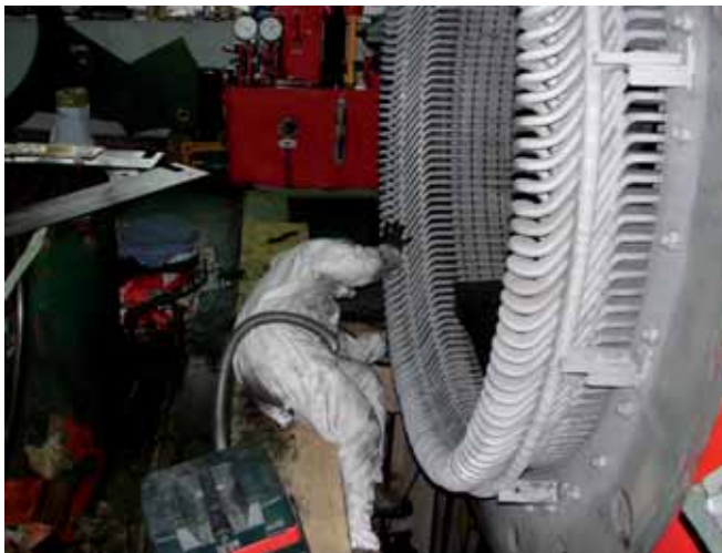
Čišćenje statora generatora B prije defektaže
