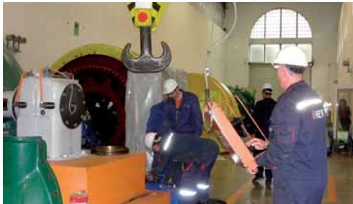
Na agregatu B obavljen je kapitalni remont, a na opremi agregata A, C i D pregledni remont u okviru preventivnog održavanja
