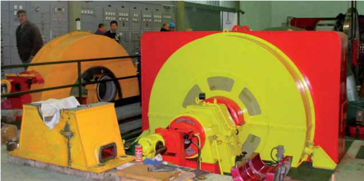
Čišćenje statora generatora B prije defektaže
