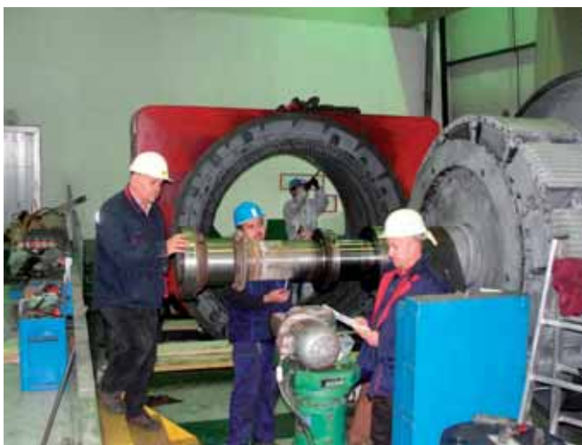
Remont oba agregata obavila je tvrtka MG Servis, a poslove je nadgledao koordinator remontnih poslova Goran Laušić
