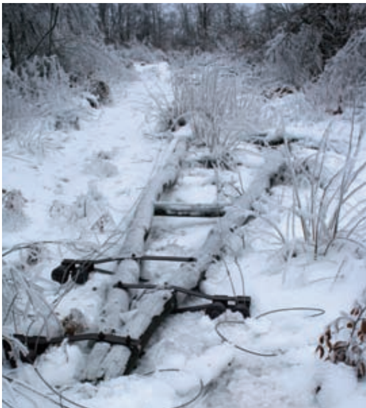
Drveni stupovi niskonaponske mreže na tlu - u snijegu i ledu ili ih (još) u zraku drže vodiči, a takvih je na području Korenice i Donjeg Lapca više stotina
