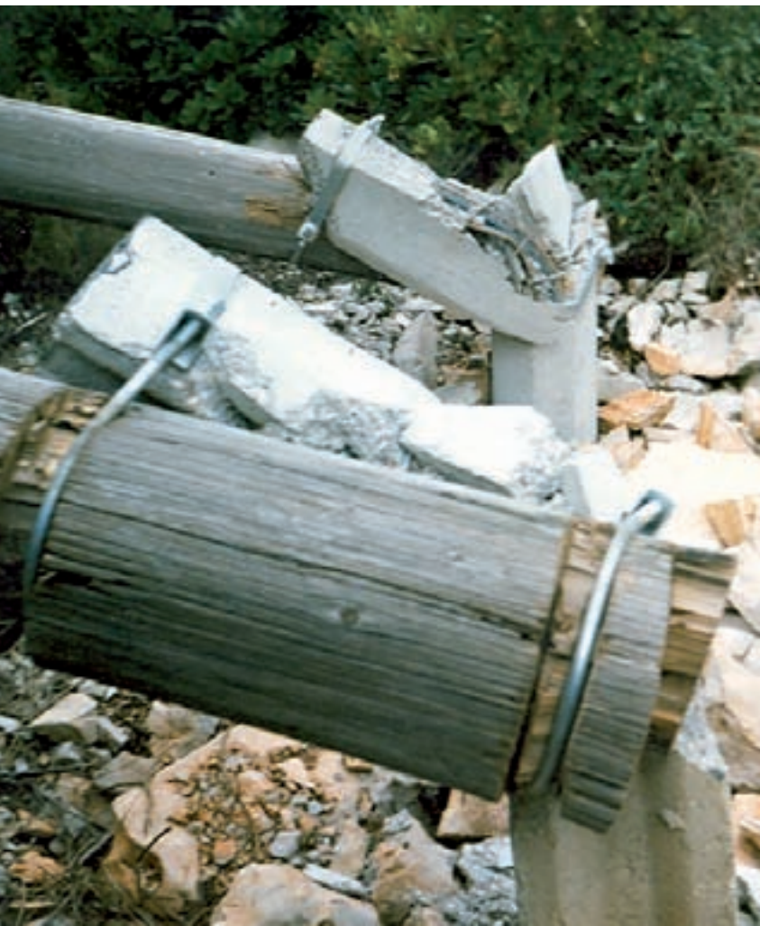
Vole ih gromovi, ali i jugo i premda drvene stupove učvršćuju betonskim nogarima, vjetar ih lomi kao od šale
