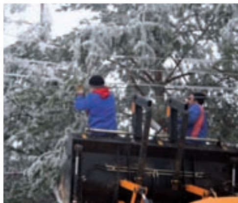
Uz upaljena svjetla kamiona, ponajprije treba osloboditi vodiče od leda, a potom odrezati zaleđene grane koje su zarobile žice, kako bi put električnoj energiji bio slobodan
