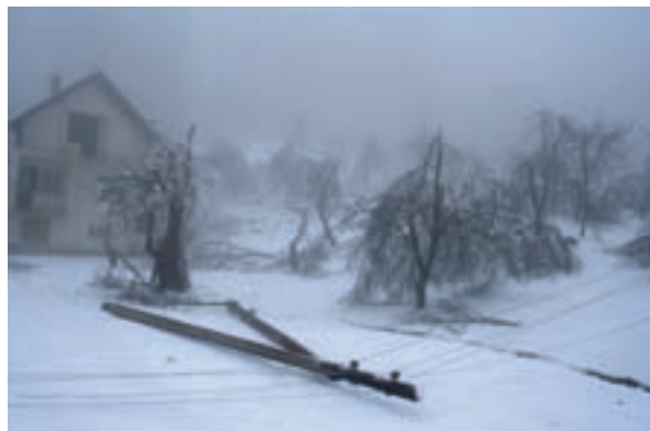
Drveni stupovi niskonaponske mreže na tlu - u snijegu i ledu ili ih (još) u zraku drže vodiči, a takvih je na području Korenice i Donjeg Lapca više stotina
