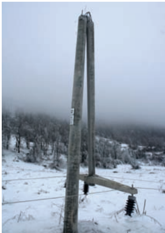
Ledena masa prepolovila je armiranobetonski stup, a susjednom odlomila konzolu
