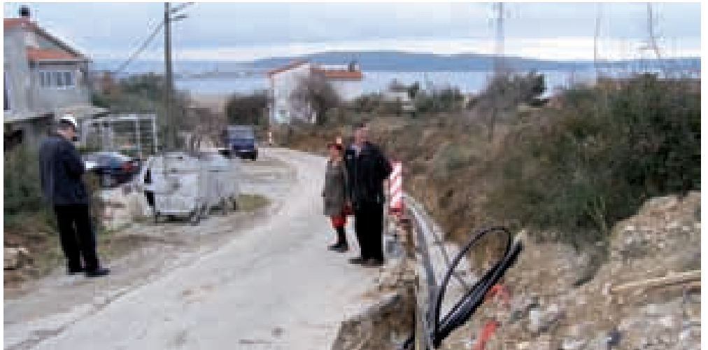
Kabelska trasa u Kaštel Sućurcu s pogledom na Split - voditelj i nadzorni inženjeri nadgledaju posao
