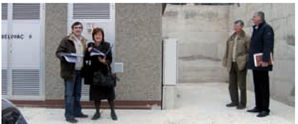
Ekipa za očevid novoizgrađene tipske TS 10(20)/0,4 kV Kambelovac 6: Ž. Strize, M. Bareta-Buličić, B. Škara i N. Favro
