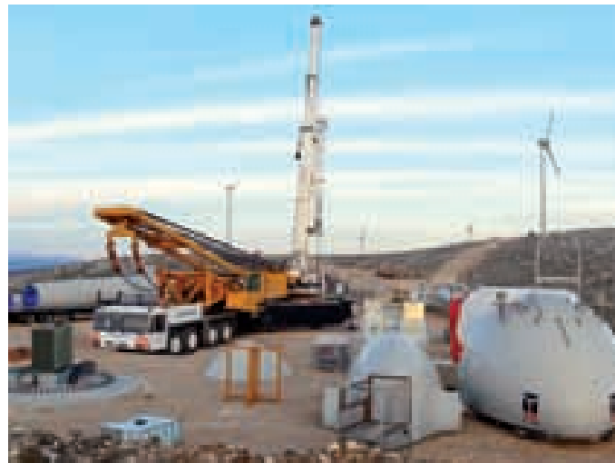
Izgradnja Vjetroelektrane Orlice započeta je u studenom 2008., a dovršenje se planira (ako to dopuste vremenske okolnosti) do kraja travnja ove godine
