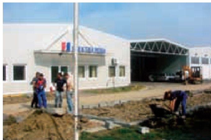
Ispred ulaza u novi Poslovni skladišni objekt uređuje se okoliš
