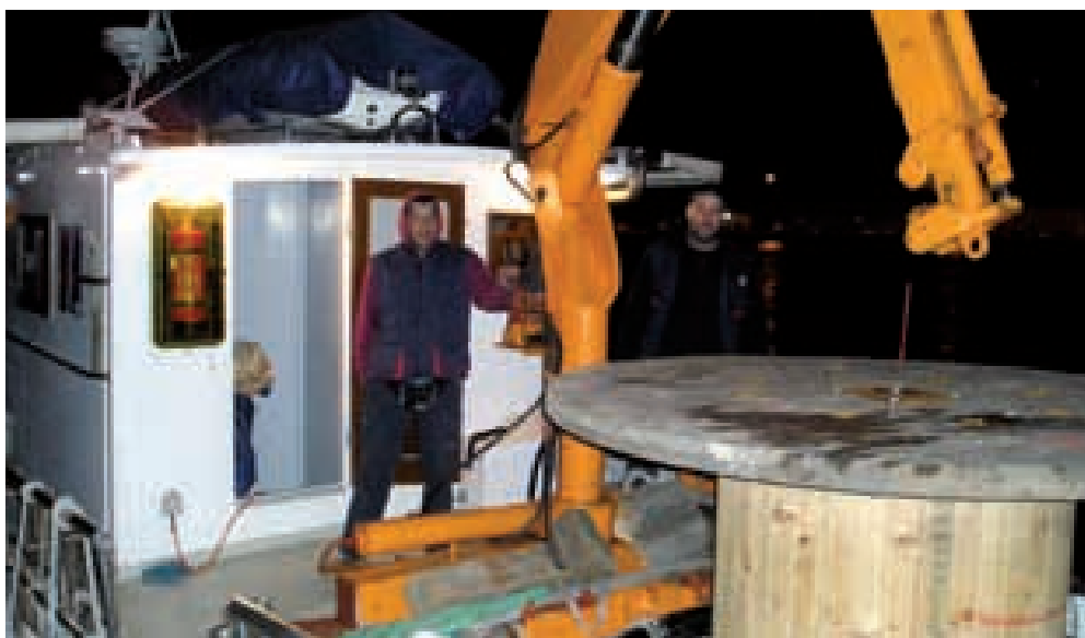
Posada broda Elektre Zadar Sv. Krševan vraća nepoloženi dio kabela u zadarsku marinu po mraku
