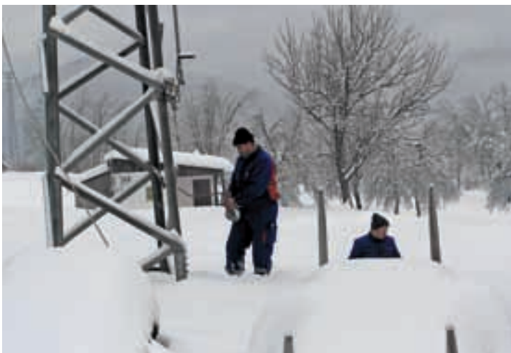
Intervencija u duboku snijegu oko čelično-rešetkastog stupa
