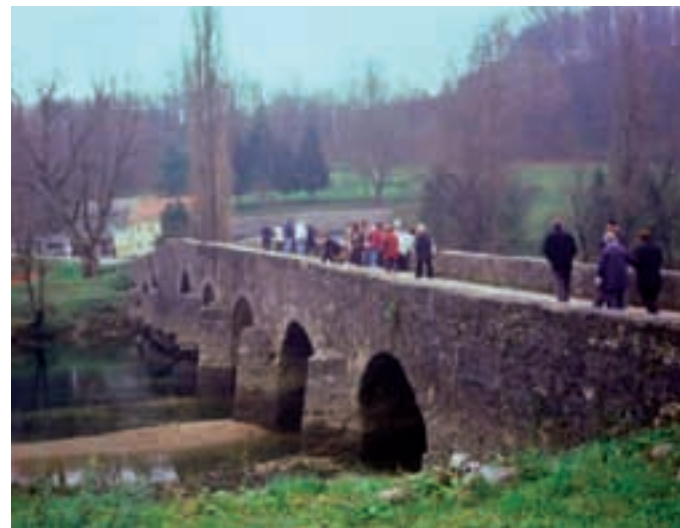
Kameni most dug 122 metra na rijeci Dobri jedan je od najstarijih kamenih riječnih mostova i spomenik stare hrvatske mostogradnje
