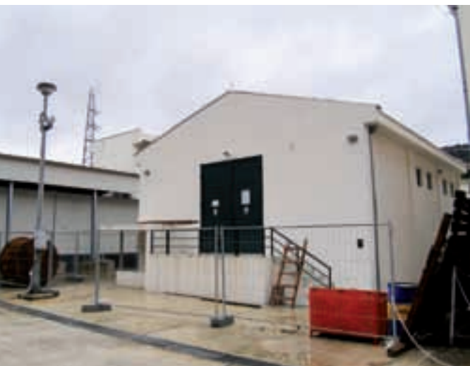
Rasklopište u Komolcu dobilo je i novo 35 kV postrojenje (lijeva zgrada kontejnerskog tipa)
