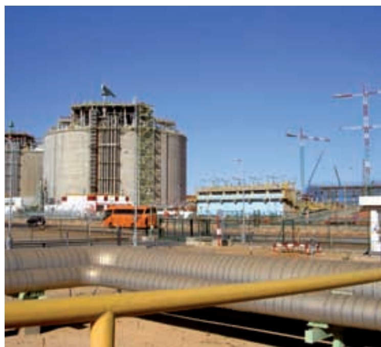
Spremnici LNG-a kapaciteta 150 tisuća m 3 , isparivač za uplinjavanje, a u pozadini je novi spremnik LNG terminal Huelva u izgradnji
