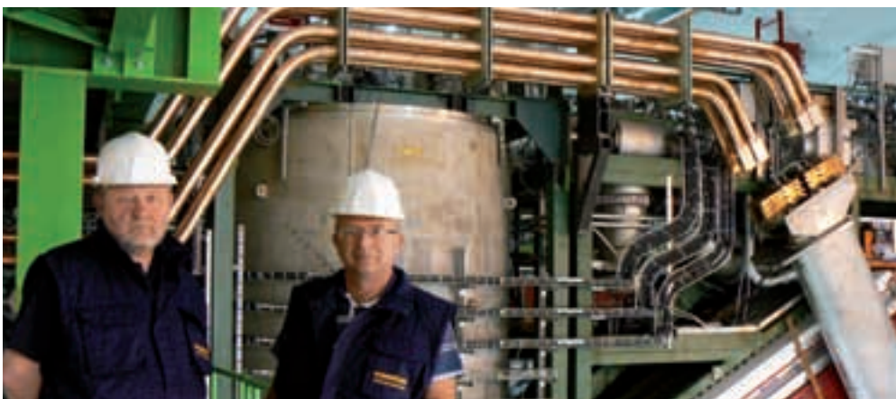
Zlatko Završki, rukovoditelj PJ Proizvodnja i Leopold Klauzer, rukovoditelj PJ Tehnički sektor osobno su nadgledali rad njihovih ljudi na terenu i suočavali se sa stručnim dvojabama koje je trebalo riješiti brzo i učinkovito
