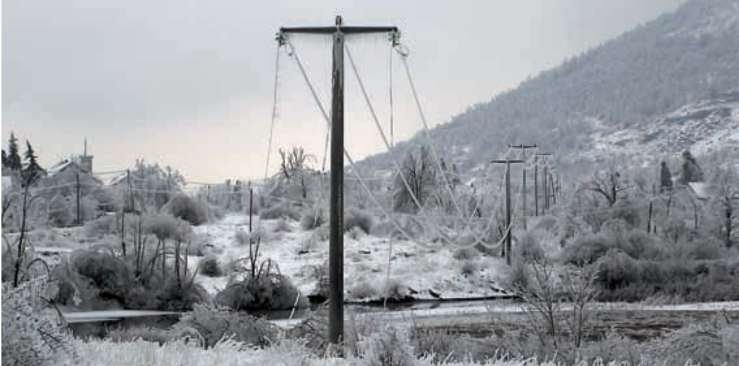
Vodiči pod teretom leda i snijega izduljeni skoro do tla...
