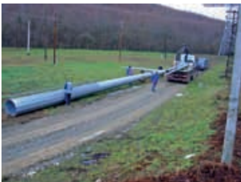
Monteri Dalekovoda, HEP NOC-a i Elektre Požega sastavljaju posljednji visokonaponski stup na poligonu
