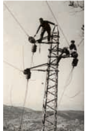
Izgradnja DV 35kV Blato-Korčula
