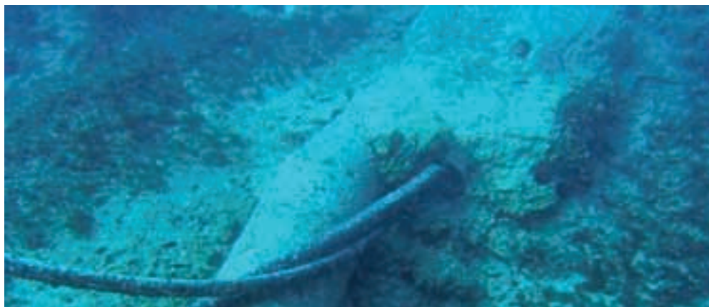
Ulazak 10 kV kabela u priobalnu zaštitu na Drveniku Malom
