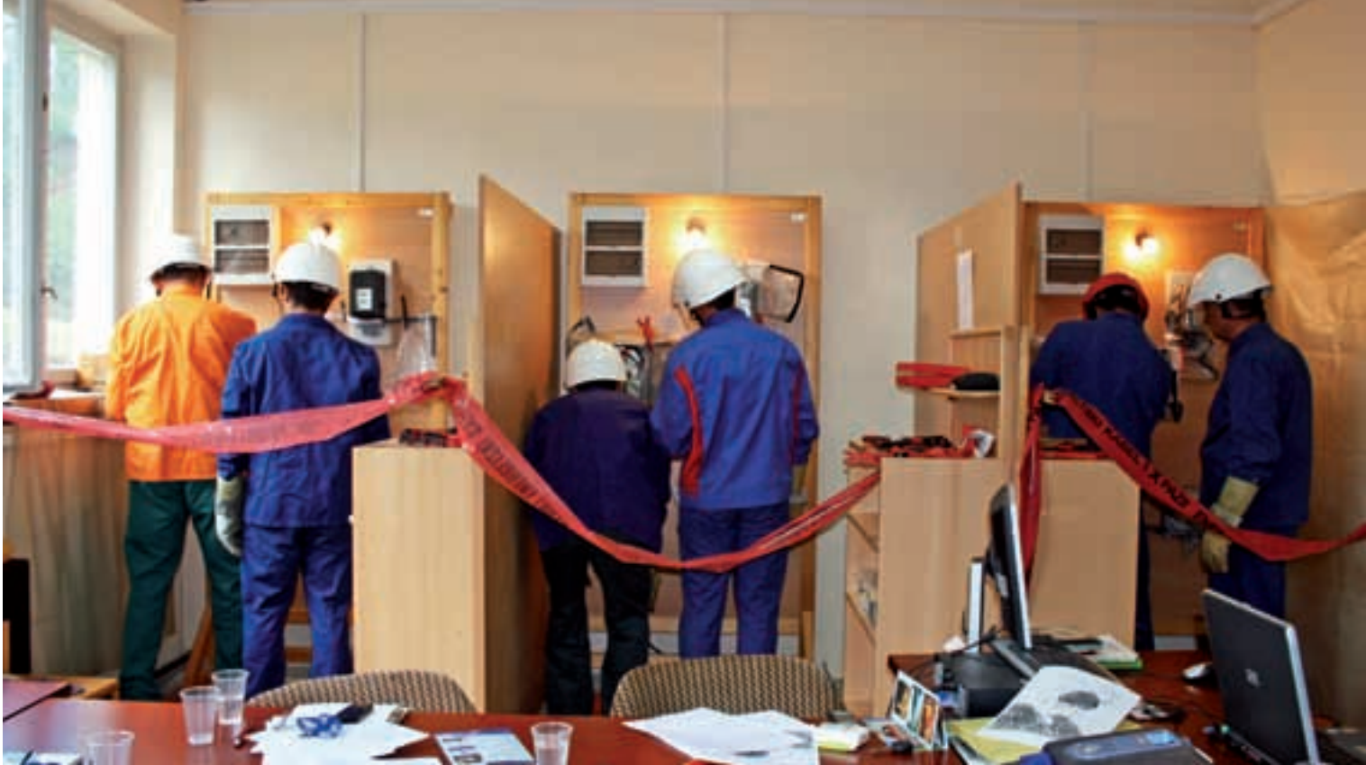
Monteri Hrvatskih autocesta mijenjaju KPTO pod naponom
