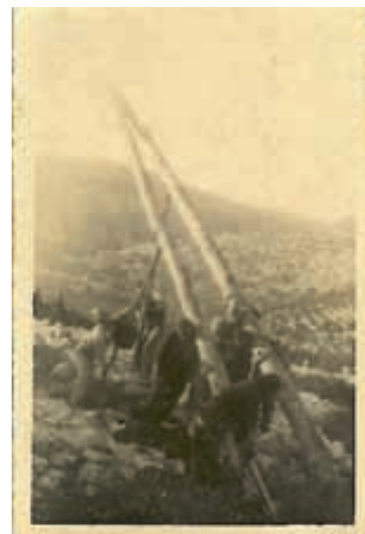
Podizanje stupa za DV 10 kV Blato – Smokvica 1948. godine, kada su koristili stabla freškega bora, koja su bila puna smole pa su im seljani donosili benzin da se nakon posla očiste
