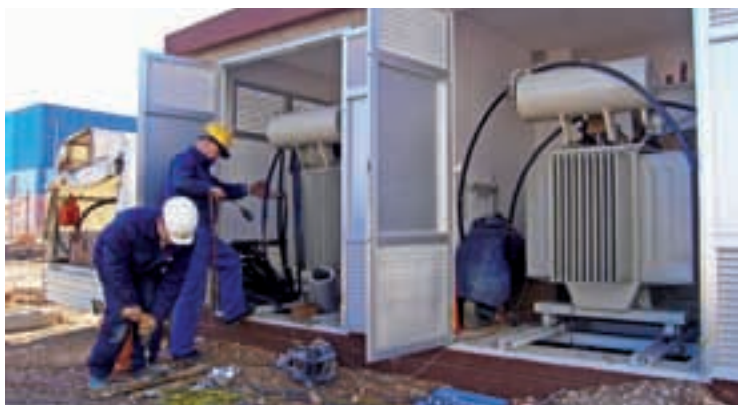
Monterka ekipa Službe izgradnje Elektrodalmacije pri montaži u TS Podi 14
