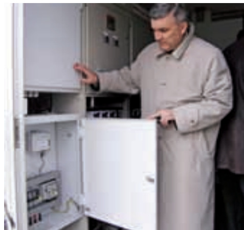
Svi potrošači na srednjem naponu i svi crveni u kategoriji 0,4 imaju ugrađena elektronička brojila s daljinskim očitanjem, a jedno od njih nam je pokazao N. Milić
