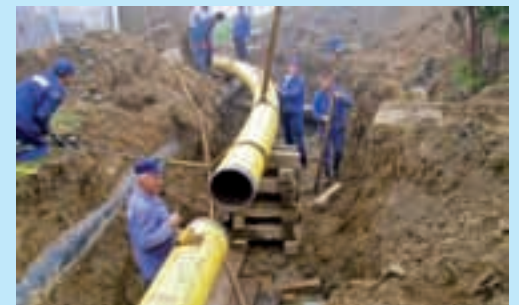
Izgradnja visokotlačnog plinovoda za potrebe TE Sisak
