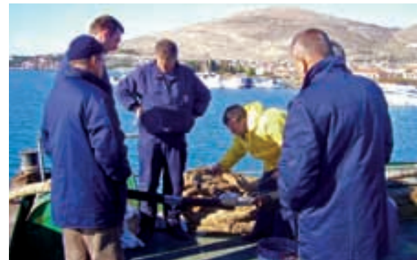
Dečki iz Elektrodalmacijinog Odjela za održavanje kabela Službe održavanja, odstranili su neispravan dio kabela, a onaj zdravi ponovno spojnicama povezali i vratili u more
