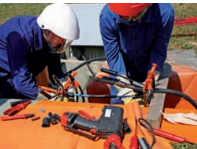
Izrada kableske spojnice pod naponom – monteri Hrvatskih autocesta
