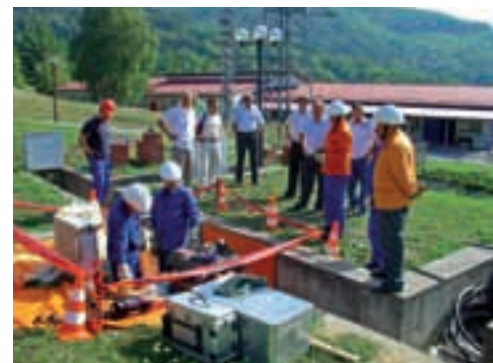
Kolege iz Elektroenergetskog inštituta „Milan Vidmar“ promatraju rad pod naponom montera Hrvatskih autocesta
