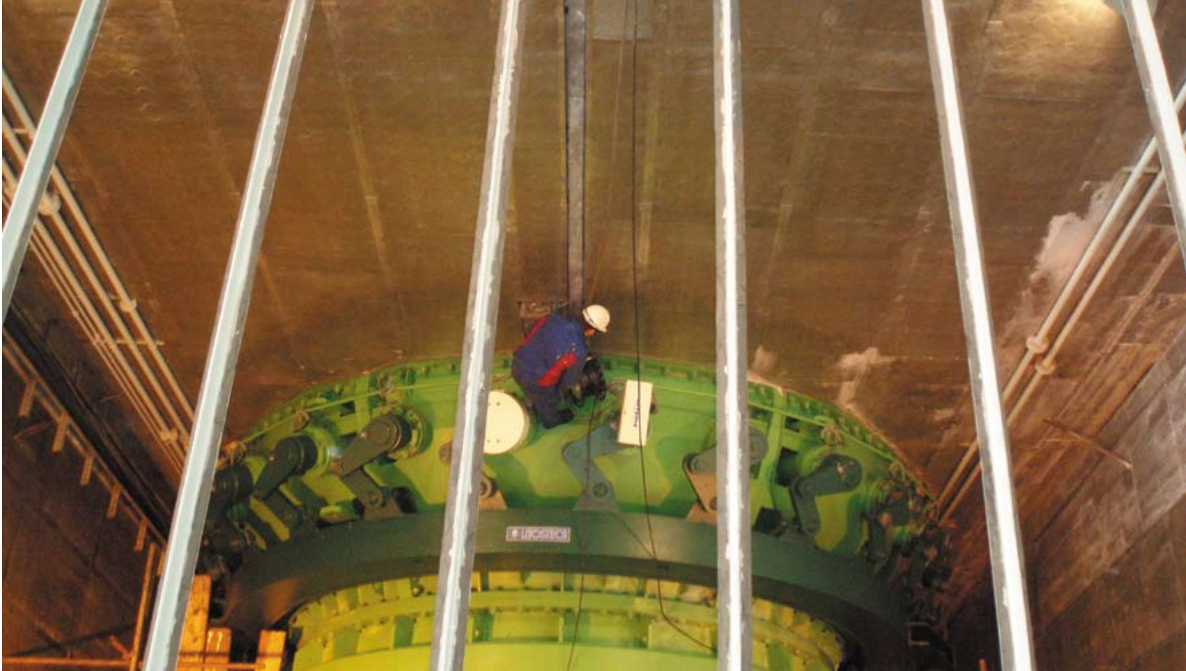
Stručnjak Kočarovog Instituta radni dan proveo je u „kruški“ ispitujući izolacijski sustav generatora
