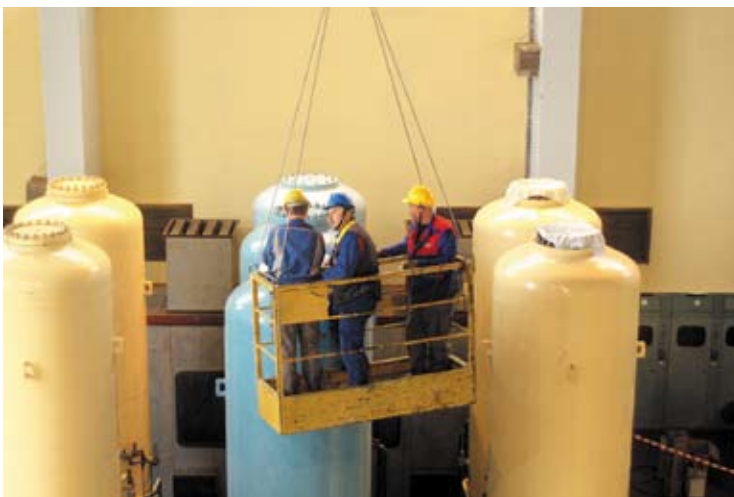
Ivica Špoljarić sa stručnjacima iz Državnog inspektorata obavlja pregled posuda pod tlakom
