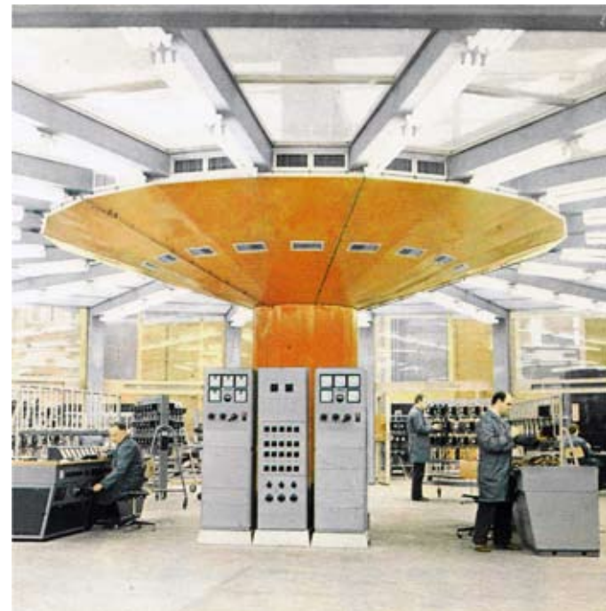
Baždarnica brojila u Pogonu pomoćnih djelatnosti (1970. godine) s vrlo originalnim rješenjem klimatiziranog prostora, oblika poput staklene torte, izvedene unutar hale
