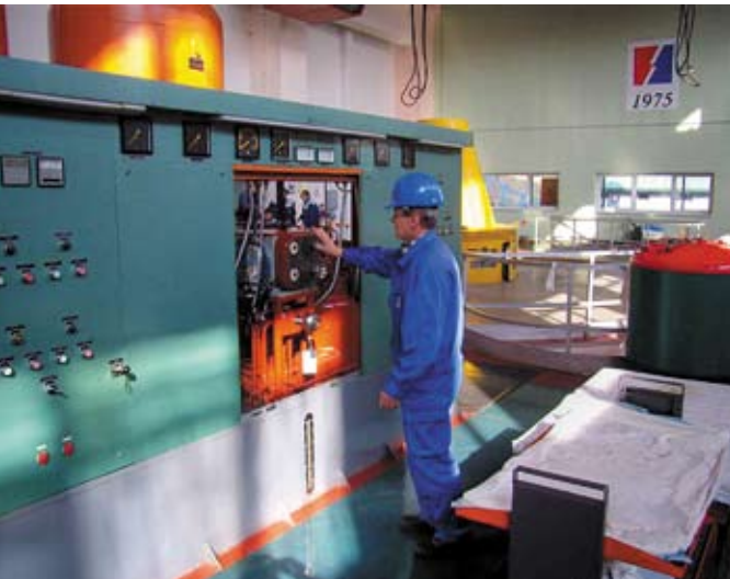
Majstor za turbine Mirko Balažinec ispituje turbinsku regulaciju
