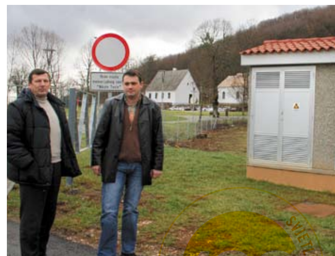
Rukovoditelj Službe za izgradnju Nikola Šulentić i rukovoditelj Odjela za održavanje ispred novoizgrađene trafostanice iz koje se napaja Memorijalni centar Nikola Tesla
