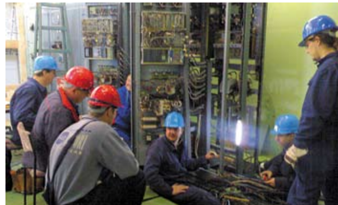
Radi se na zamjeni stare uzbuđe generatora
