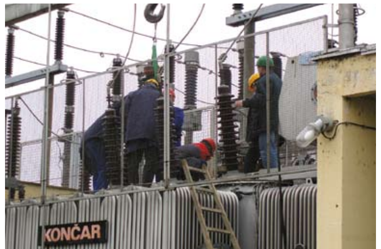
Radovi na BT agregata A
