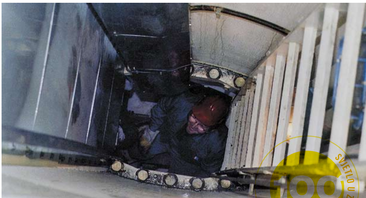
U ulaznom oknu za generatorski prostor zatekli smo predradnika Vladu Najmana
