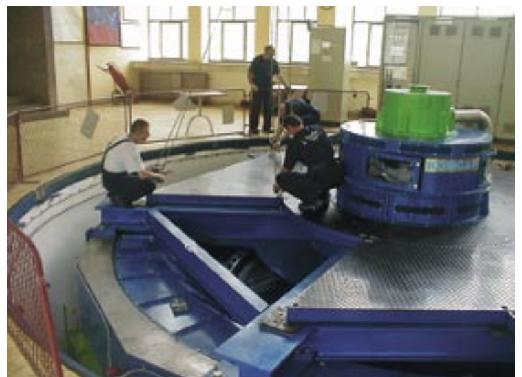
Pripreme za demontažu generatora
