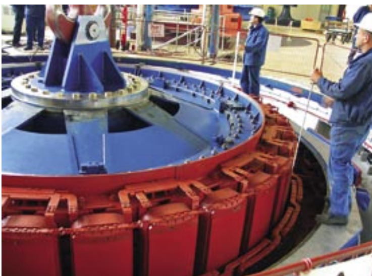
(Ponovna) montaža rotora generatora
