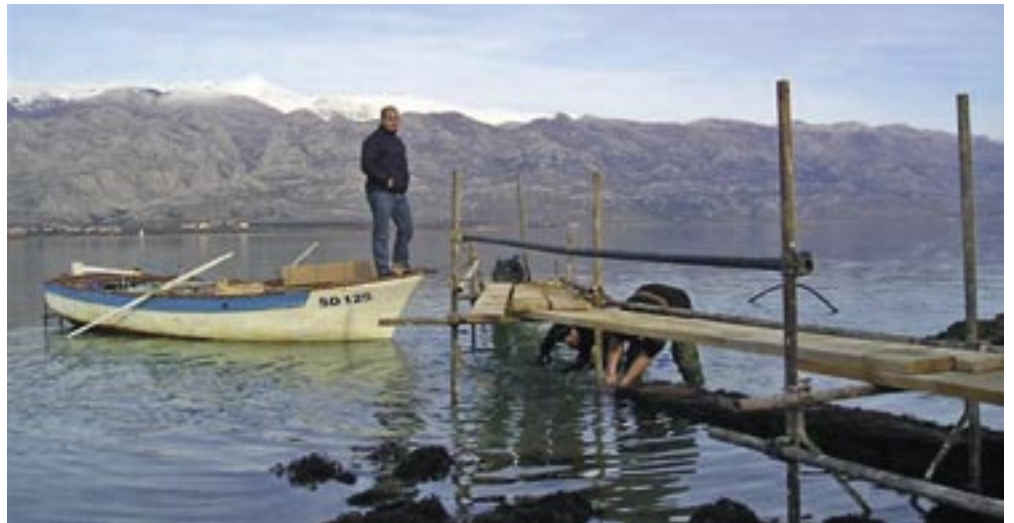
Popravak kabela uz vinjeračku obalu, ali opet kao privremeno rješenje
