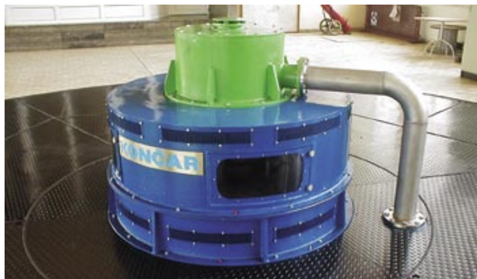
Novi generator u pogonu – jednaki volumen – veća snaga
