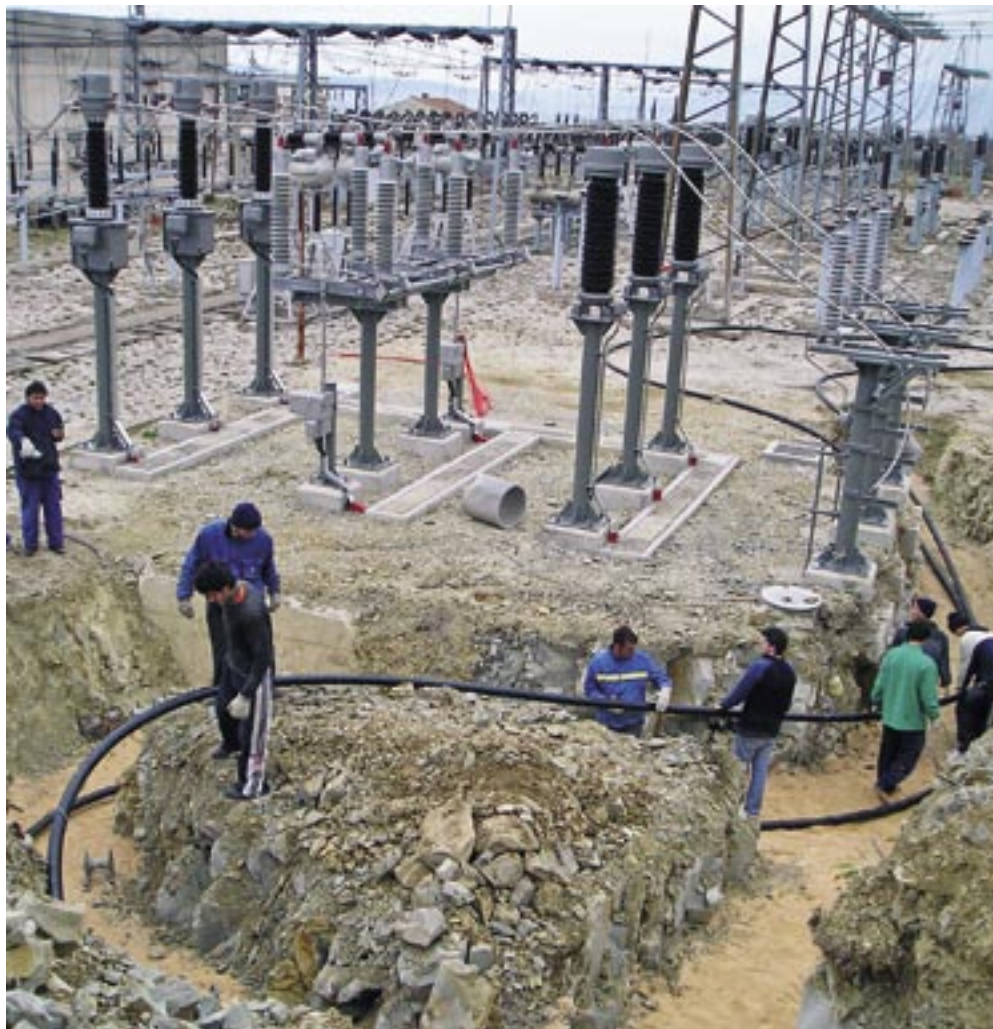
Posljednji metri kabela ulaze u vanjsko postrojenje TS 110/35 kV Kaštela
