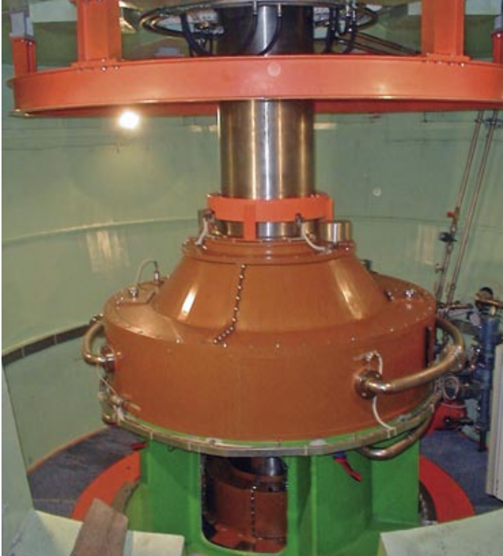
Spoj nove turbine i generatora
