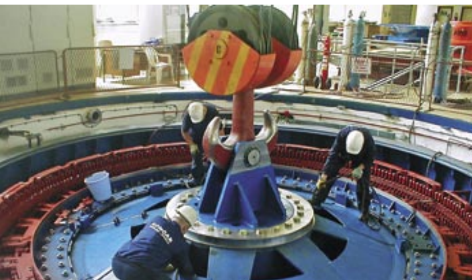
Montaža generatora
