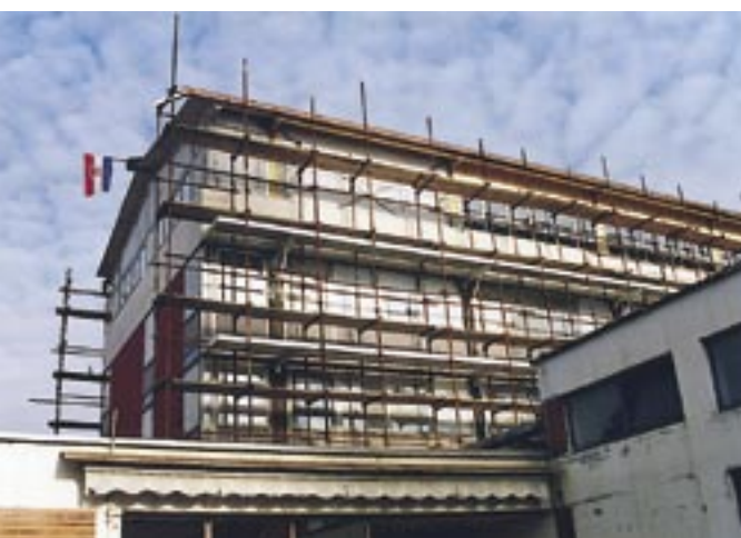
U tijeku su i građevinski radovi na upravnoj zgradi TE Sisak
