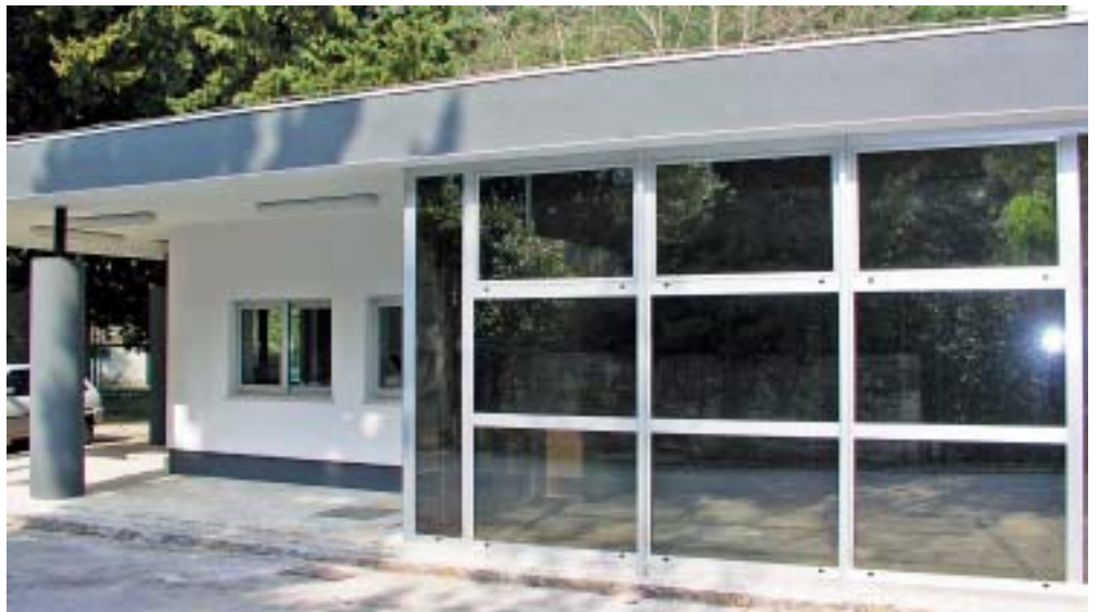
Višenamjenska obnovljena vratarnica za pravi prvi dojam posjetitelja HE Zakućac
