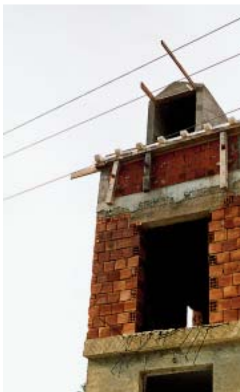
Elektroenergetski vod ispred prozora
