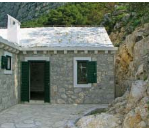
Bijele kamene ploče "uvezene" s Brača pokrivaju krov objekta P1
