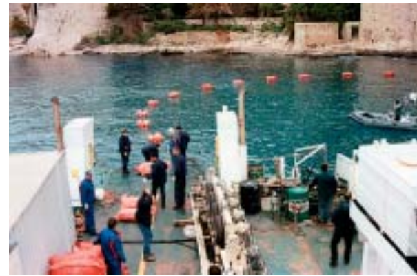
Kabel se usmjerava prema kopnu i mjestu povezivanja s "kopnenim" srodnikom
