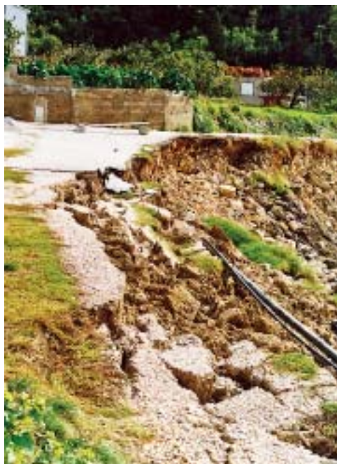
Iskopavanjem temelja za kuću u Slanom iskopali kabel
