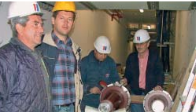
Četvorica od sedmeročlanog stručnog tima Službe za izgradnju i usluge DP Elektrodalmacija Split u TS 110/(10)20kV Sušak
