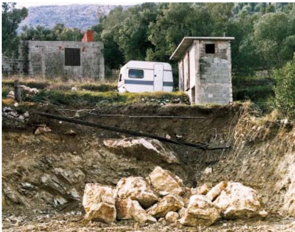
Uništen stup 10 kV radi izgradnje kuće u Zatonu kod Dubrovnika
