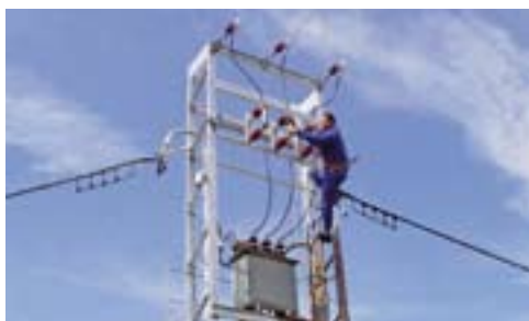
Zaštita vodiča i izolatora na zračnom dalekovodu 10 kV Slobodna Vlast
