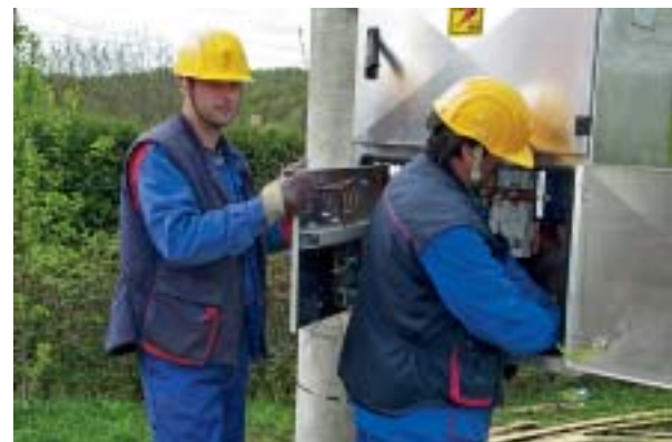
U mjestu Pustike majstor Mato Gjurašić i KV monter Josip Mirenić spajaju glavni vod i uzemljenje u novoj stupnoj trafostanici
