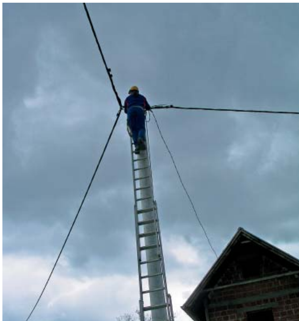
Robert Preložiček, KV monter u vikendaškom naselju Gradec, gdje je prvi put stigao pravi napon i priključuju se novi potrošači HEP-a
