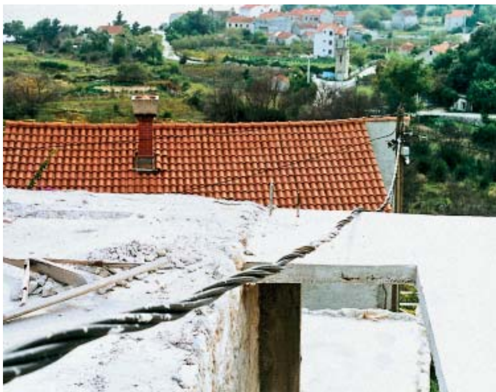
Kuća u Slanom je narasla do našeg voda, koji šeta po krovu
