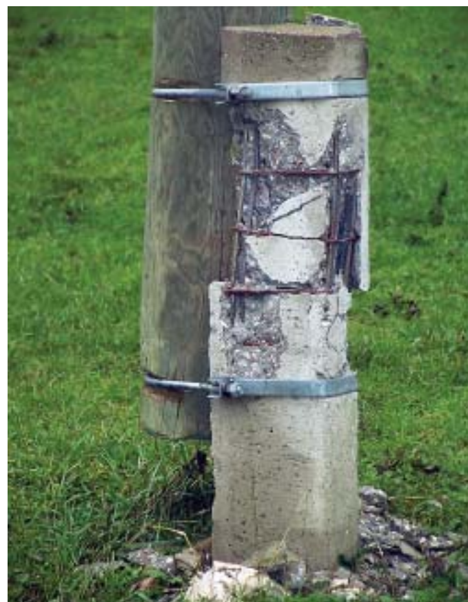
Premda nevjerojatno, istinito je da je bura bila jača i od armiranog betona
