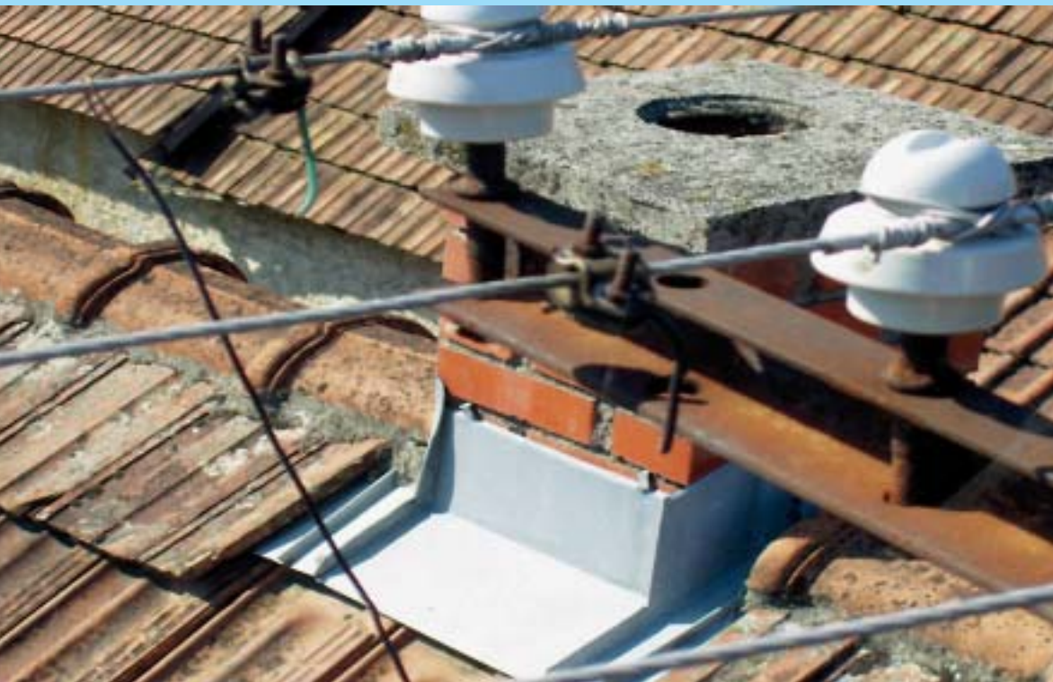
Pecaljke za izravni neovlašteni priključak i neovlaštenu potrošnju
