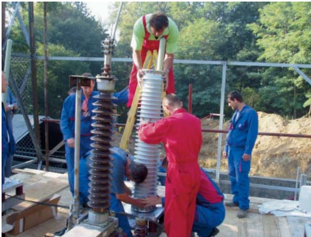
Montaža polimernog izolatora (kućišta)
