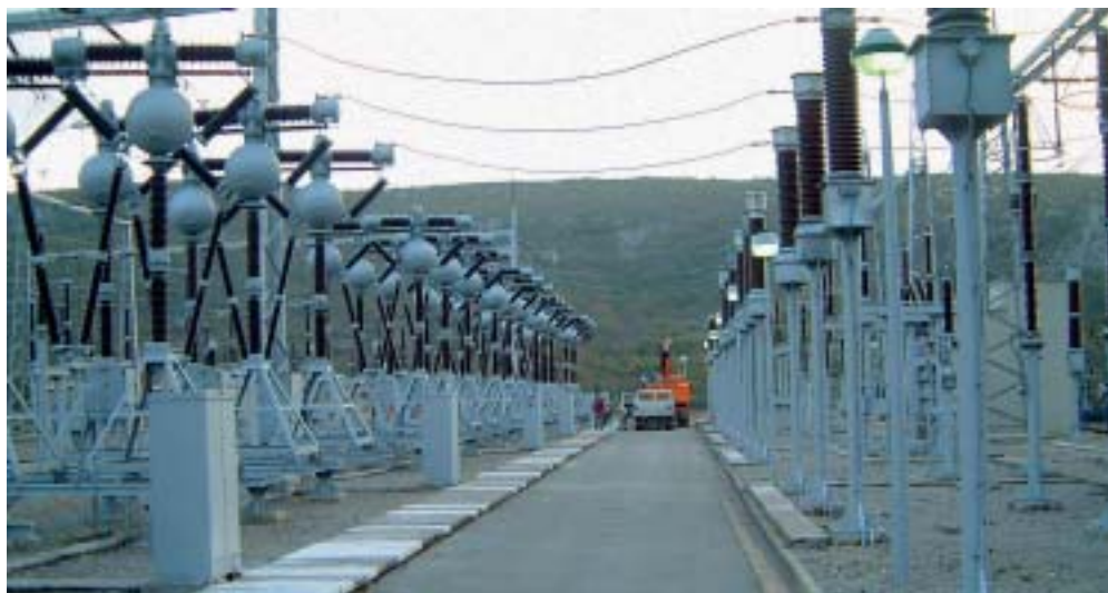
Obavljena je i revizija prekidača u rasklopnom postrojenju 220 kV
