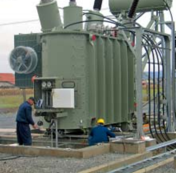
Završni radovi na transformatoru i drugim djelovima postrojenja pred privremeno puštanje postrojenja u pogon tijekom božićno-novogodišnjih blagdana
