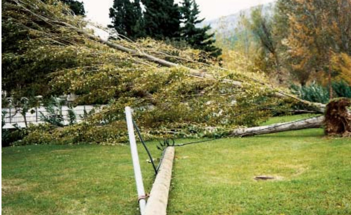
Stup, vodič i topola na tlu u Solinu
