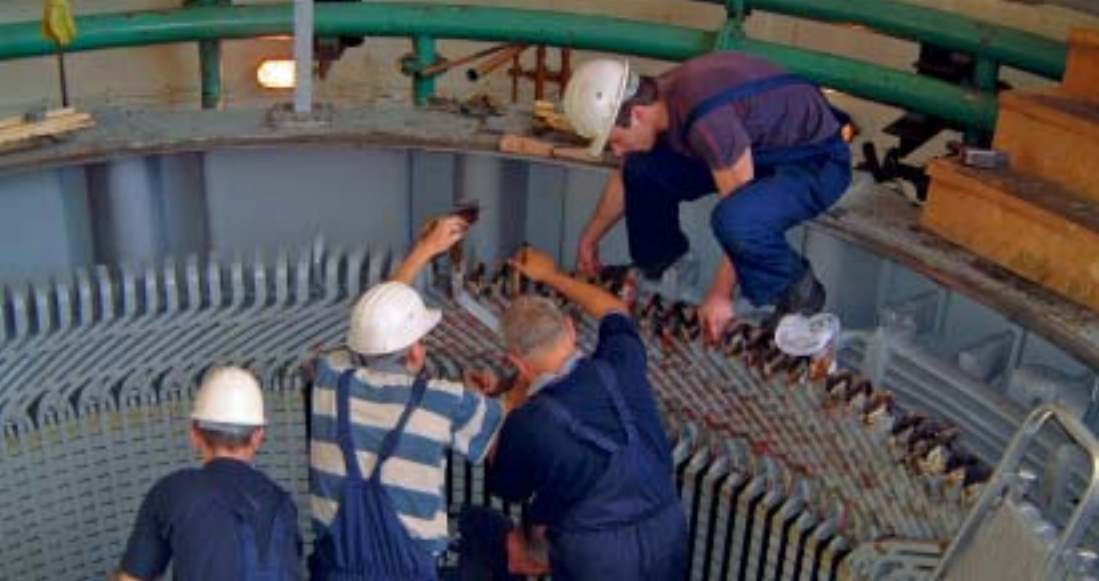
Popravlak iznenadnog kvara na generatoru C bio je nepredviđeni posao u okviru planiranih aktivnost
