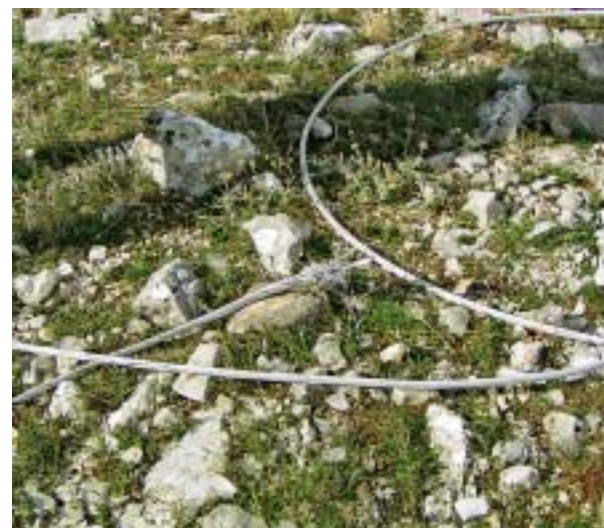
DV 110 kV Peruča-Buško Blato – vodiči na zemlji
