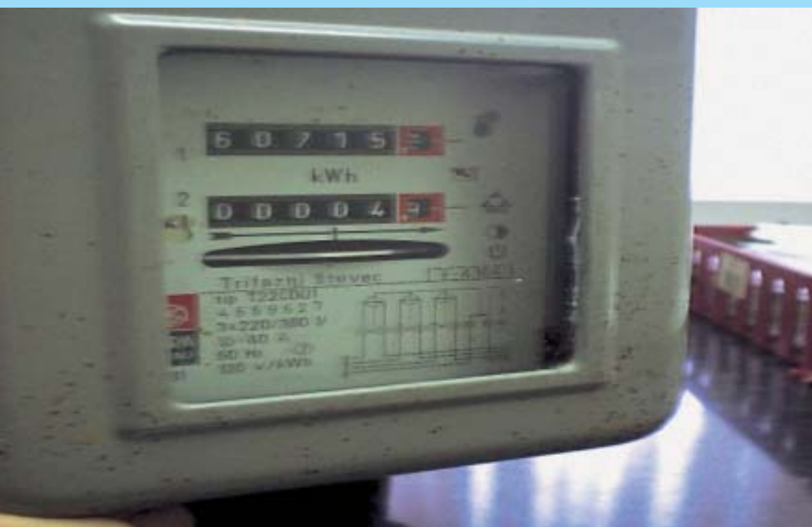
Uistinu dovitljiv način utjecanja na smanjenje registracije količine električne energije, a bez rasplombiranja brojila – uvlačenjem gubljive trake kraj stakla prozorčića sve do rotora brojila
