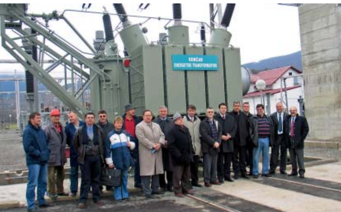
Predstavnici investitora i izvođača radova ispred transformatora
