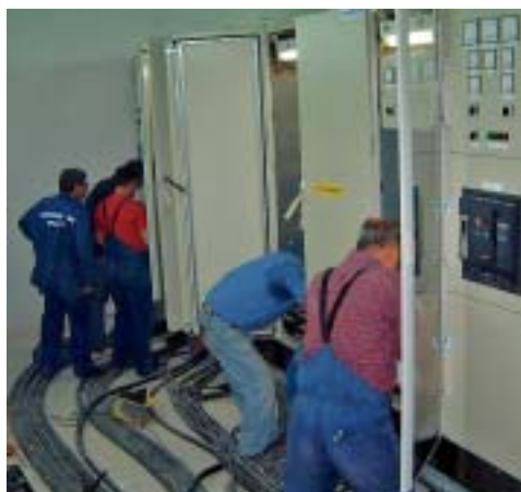
Priprema nove glavne ploče vlastite potrošnje
