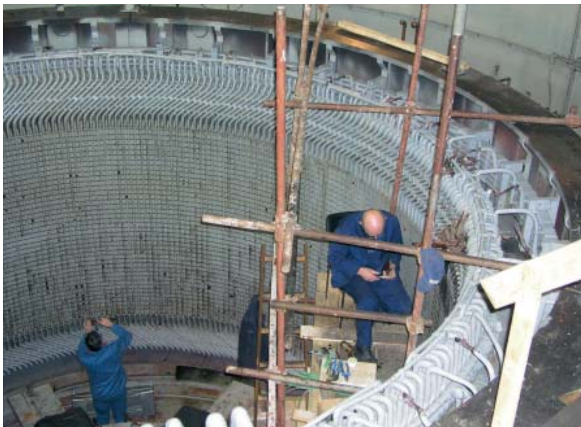
Odmah nakon registriranja kvara generator je demontiran
