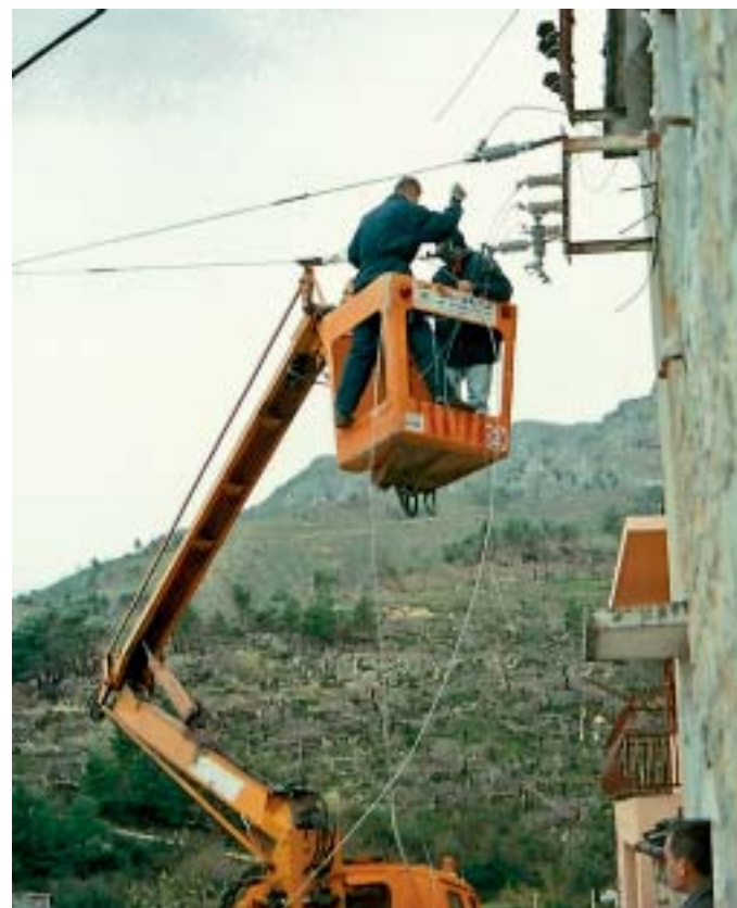
Elektromonteri Denis Bralić i Braco Barić otklanjaju kvar uz trafostanicu
