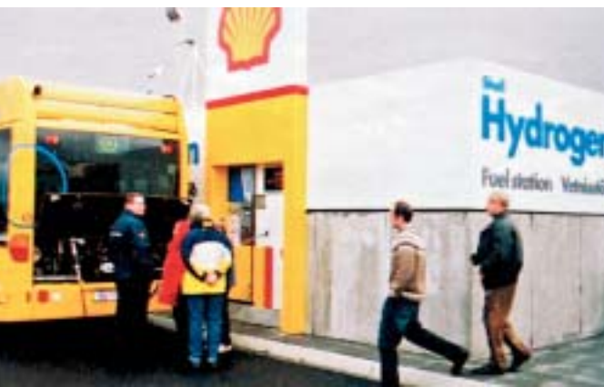
H 2 -crpna postaja u Reykjaviku. Elektrolizator u zgradi proizvodi plin na licu mjesta , a autobus može napuniti spremnik s 40 kg vodika
