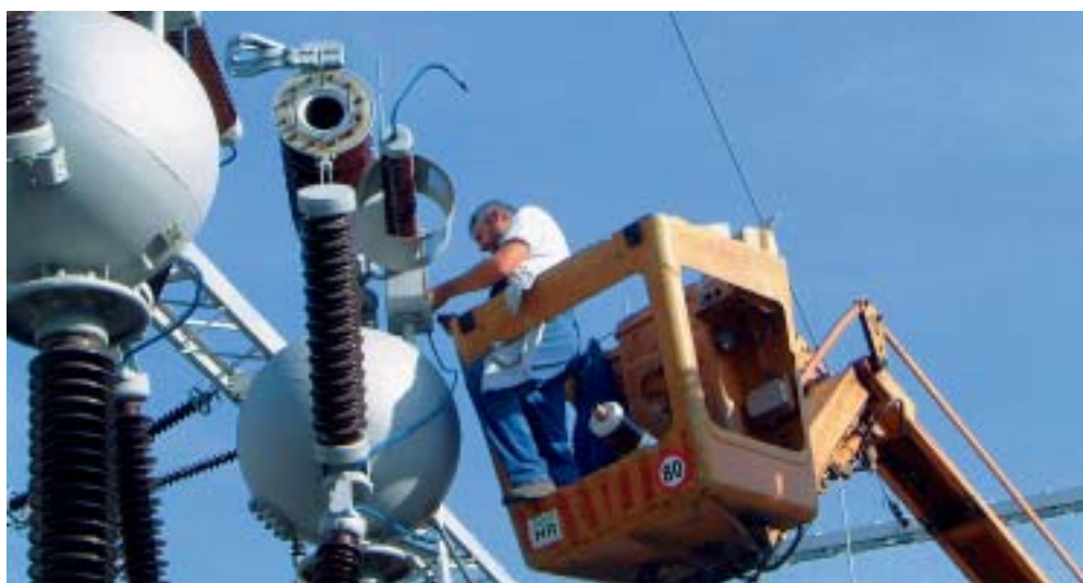
Obavljena je i revizija prekidača u rasklopnom postrojenju 220 kV
