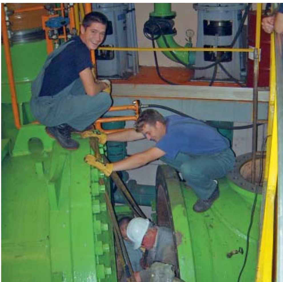
Sanacija ležišta tijela kuglastog zatvarača agregata
