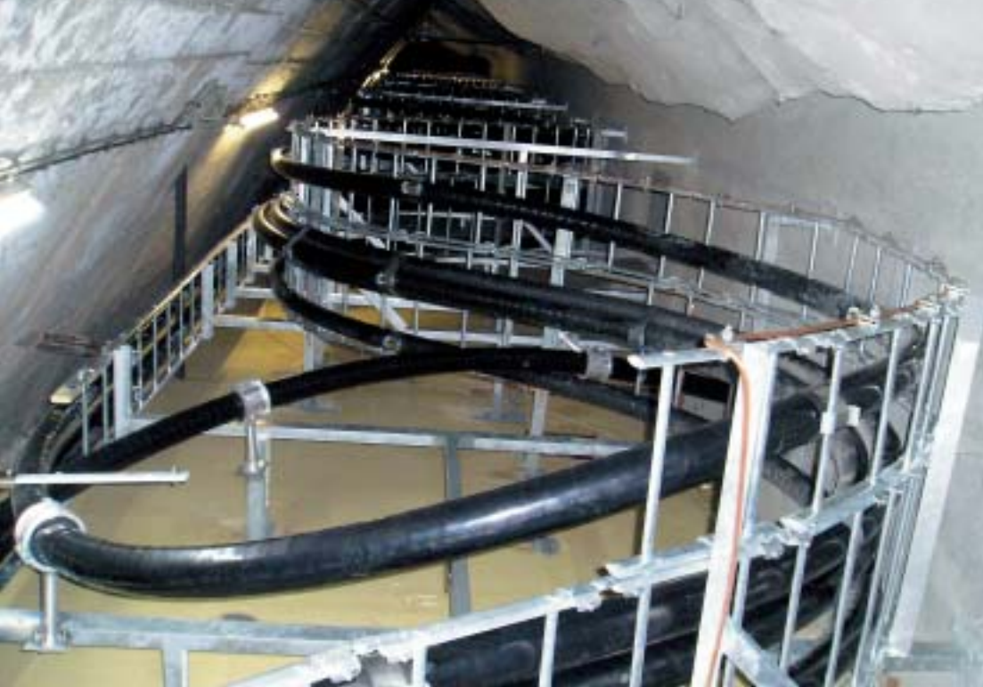
Svi kabeli 220 kV (lanjski i ovogodišnji) smješteni su na sinusoidne temelje (P6180019)
