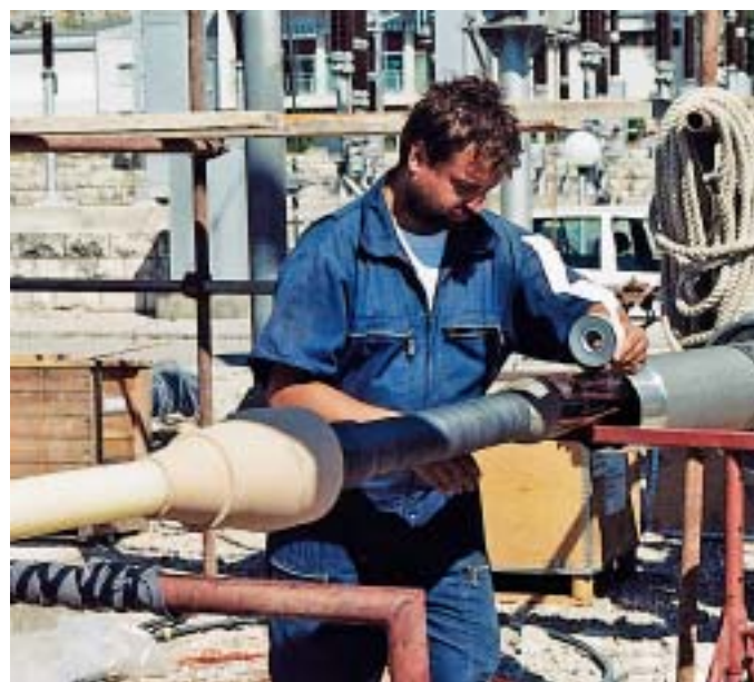
Zoran Krnčević izolira dno kableske glave
