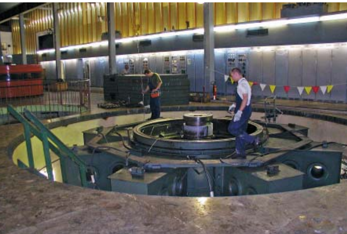
Sve poslove demontaže i montaže obavila je iskusna posada HE Zakučac: demontaža nosećega ležaja
