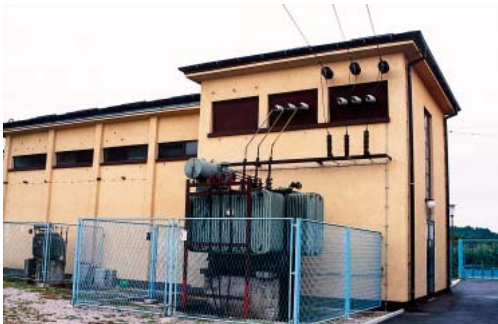
Prije dvije godine je rekonstruirana i modernizirana njihova jedina TS 35/10 kV, izgrađena davne 1965. godine
