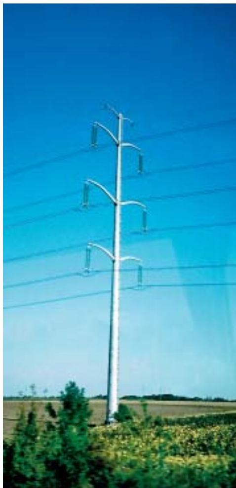
Dok radnici Sedivera prosvjeduju radi ukidanja razvoja i proizvodnje u Francuskoj, njihov kompaktni dalekovod 400 kV u dolini sigurno radi
