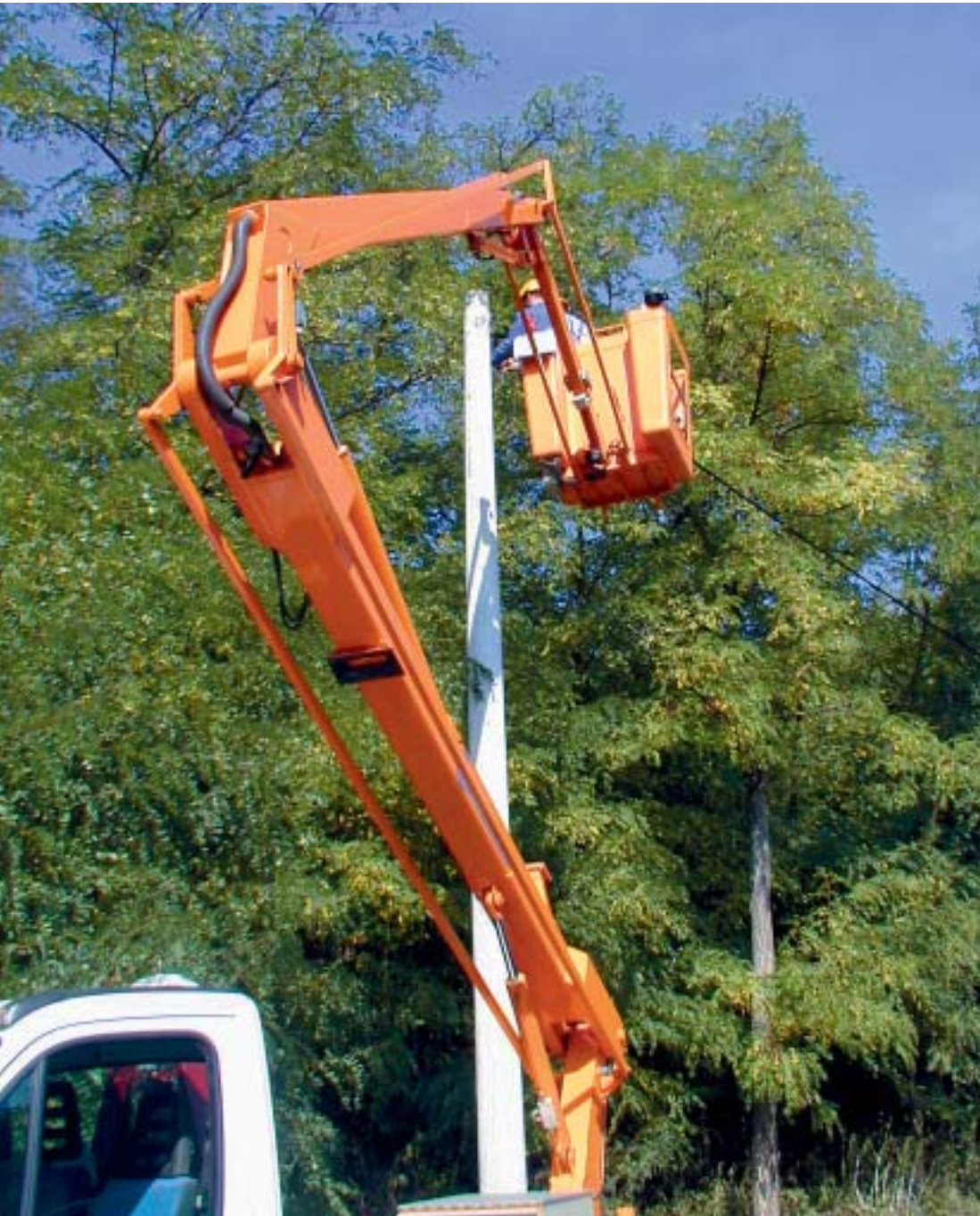
Josip Topol i Mario Kušina, KV monter, dovršavaju uzemljenje kako bi još prije berbe ovo naselje dobilo prvi napon
