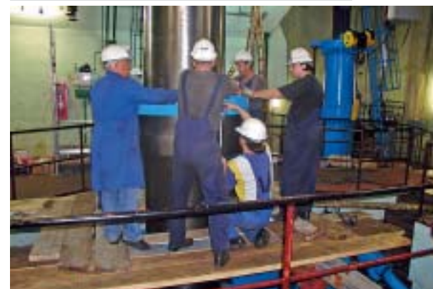
Montaža međuvratila
