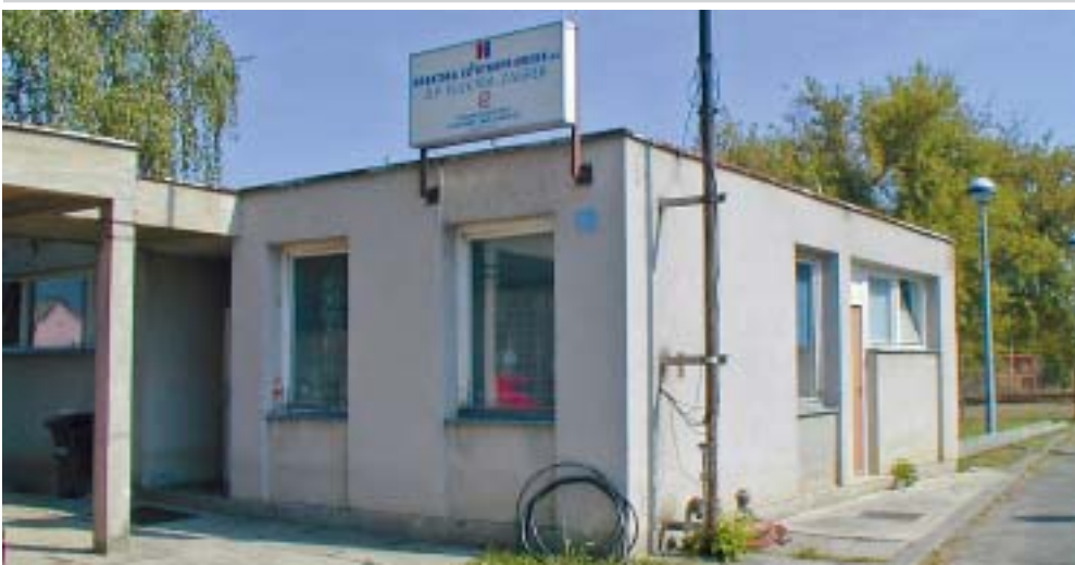
Vrbovečki elektraši smješteni su još uvijek u ovoj zgradi, staroj 40 godina
