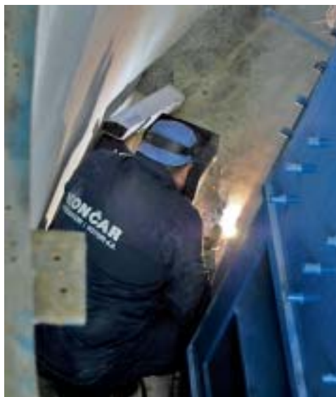
Revitalizacijski poslovi su u tijeku, montira se nova oprema
