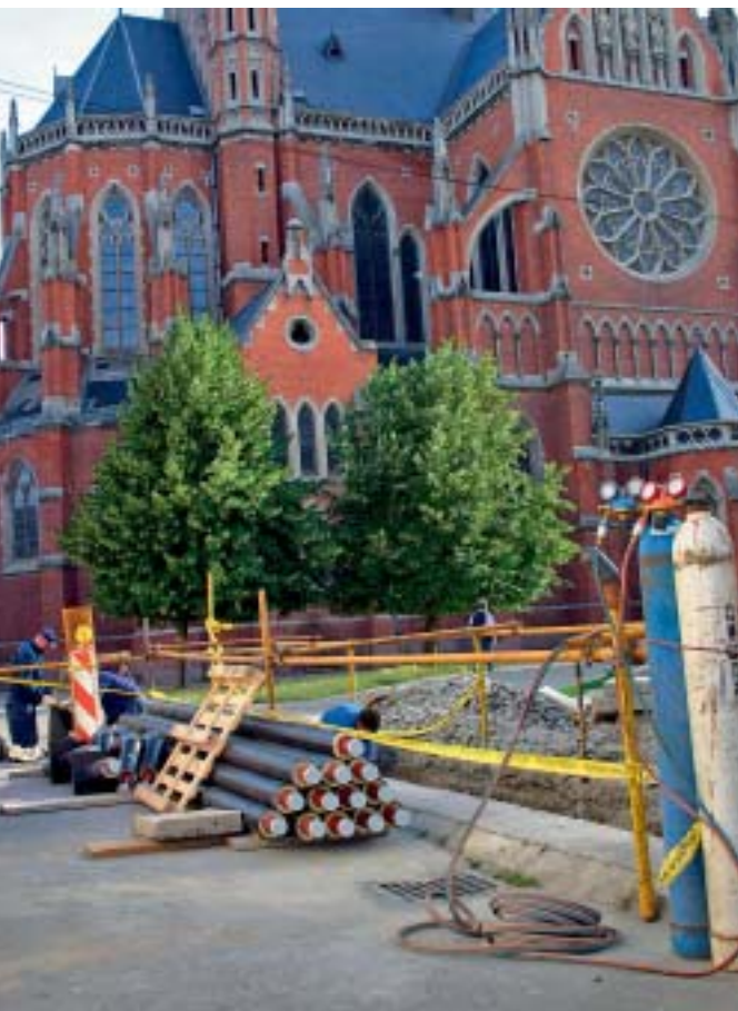
Radnici HEP Toplinarstva, Pogona Osijek, zamijenili su cijevi vrelovoda na Trgu Marina Držića
