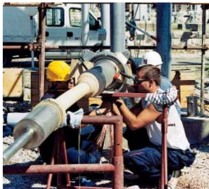
Navlači se defektor na kableski zac+vršetak
