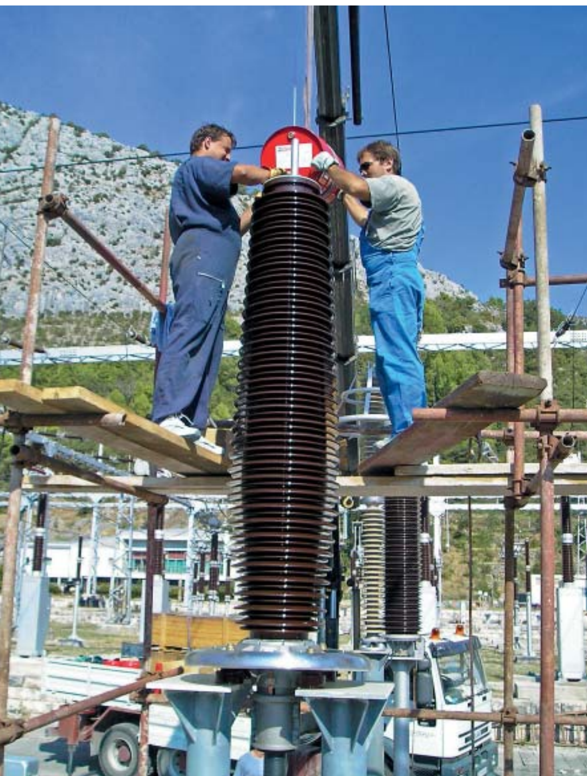
Zoran Krnčević i Boško Baščevan pri završnoj montaži vanjske glave 220 kV
