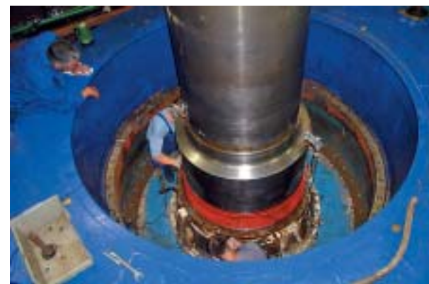
Demontaža turbinske brtve
