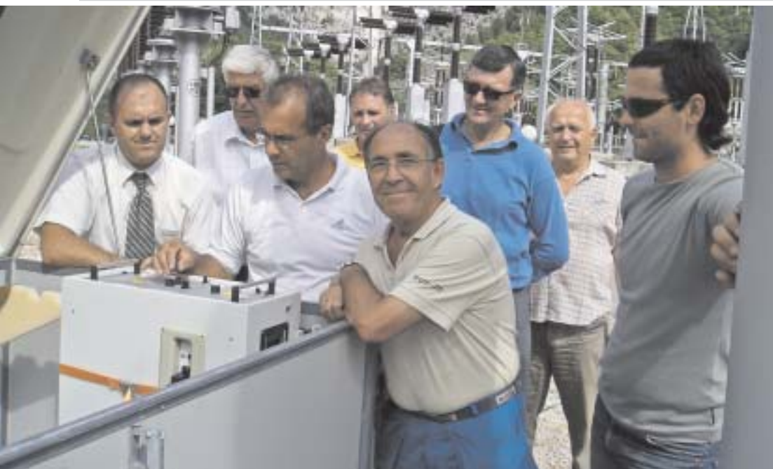
Predstavnici investitora, nadzora, izvođača radova i isporučitelja opreme prate završno ispitivanje kabela
