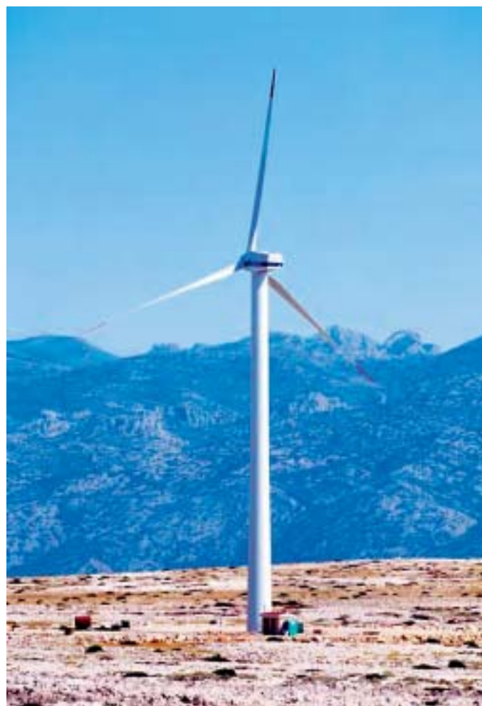
Mehanička montaža završena je za dva dana
