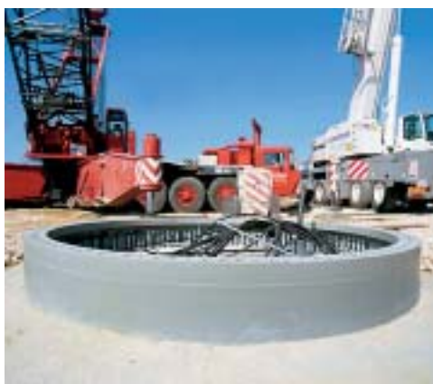
Pripremljen je temelj stupa
