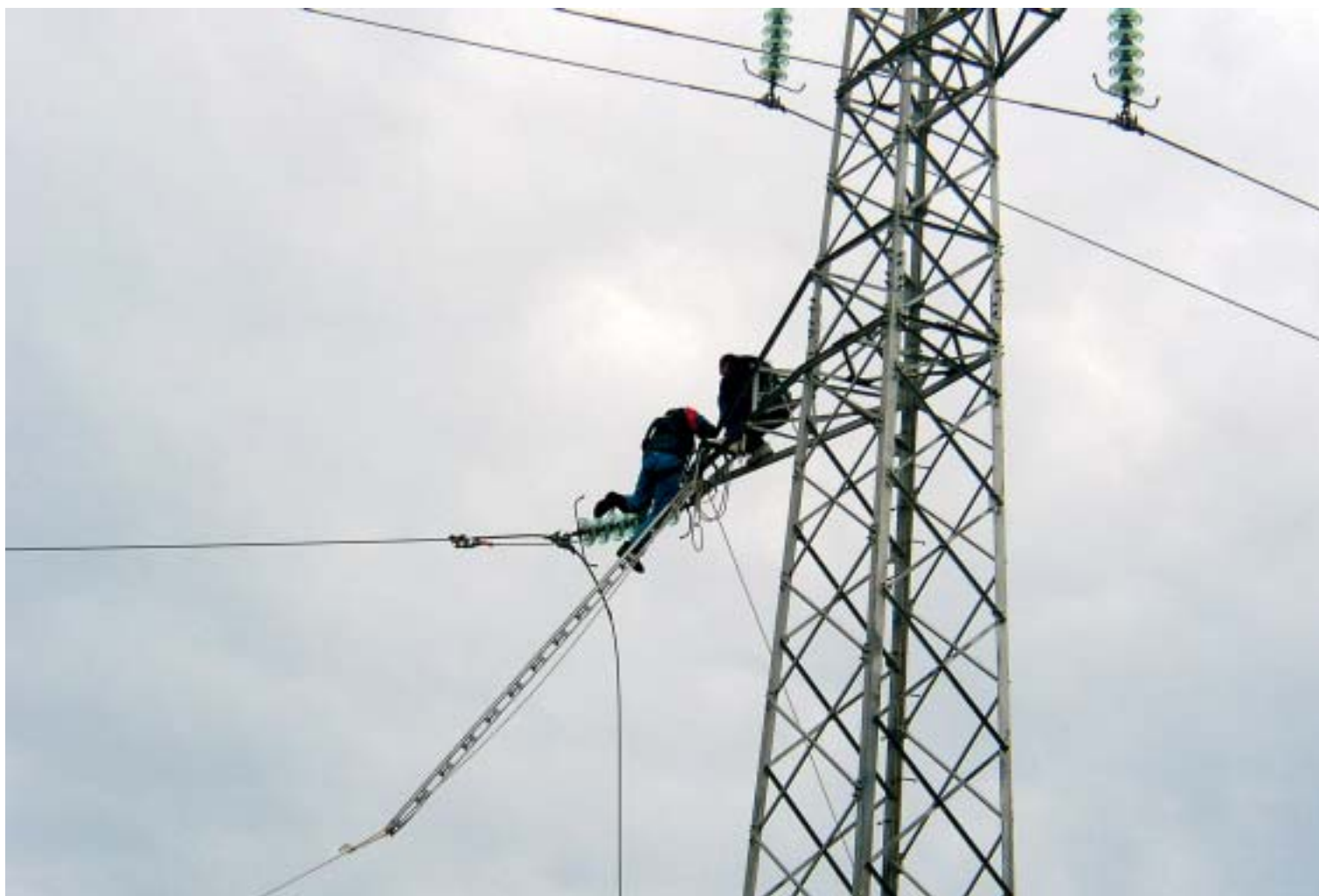
Radovi na DV 110/35 kV Obrovac - Seline koji je imao sreću u nesreći
