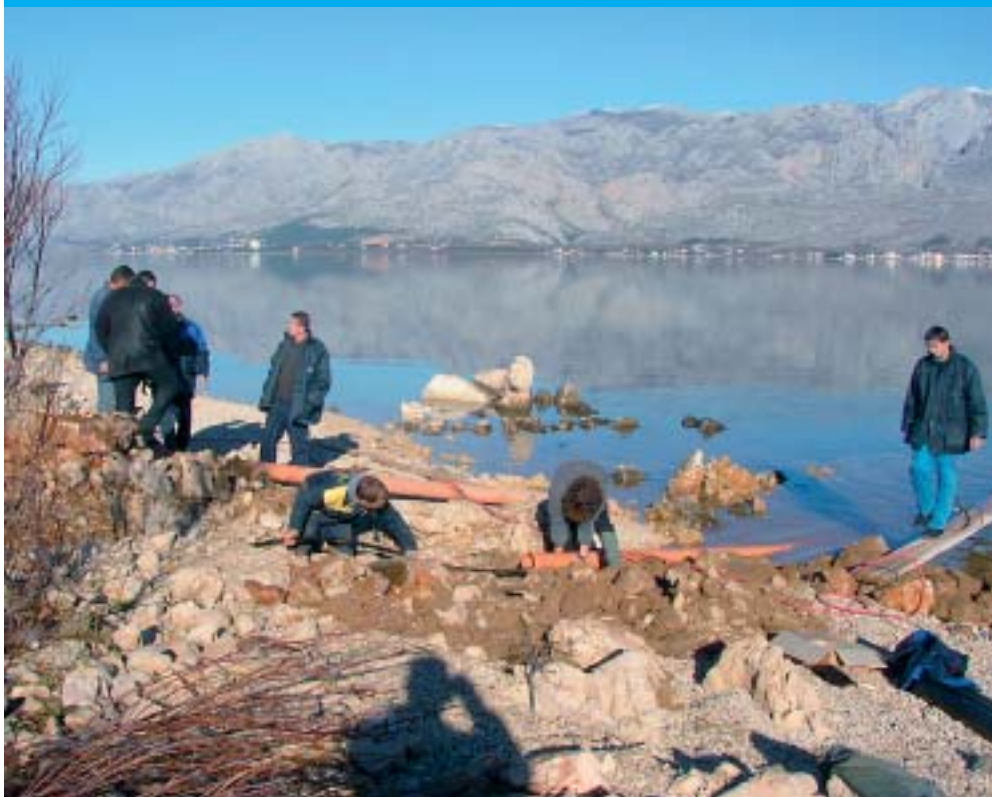
Pripreme za popravak podmorskoga kabela kod Vinjerca
