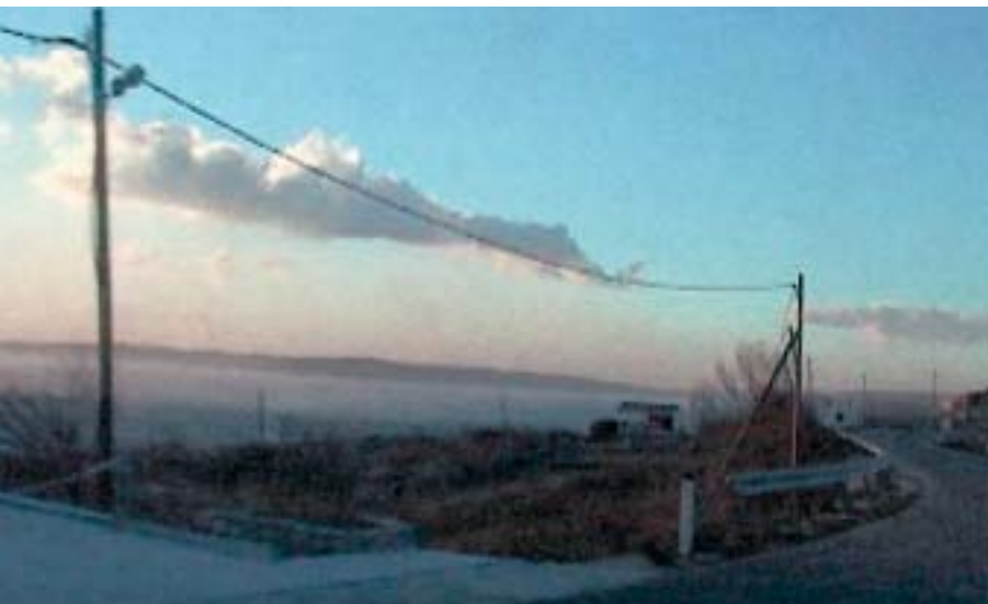
Pogled na samonosivi kabel pod udarima bure (otklon u drugom rasponu) ispod neizbježnog burnog oblaka nad Pagom
