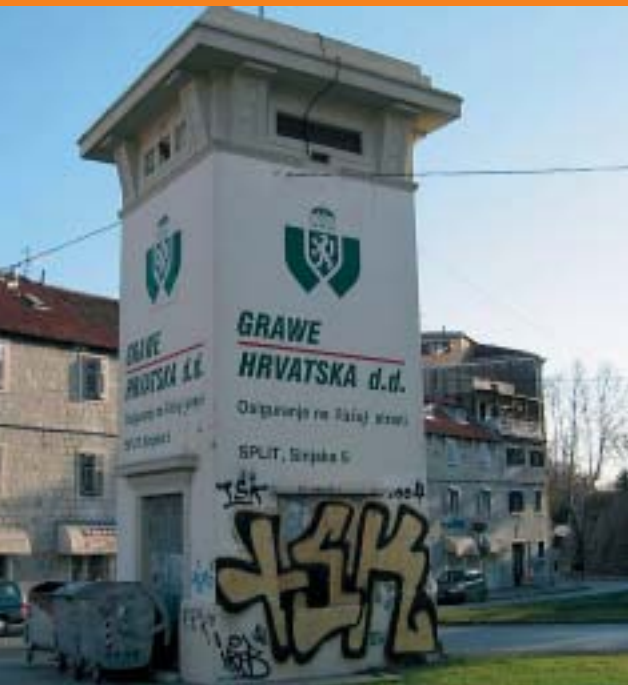
TS 10/0,4 kV "Manuš", građena 1920 god.
