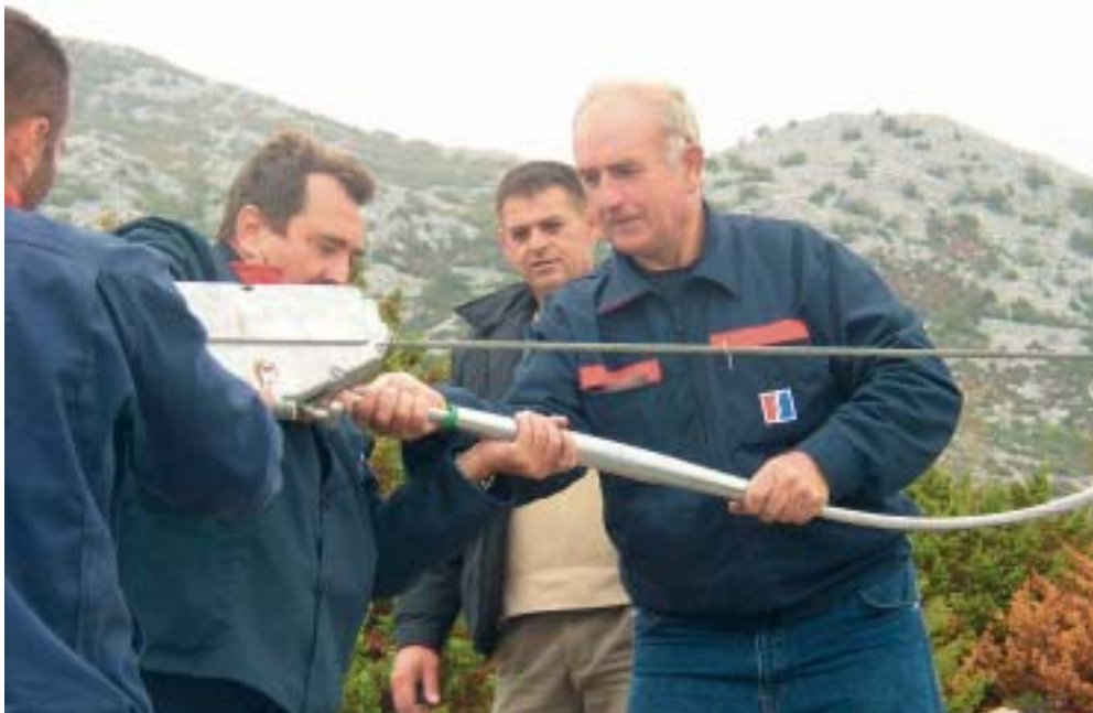
Zemno uže DV Obrovac - Seline bura je odbacila 50 metara dalje
