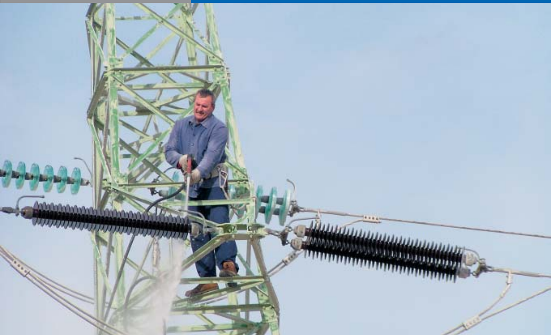
Rješenje - elektonter se popeo na stup i dobro oprao izolatore
