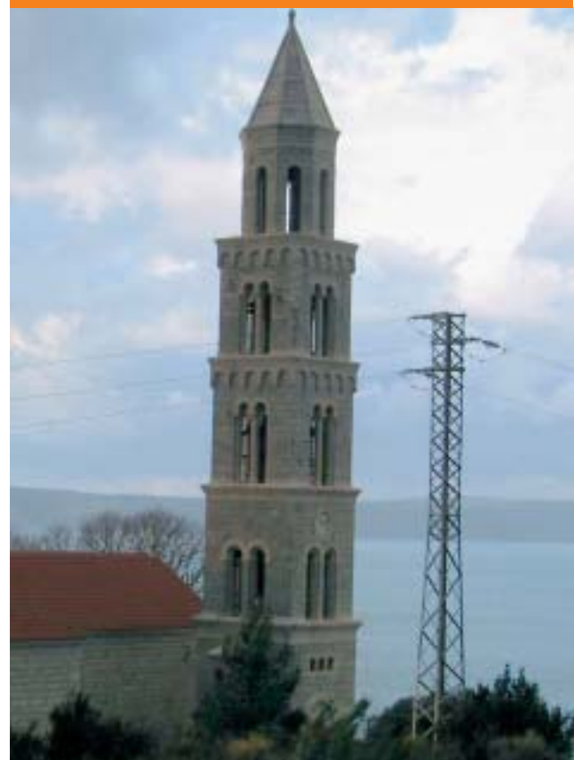
Dalekovodni stup uz zvonik crkve Gospe od Rožarija u mjestu Igrane
