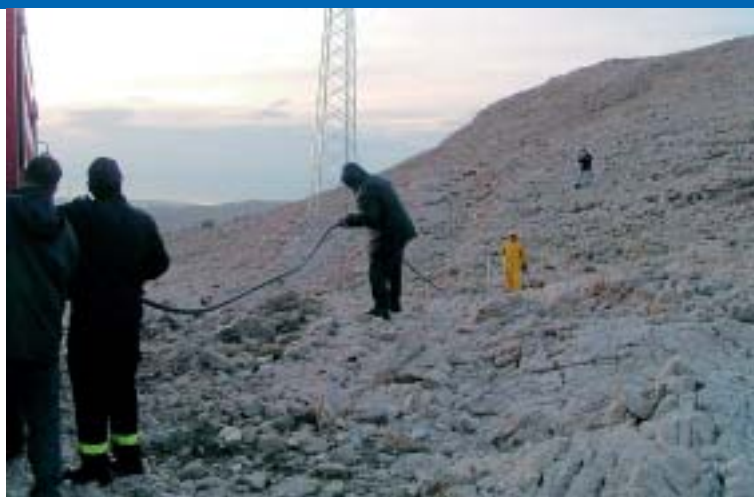
Izvor vode trebalo je što više približiti stupu
