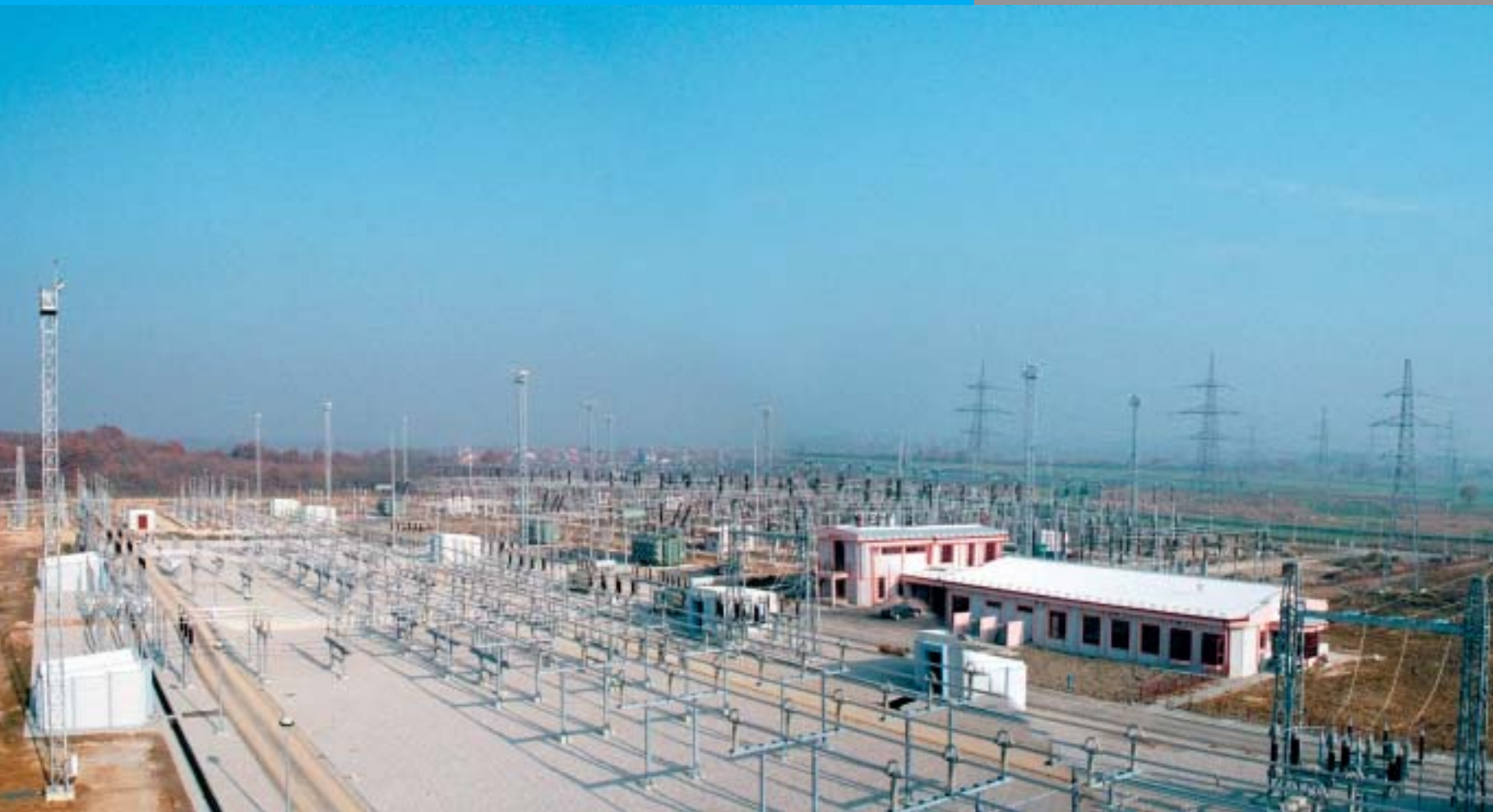
Gradilište TS Žerjavinec snimljeno krajem studenog 2003.
