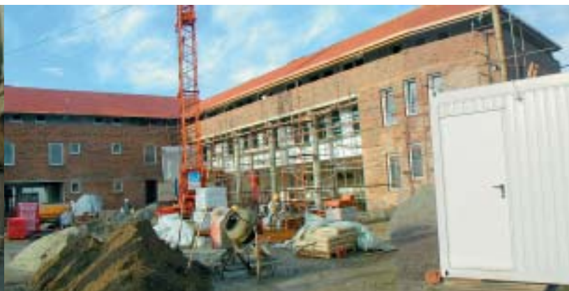
U tijeku je izgradnja poslovno-pogonske zgrade Pogona Vukovar
