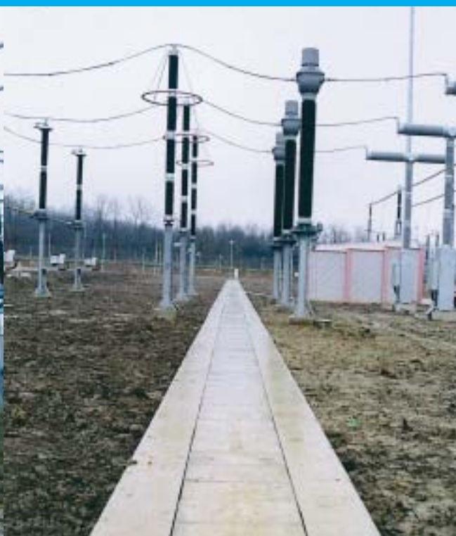
Pokriveni kabelski kanal u RP 400 kV
