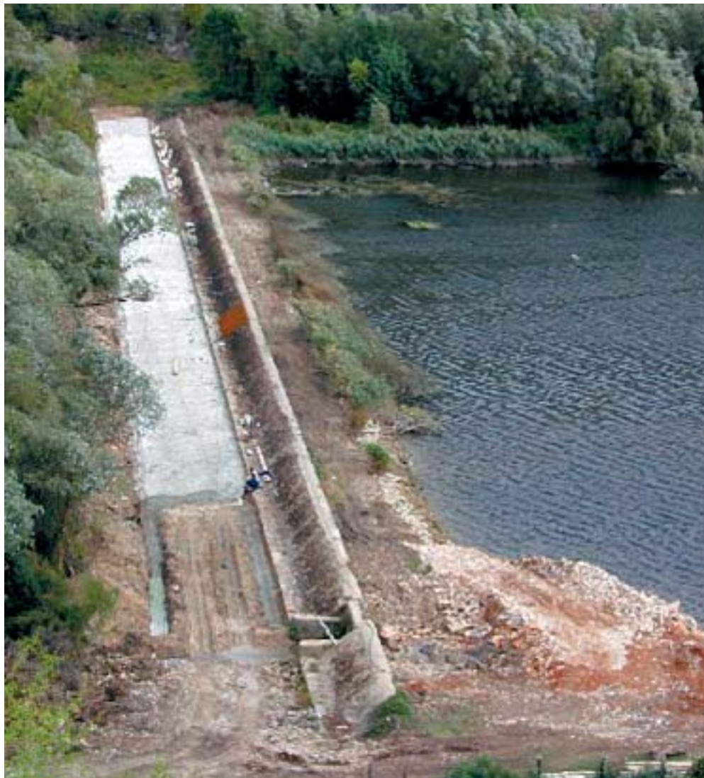
Sanacija brane Brljan HE Miljacka
