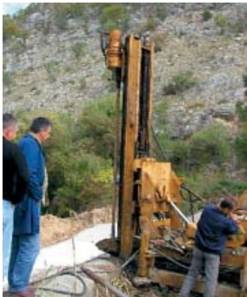
Pripremaju se rupe za injektiranje
